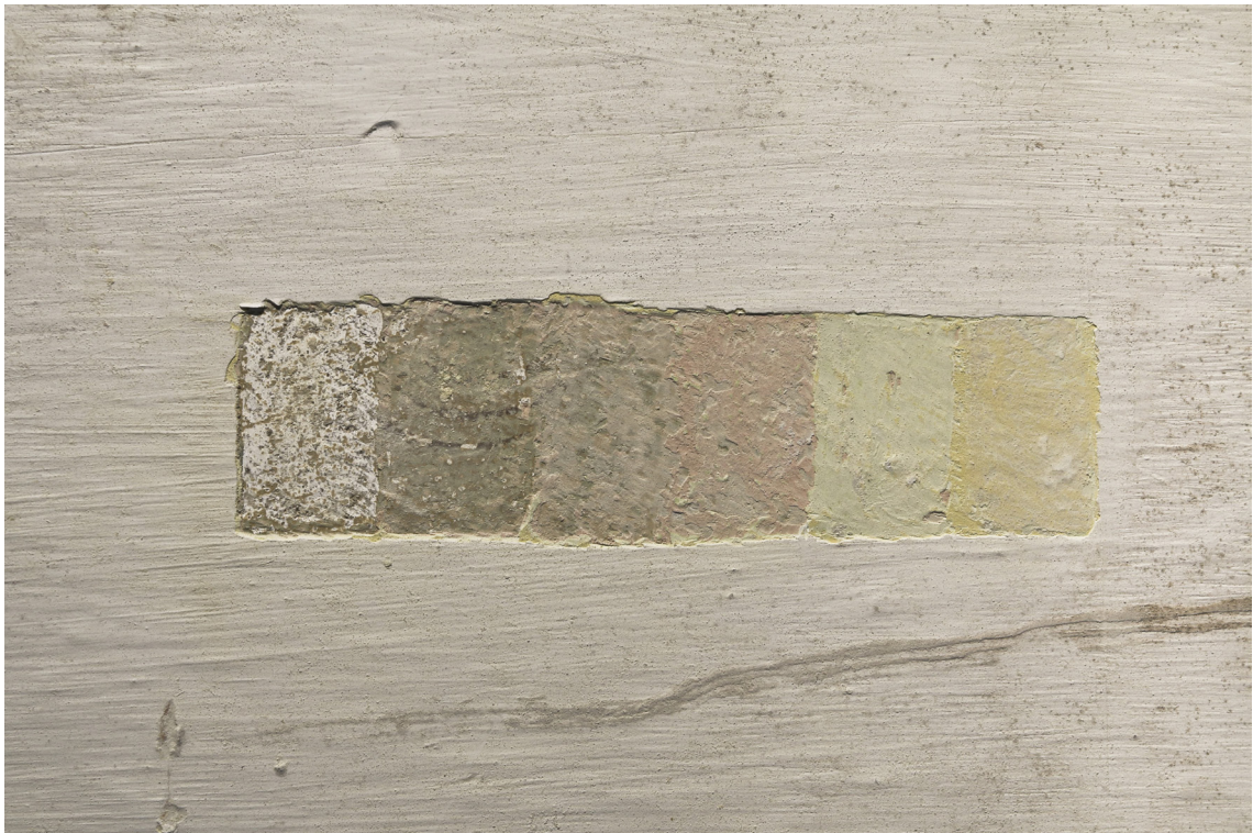
Obr. 31: Stratigrafický prieskum omietkových vrstiev.
