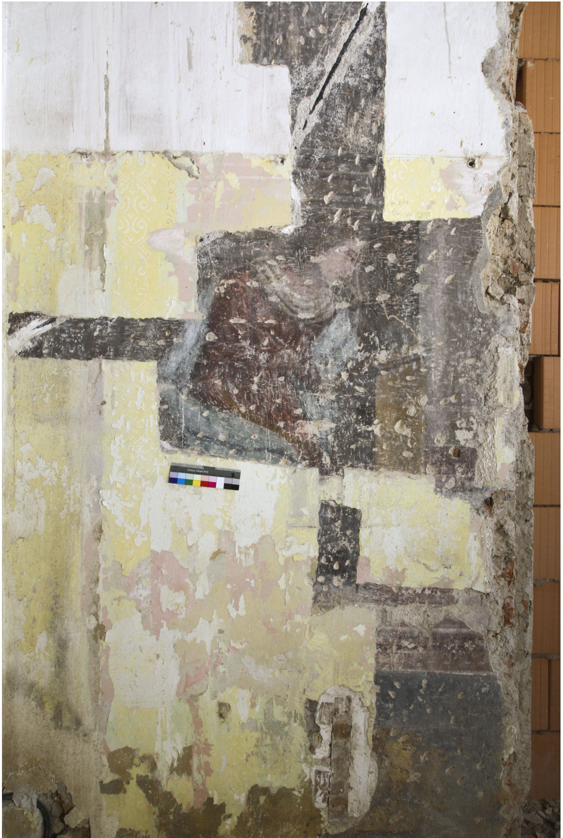
Obr. 14: Pohľad na reštaurovaný úsek. Na fotografii je vidieť sonda na konkrétnu vrstvu s Pannou Máriou z výjavu Zvestovanie . Stav pred reštaurovaním.
