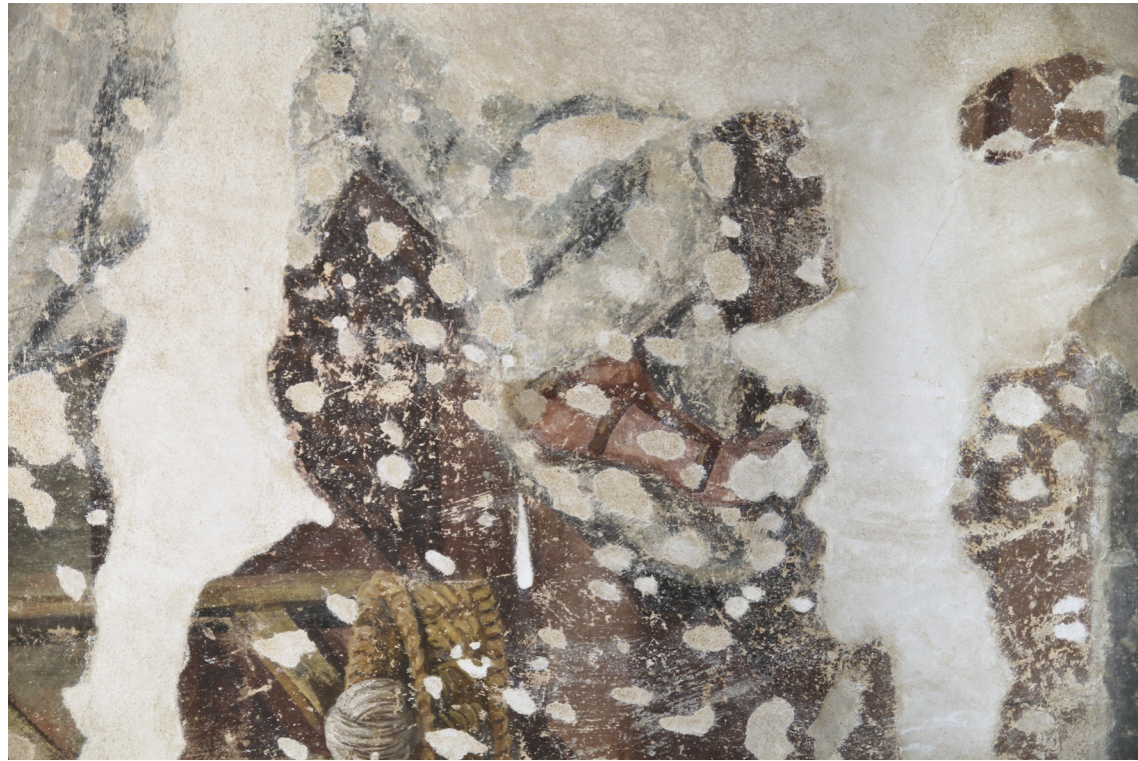
Obr. 46: Detail spodnej časti úseku. Stav po tmelení,
