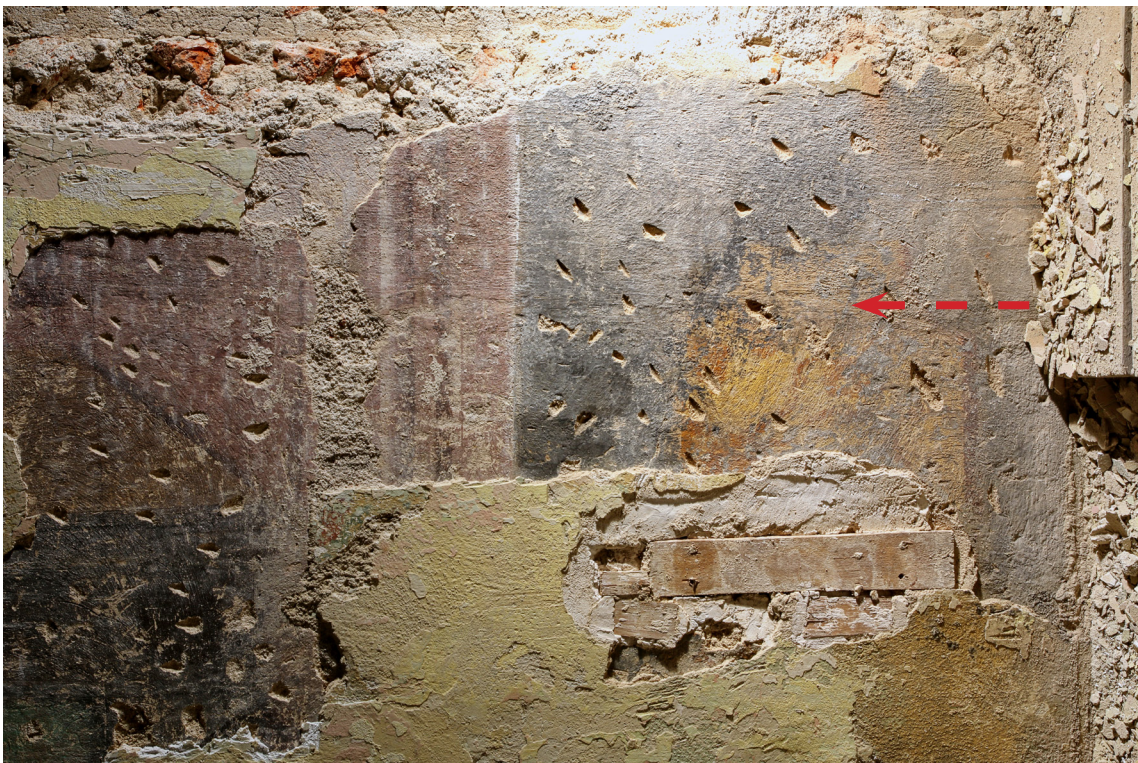
Obr. 26: Soklová časť v ostróm bočnom nasvietení. Červenou šípkou je vyznačené rozhranie dvoch omietkových vrstiev pri úprave dverného otvoru. Pozorovateľná šedá premalba v soklovej oblasti. Stav pred reštaurovaním.
