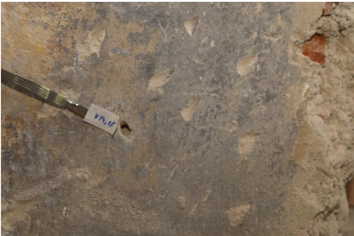
Obr. 47 Lokalizace odběru vzorků ke stanovení obsahů vodorozpustných solí V14, V15, detail.
