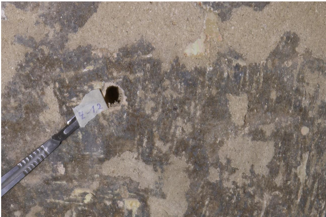
Obr. 41 Lokalizace odběru vzorků ke stanovení obsahů vlhkosti a vodorozpustných solí Z1, Z2, detail.
