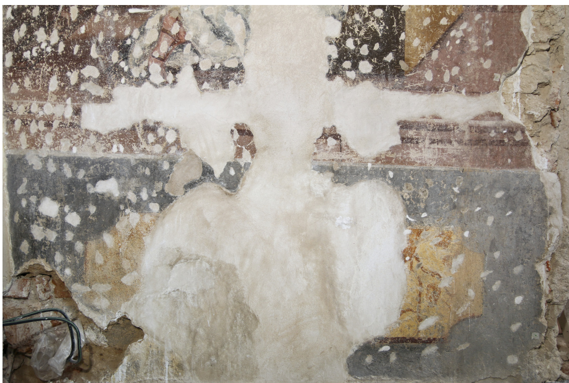
Obr. 49: Detail tmelu v soklovej časti. Stav po tmelení.
