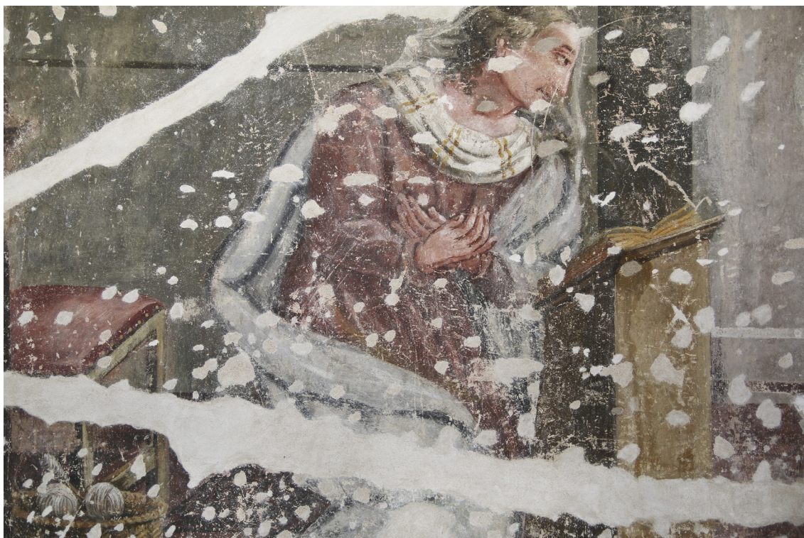
Obr. 48: Polocelok úseku s Pannou Máriou z výjavu Zvestovanie . Stav po tmelení.
