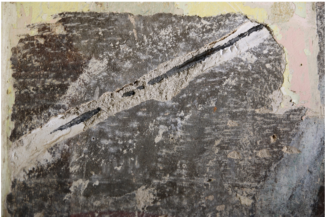
Obr. 16: Vedenie elektrifikácie, detail v sonde na konkrétnu vrstvu. Stav pred reštaurovaním.
