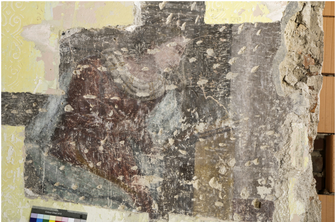
Obr. 23: Veľkoplošná sonda na konkrétnu vrstvu v rozptýlenom dennom svetle. Zvyšok maľby je ukrytý pod druhotnými vrstvami. Stav pred reštaurovaním.
