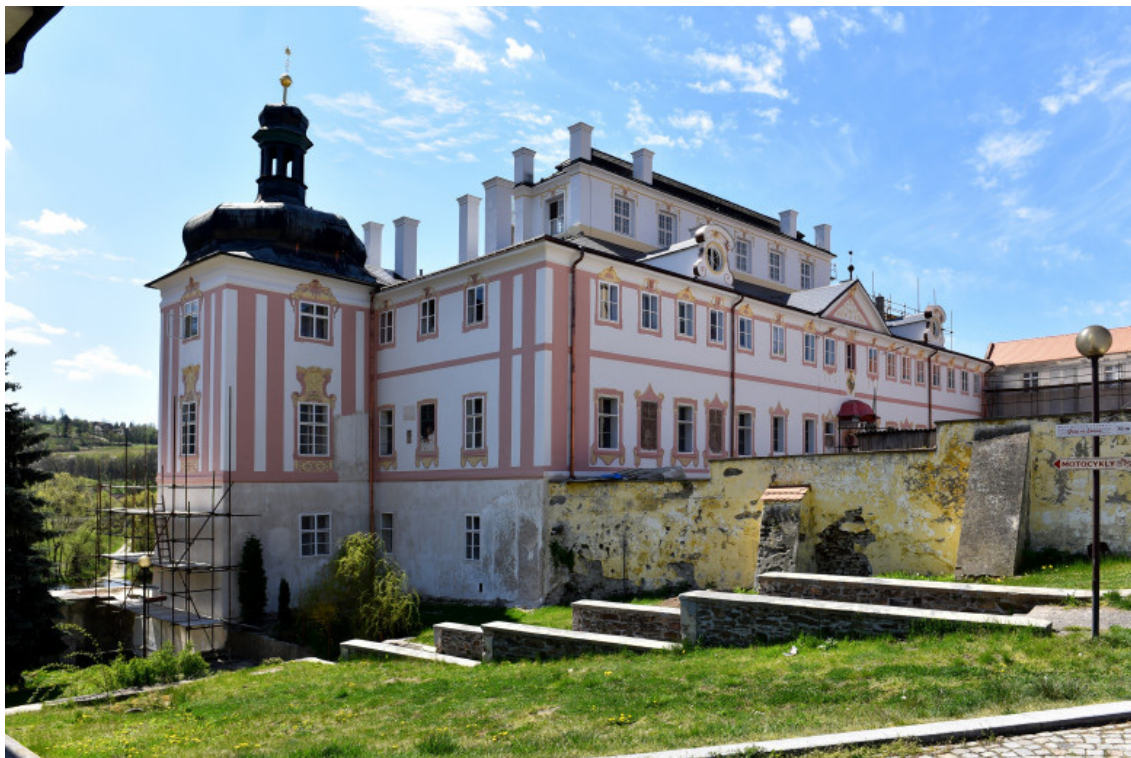
Obr. 01: Pohľad na zámok Kácov po rekonštrukcii v roku 2020. Foto dostupné z: https://www.zamek-kacov.cz/ .
