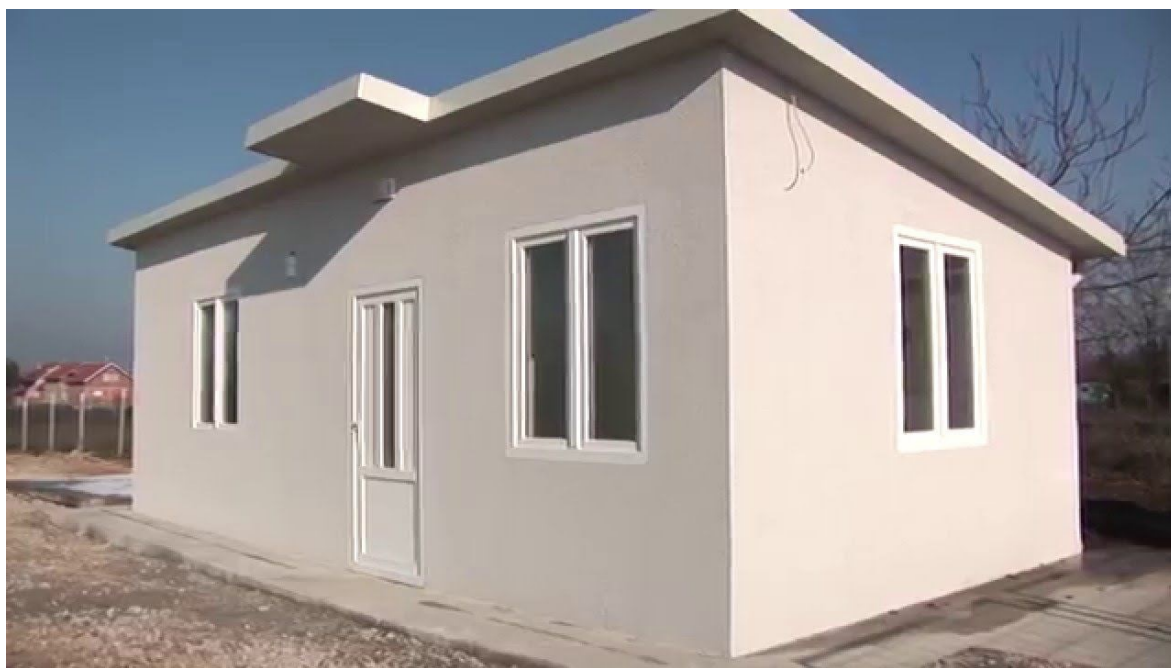
Obr. 12: Pěnobetonový dům postavený za šest dní [15]
