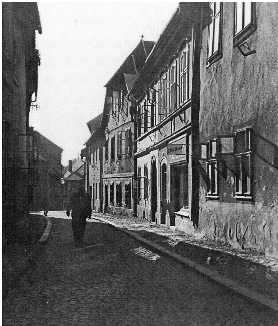
Obr. 3. Chrudim, Filištínská ulice. Průhled Filištínskou ulicí v roce 1959. Dům č. p. 39/I je čtvrtý na pravé straně (převyšuje oba sousedy). SÚPP č. 85107.
