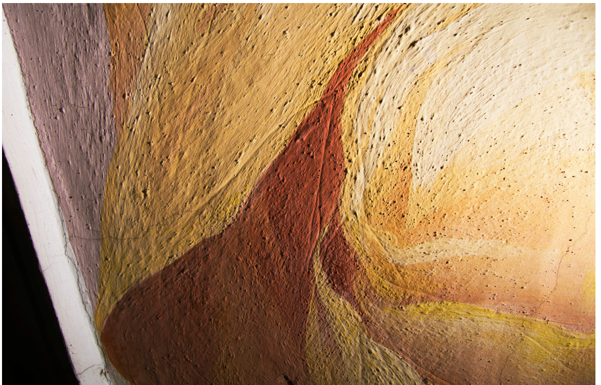
Obr. 19: Spodní část výjevu Zdraví v ostrém bočním nasvícení. Zvýraznění omítky s vytaženým zrnem, ryté kresby a poškození výjevu. Stav před restaurováním.
