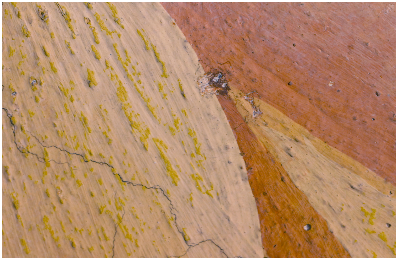
Obr. 08: Detail fotografie zobrazující dokončení malby suchým pastelem žluté barevnosti při původní realizaci nástěnné malby. Stav před restaurováním.
