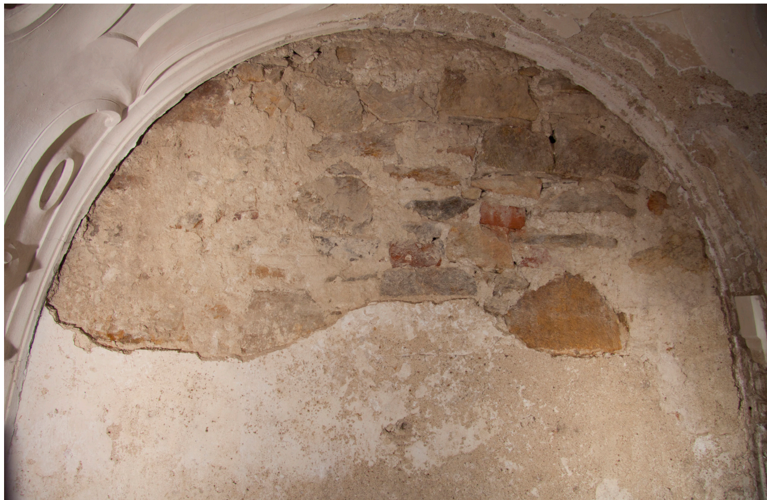
Obr. 41: Odstranění nepůvodních vrstev nátěrů a rozvolněných omítkových vrstev v přidělené lunetě severní stěny. Stav po očištění.
