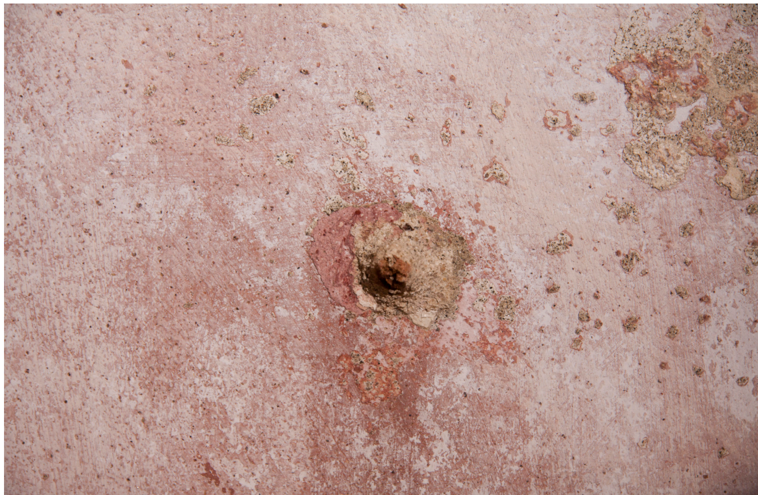
Obr. 17: Hlubší defekt mechanické povahy v lunetě východně od výjevu Zdraví . Stav před restaurováním.
