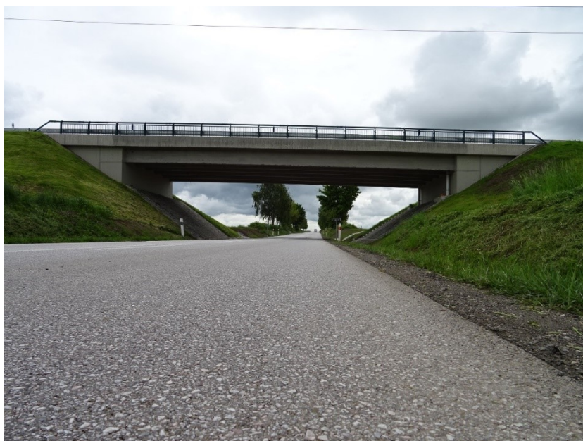
Obr. 19 - Pohled na dokončený most – stávající stav (Valbek spol. s r.o.)
