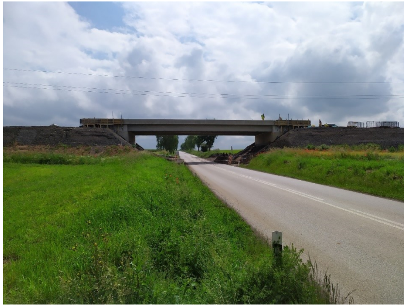
Obr. 17 - Pohled na výstavbu SO203 (Valbek spol. s r.o.)
