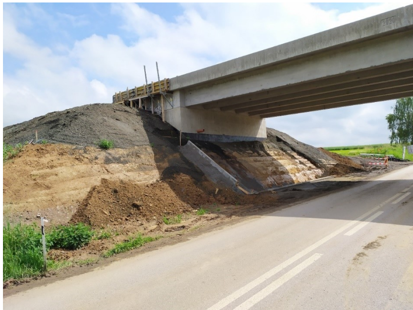
Obr. 18 - Pohled na OP01 během výstavby (Valbek spol. s r.o.)
