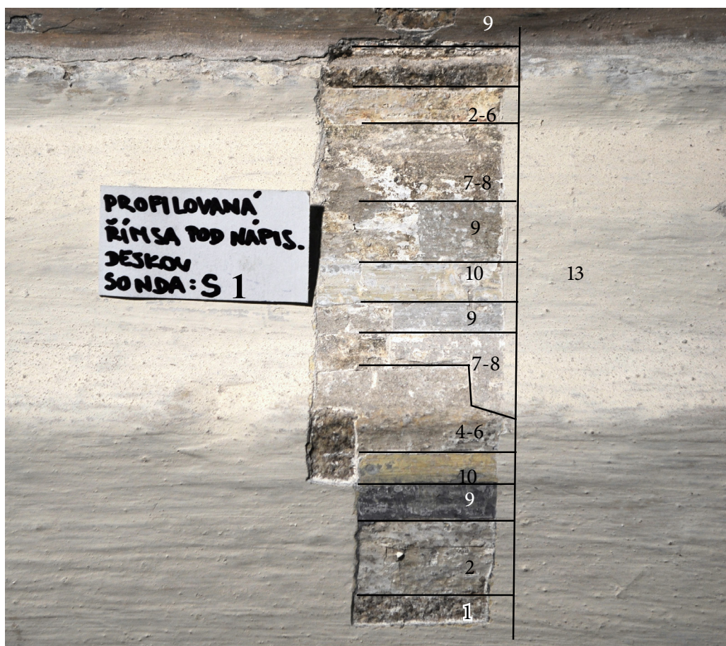
Obr. 08 Fotografia sondy na rímse pod nápisovou doskou s označením poradia vrstiev, ktoré na danom mieste bolo možné odhaliť..
