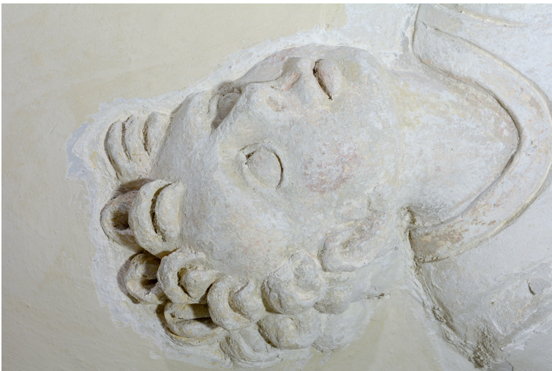
Obr. 33 Stav: priebeh odstraňovania. Hlava anjela. Ukončené hrubé odstránenie druhotných vrstiev a začiatok odstraňovania súdržných vápenných vrstiev pomocou namáččovania a odstraňovania skalpelom alebo ultrazvukovou špachtľou.
