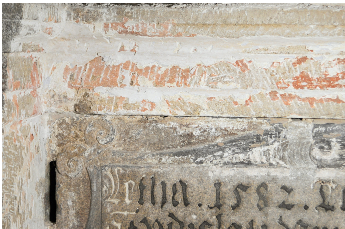
Obr. 29 Odstraňovanie druhotných vrstiev pomocou reštaurátorských kladiviek na hornej rímse soklovej partie.
