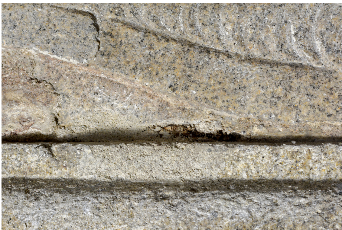
Obr. 78 Tmelenie hrany dolnej rímsy pod nápisovou doskou.
