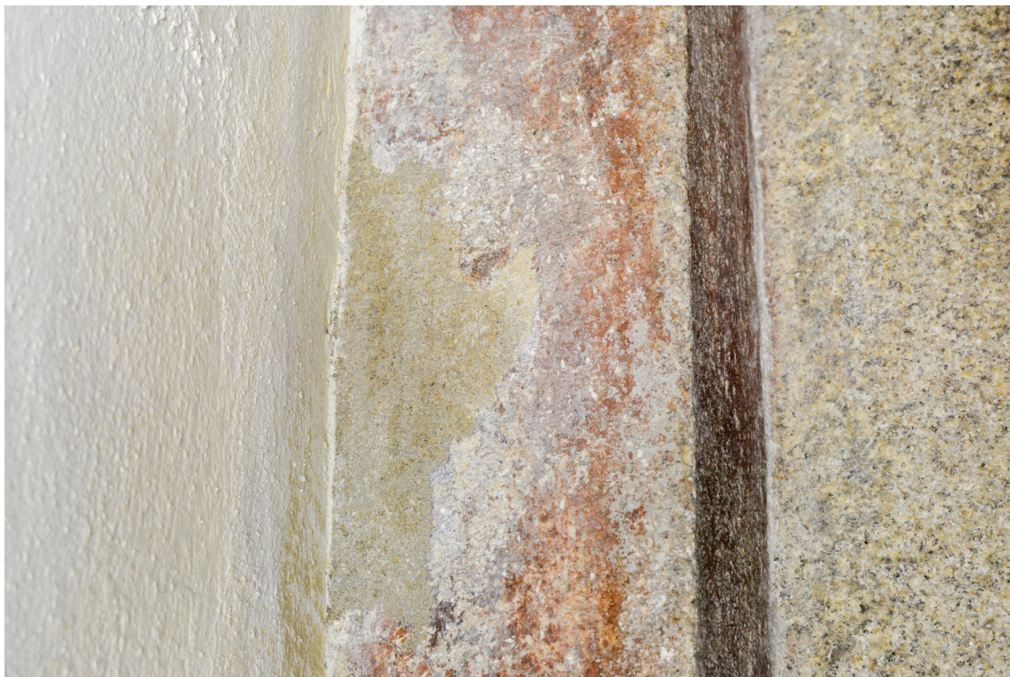
Obr. 77 Tmelenie poškodených častí žulovej architektúry, konkrétne ľavého podstavca.
