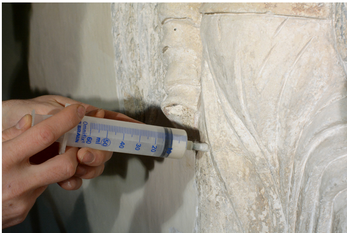
Obr. 75 Proces injektovania dutín a prasklín injektážnou zmesou PLM-A a mramorovej múčky v úrovni pravej nohy ľavého anjela. Stav po odstránení druhotných vrstiev.
