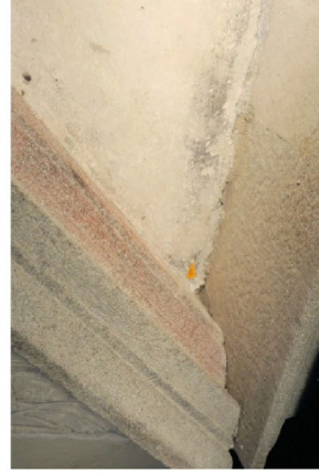
Obr. 17: Detail místa odběru vzorku V17 pro chemicko-technologický průzkum: Tympanon, pozadí Boha Otce, levý dolní roh, oranžové pozadí s vrstvou nečistot nebo přemalbou.
