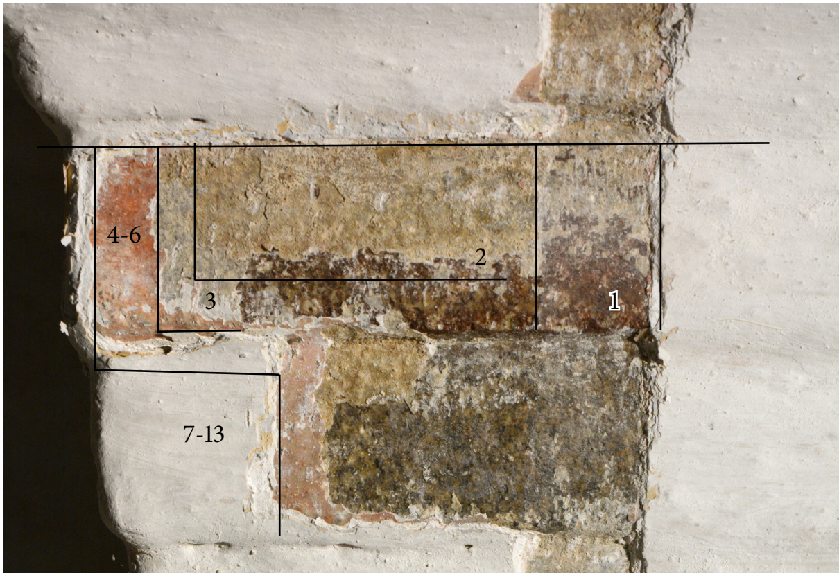
Obr. 06 Fotografia sondy na ľavom podstavci s označením poradia vrstiev, ktoré na danom mieste bolo možné odhaliť.
