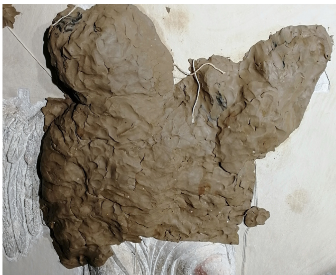
Obr. 16 Nanesená vrstva hlíny na originálnej štukovej profilácii anjela. Separovaná bola mletým mastkom a hlinu bolo potrebné v tomto rozmere deliť na 3 časti konopným motúzom pre jednoduchšie sňatie z originálu bez nechceného ohybu vrstvy hlíny.
