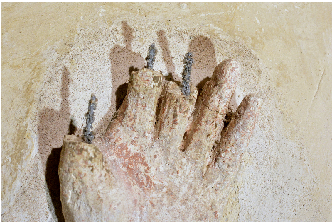
Obr. 83 Prevedenie druhotnej armatúry v ľavej ruke a alkytonu posypaného zrnami kopaného piesku, ktoré následne slúžili ako spojovacie mostíky pre modelačnú vrstvu šuku.
