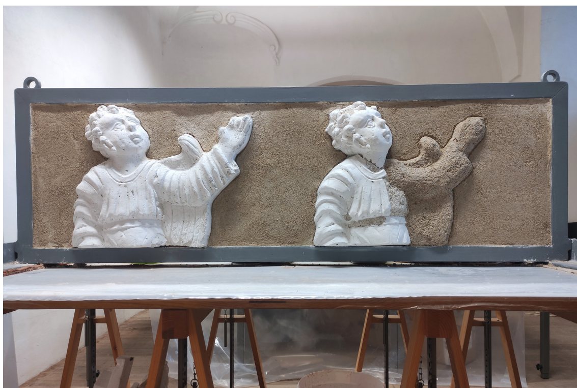
Obr. 109 Výsledné prevedenie štukových profilácií s pripraveným podkladom z jadrovej omietky pre naniesenie modelačnej vrstvy.
