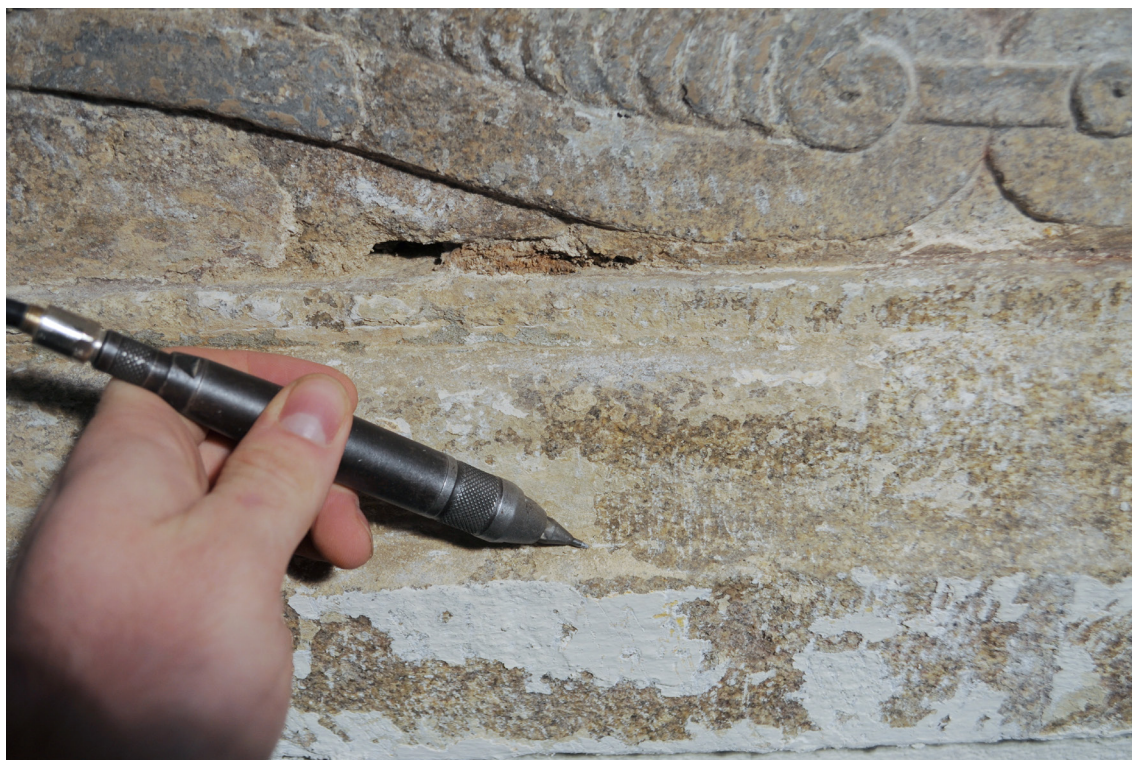
Obr.30 Priebeg odstraňovania tenších súdržnejších vrstiev vápenného náteru na žulovom podklade dolnej rímky pod nápisovou doskou. Použitie pneumatického mikrovibračného pera.
