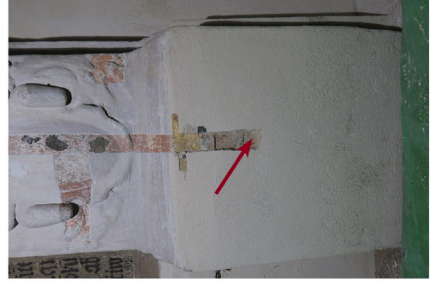
Obr. 7: Detail místa odběru vzorku V7. Zděný sokl pod erbem Rosiny z Vartenberka, opravná malta na cihlovém zdivu.
