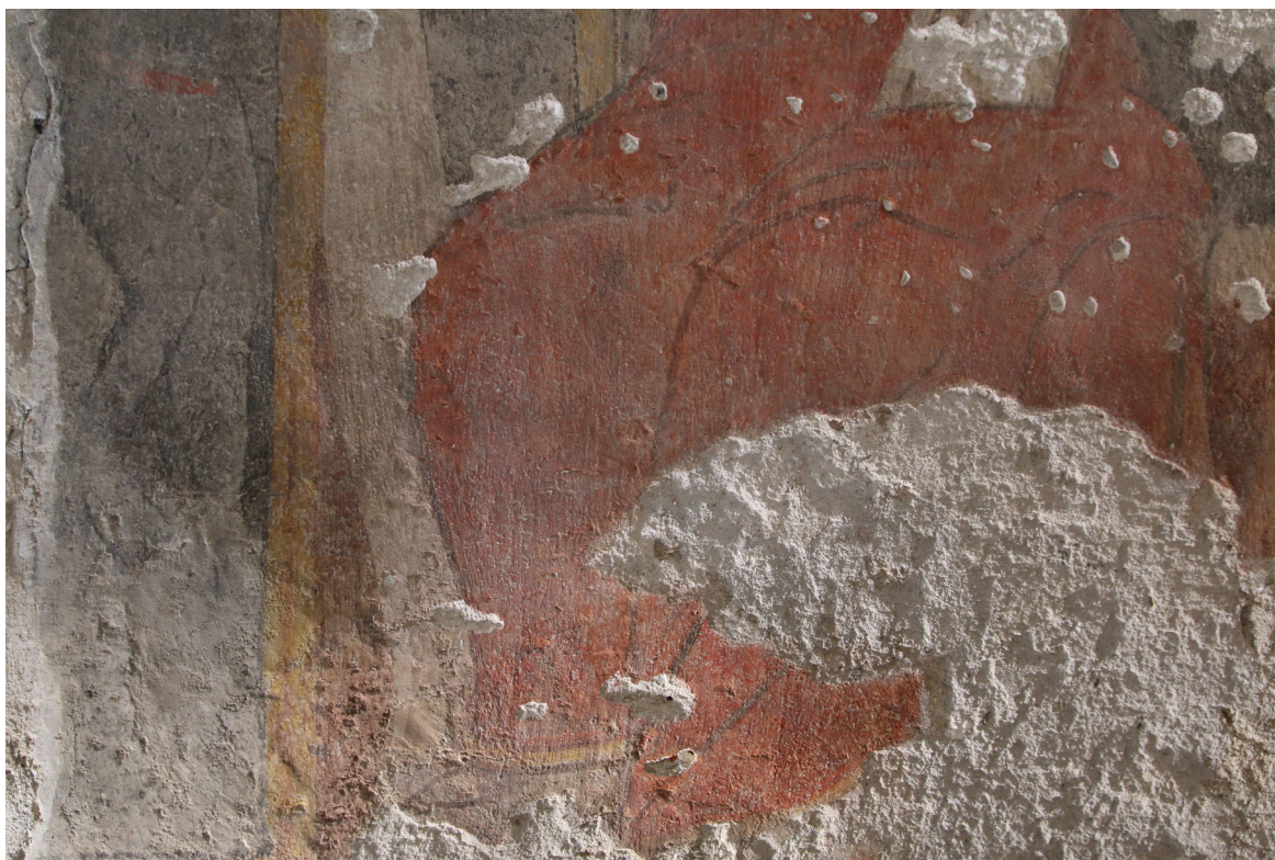
Obr. 29: Detail poškození původní barevné vrstvy v oblasti šatů figury Geometrie v horní části restaurovaného úseku. Fotografie v ostrém bočním nasvícení. Stav po odstranění druhotných tmelů.
