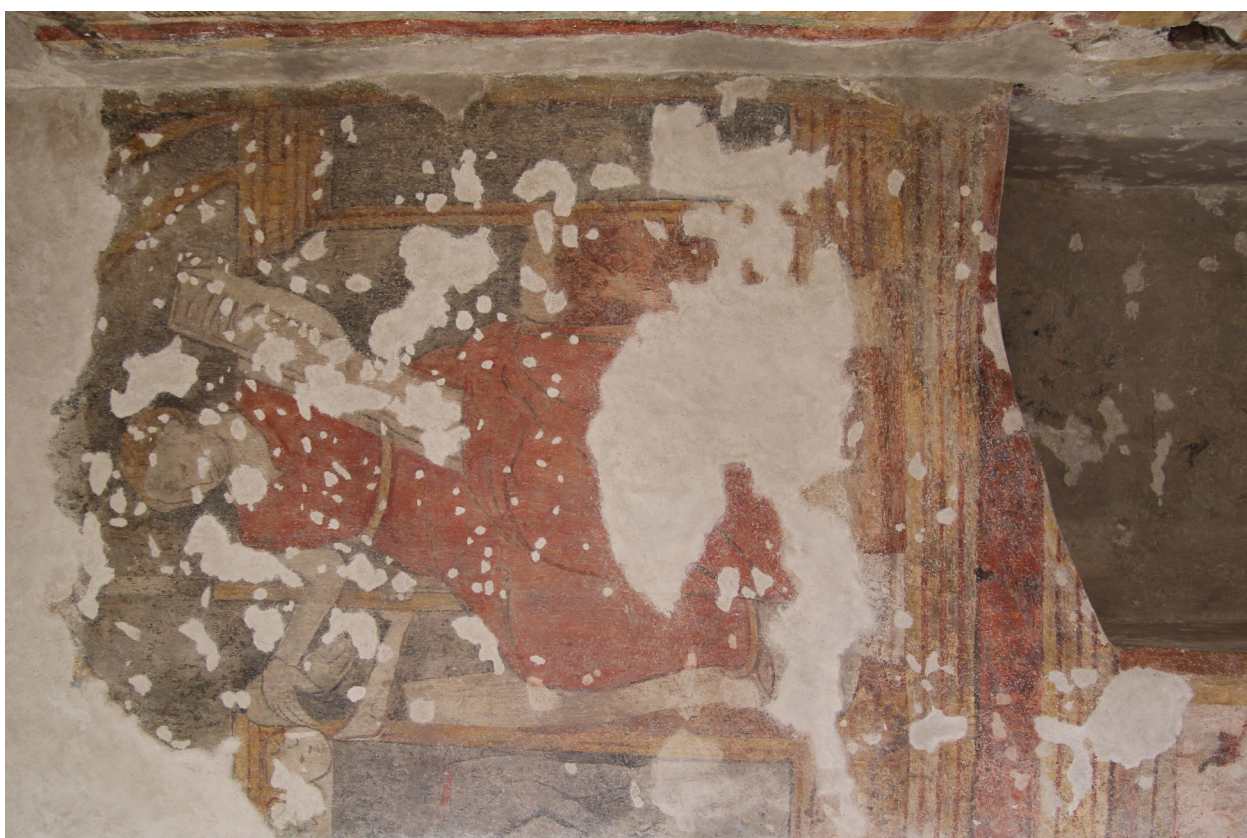
Obr. 60: Pohled na horní část restaurovaného úseku. Stav po vytmělení.
