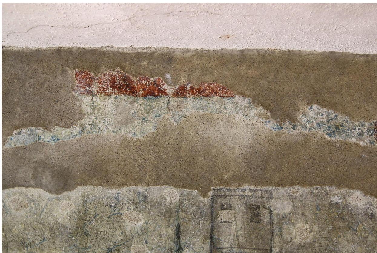
Obr. 41: Stav po spevnení fragmentov, odstránení prekryvných náterov a v priebehu tmelenia okolia (nanesená jadrová omietka).
