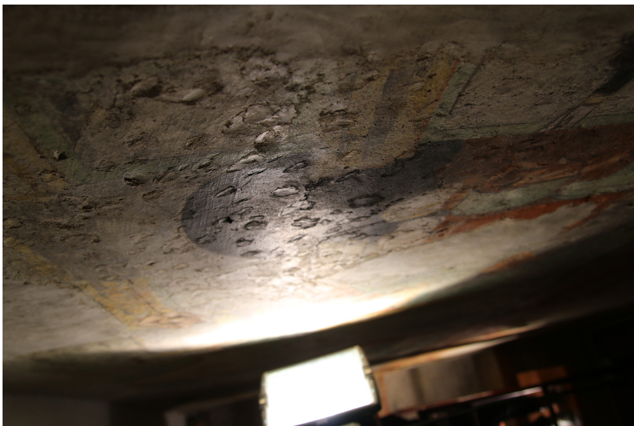
Obr. 41: Při ostrém bočním nasvícení malba vykazovala lesklý povrch. Stav před restaurováním.
