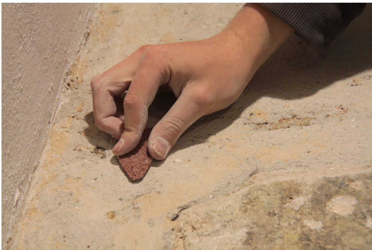
Obr. 47: Redukce druhotných vápenných a cementových tmelů pod úroveň originální omítky pomocí brusných kamenů.
