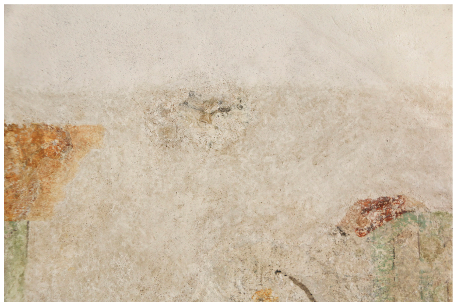
Obr. 70: Sekvence fotografií. Zapojení originálního fragmentu ve velkoplošném tmelu v pravém horním rohu neutrální retuší. Stav před restaurováním, po odstranění vápenného tmelu a redukování cementového jádra a závěrečná retuš.
