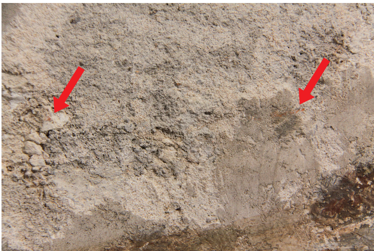
Obr. 58: Původní omítkové vrstvy s fragmentálně dochovanou originální barevnou vrstvou. Je možné pozorovat fragmenty oranžové linie naznačující konec šedého pláště postavy Ježíše Krista. Oblast v levé dolní části výjevu. Stav v průběhu odstraňování druhotných tmelů.
