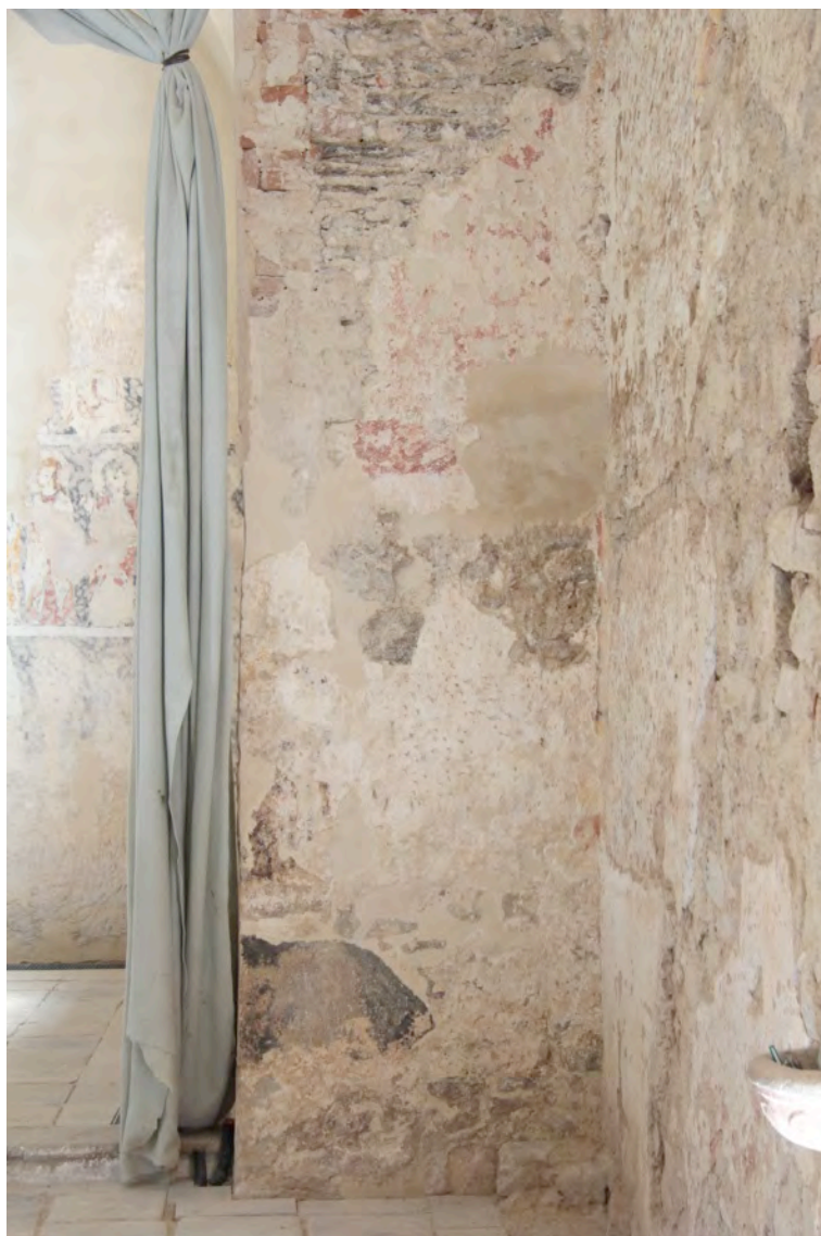
Obr. č. 138 Prává strana vítězného oblouku, stav po restaurování.
