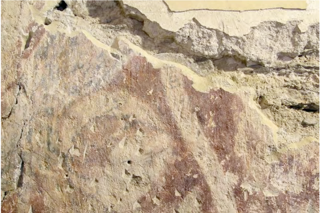
Obr. č. 112 Konzervační tmely na okrajích středověké omítky.
