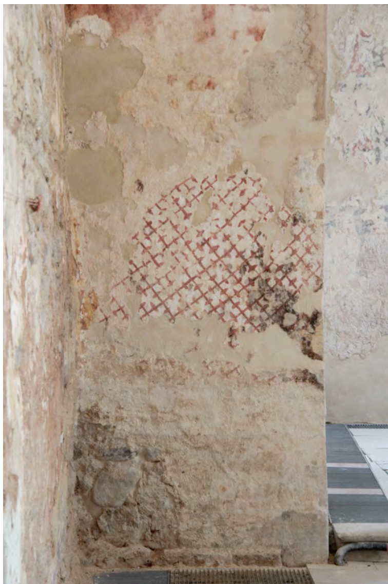
Obr. č. 134 Dolní část levé strany vítězného oblouku, stav po restaurování.
