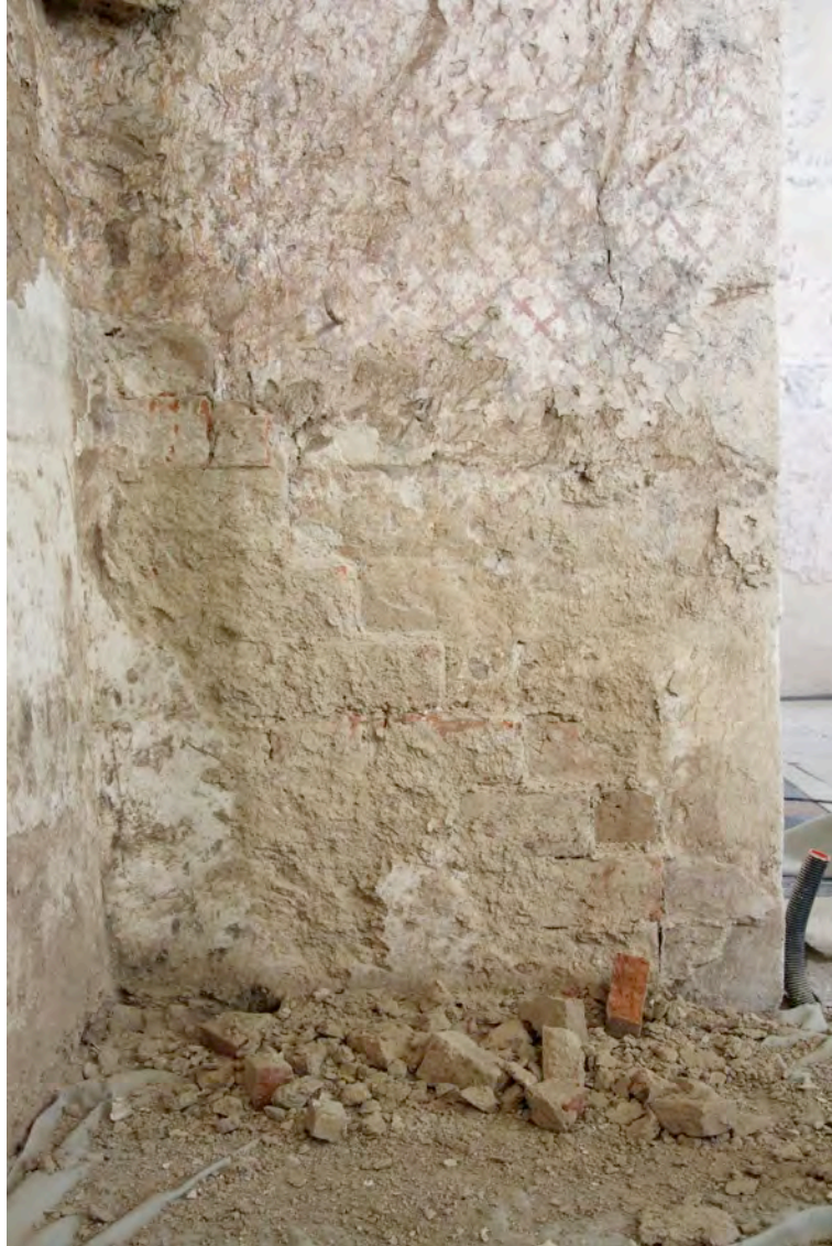
Obr. č. 106 Odstraňování plenty na levé straně vítězného oblouku.
