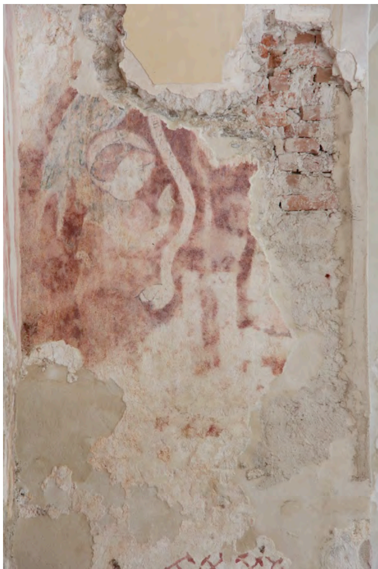
Obr. č. 133 Horní část levé strany vítězného oblouku, stav po restaurování.
