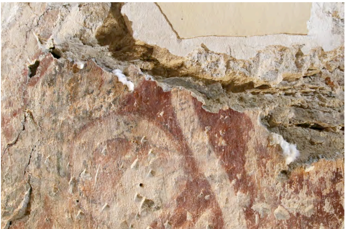
Obr. č. 110 Mechanické odstraňování tmelů z let 1976 a 1984 kombinované s hloubkovou injektáží.
