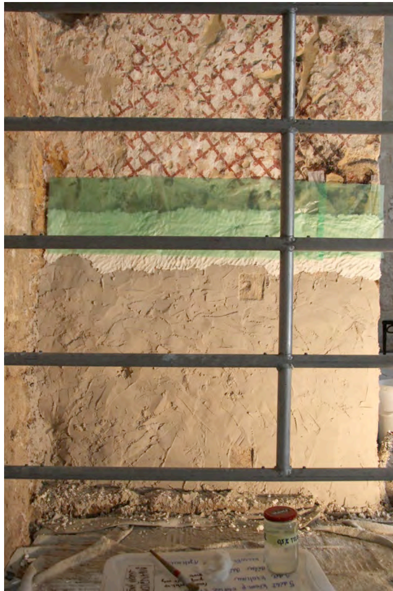
Obr. č. 114 Odsolovací zábal.
