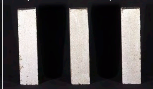
Grafický záznam eflorescence solí a poškození
