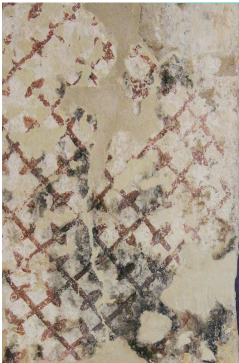
Obr. č. 122 Detail křížového dekoru, stav po vytmelení.
