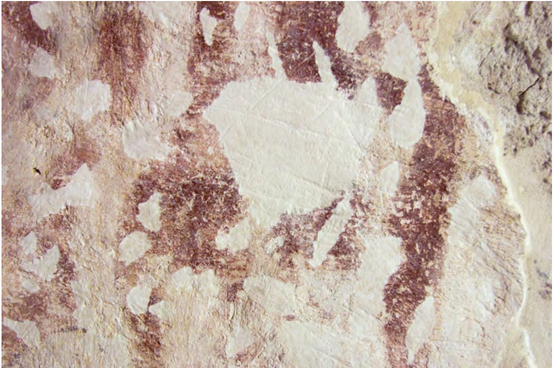
Obr. č. 124 Detail pulpitu, stav po vytmelení.
