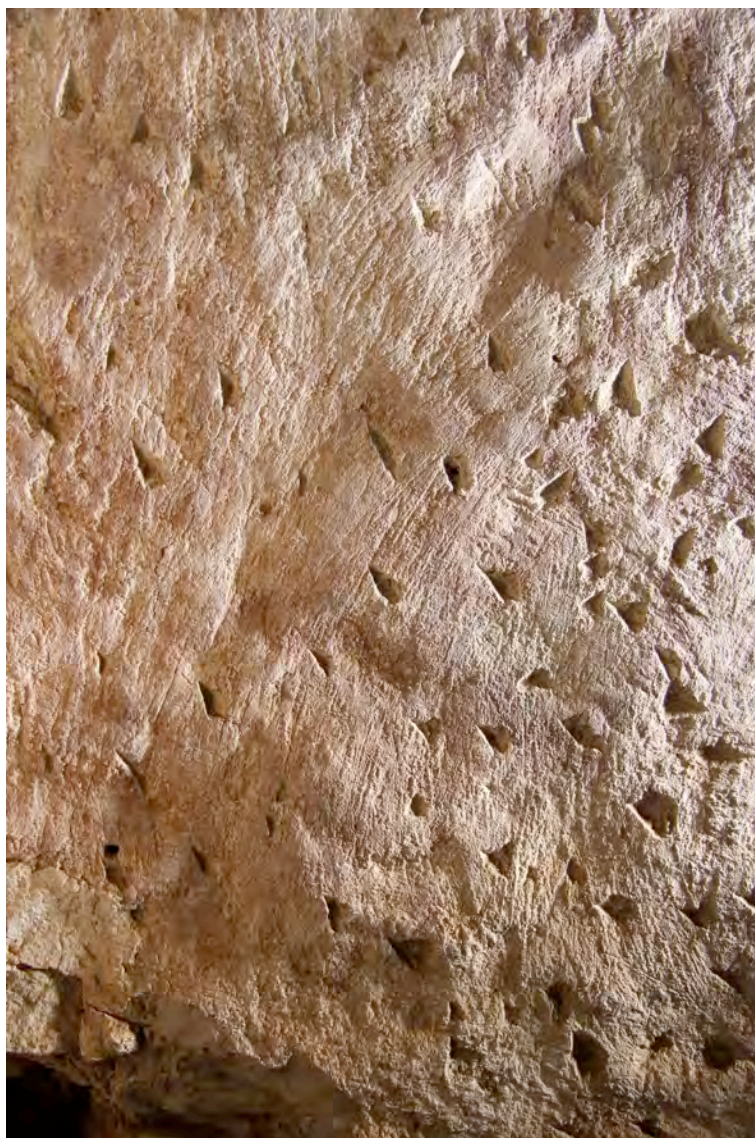
Obr. č. 99 Tělo a ruce archanděla Gabriela, stav před restaurováním, razantní boční osvětlení. Na snímku jsou zřetelně pozorovatelné nerovnosti na povrchu omítky, která kopíruje nerovnosti kamenného zdiva. Povrchová struktura omítky nese stopy nástroje -hrubé štětky.
