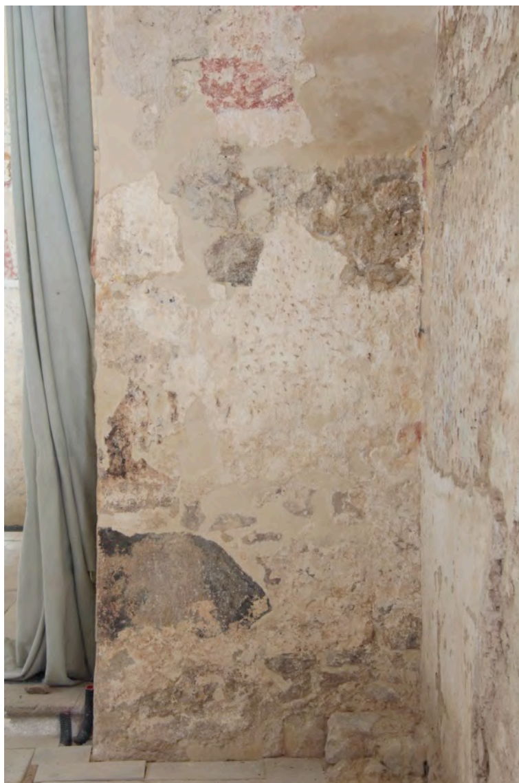
Obr. č. 136 Dolní část pravé strany vítězného oblouku, stav po restaurování.
