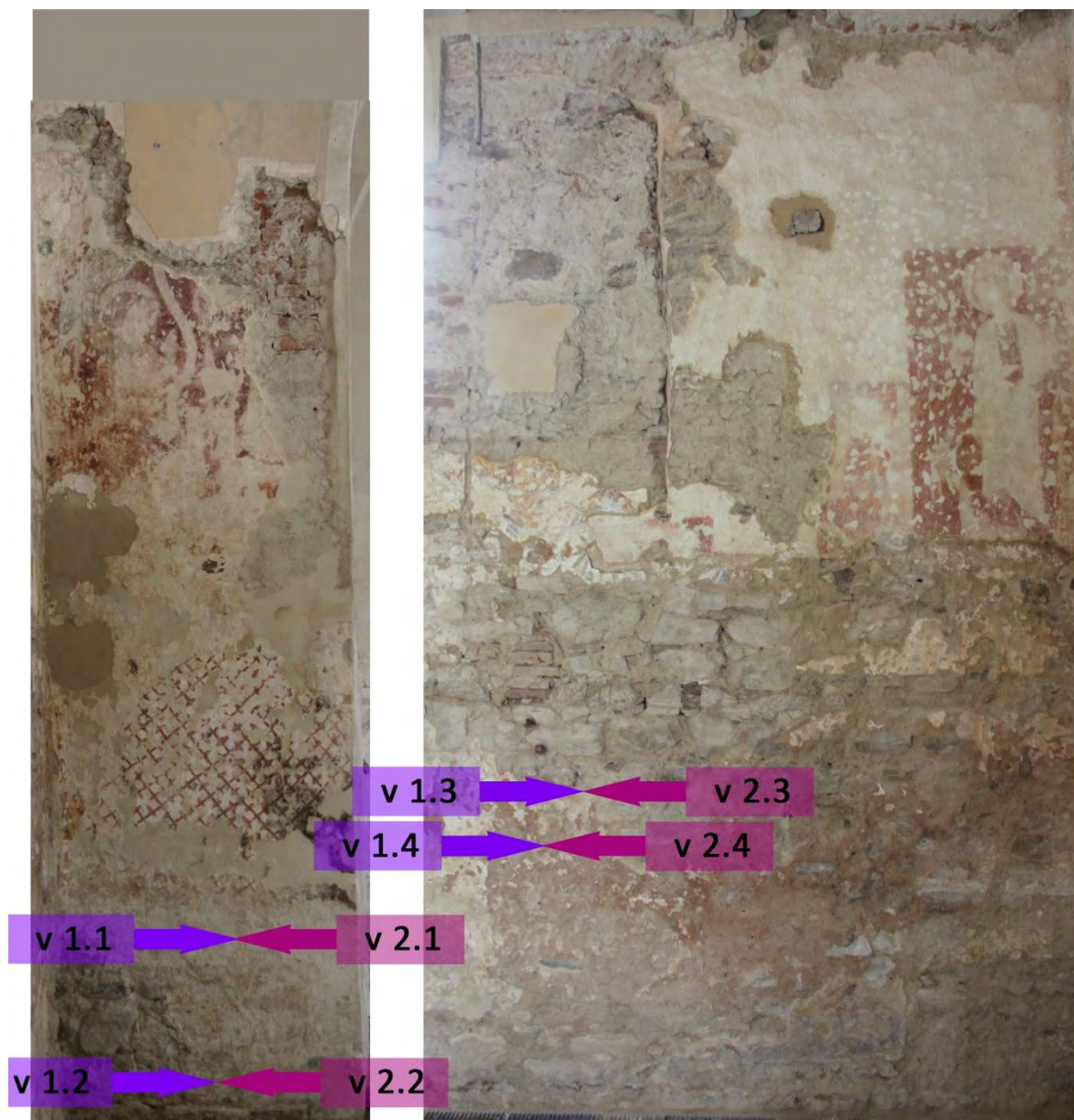
Obr. 65, 66 Východní a severní stěna hlavní lodi kostela (detail), grafický zákres míst odběrů vzorků odsolovacích zábalů o velikosti 10 × 10 cm.
