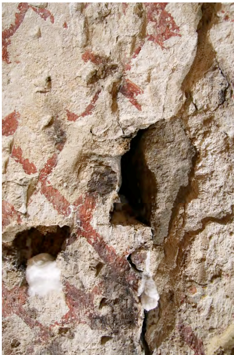
Obr. č. 111 Hlubková injektáž trhlin ve zdivu.
