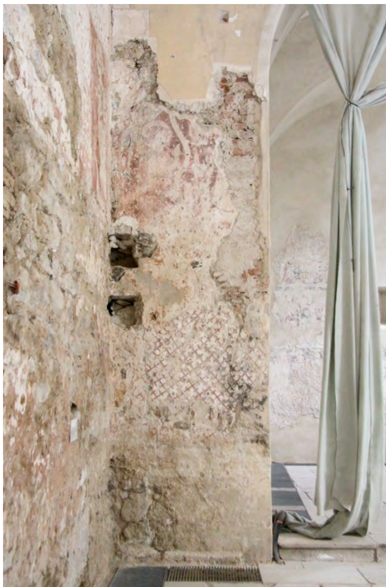
Obr. č. 108 Levá strana vítězného oblouku po mechanické a chemickém čištění destilovanou vodou; stav po vyjmutí druhotně osazené, nevyhovující, zazdívky v dolním otvoru; zkoušky tmelení.
