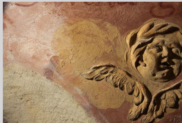
Detail zpráškovatělé barevné vrstvy.
