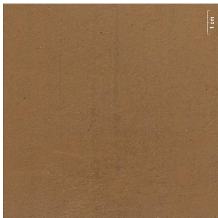
Snímek zkušebního pole E5 po zpevnění
