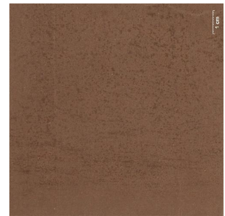
Snímek zkušebního pole E2 po zpevnění
