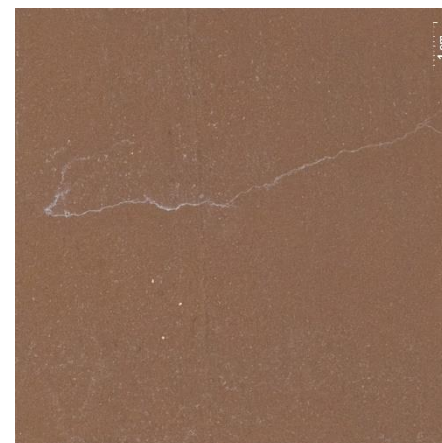
Snímek zkušebního pole D4 po zpevnění
