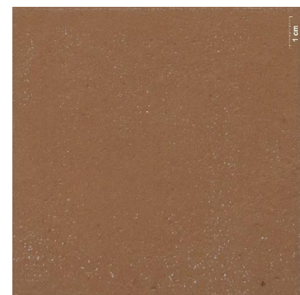
Snímek zkušebního pole C8 po zpevnění
