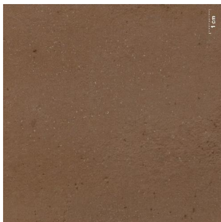
Snímek zkušebního pole E9 po zpevnění
