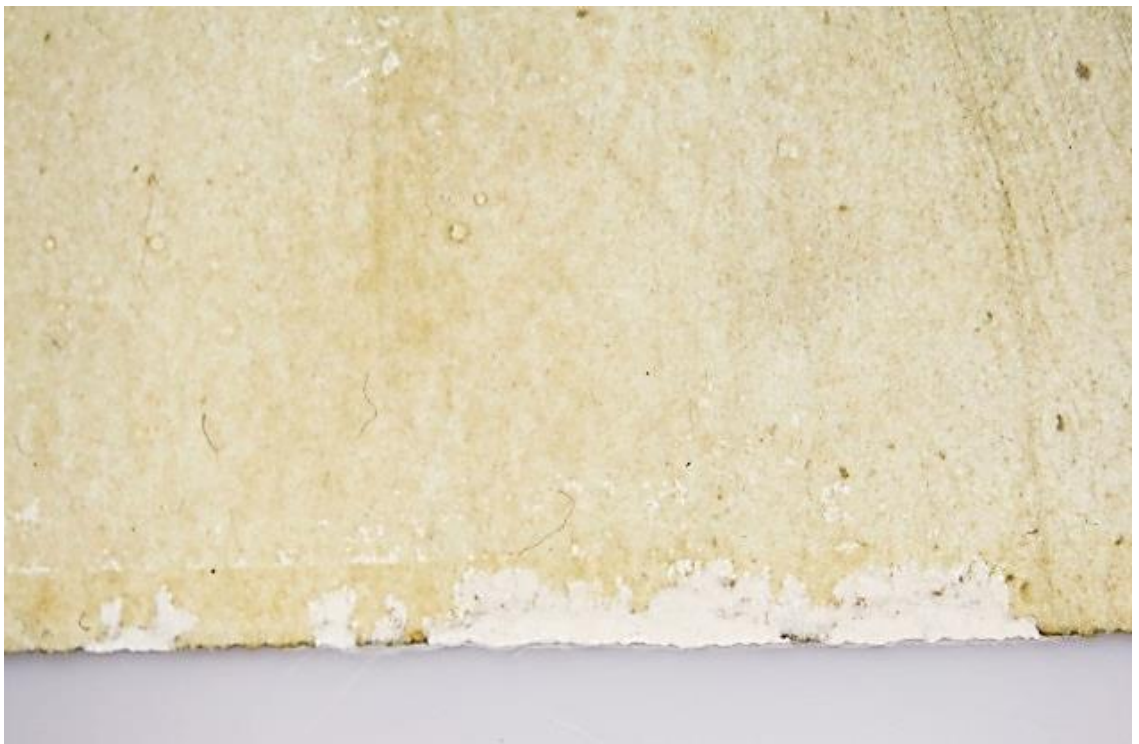
113. Dva psi na dálnici I, stav po tmelení, detail
