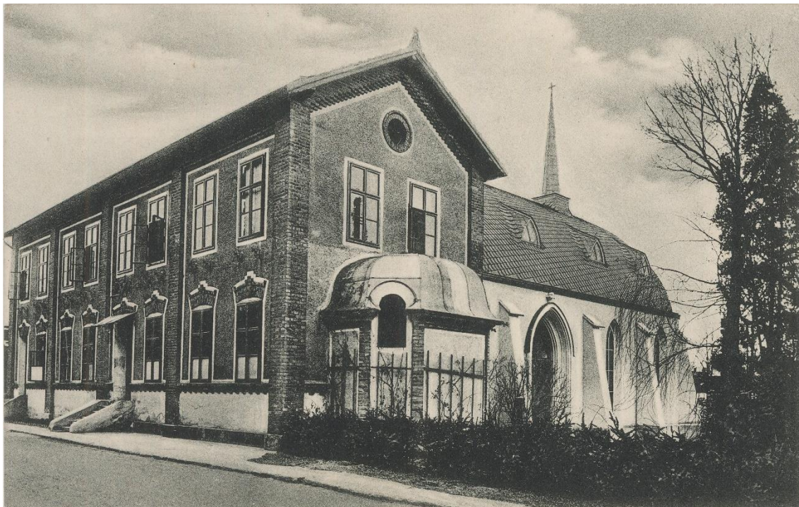
Příloha č. 27: První pavilon svitavské nemocnice (bez datace)
