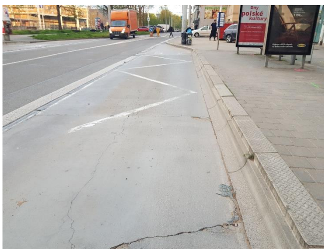
Obrázek 47 Příklad použití Kasselského obrubníku na zastávce MHD
