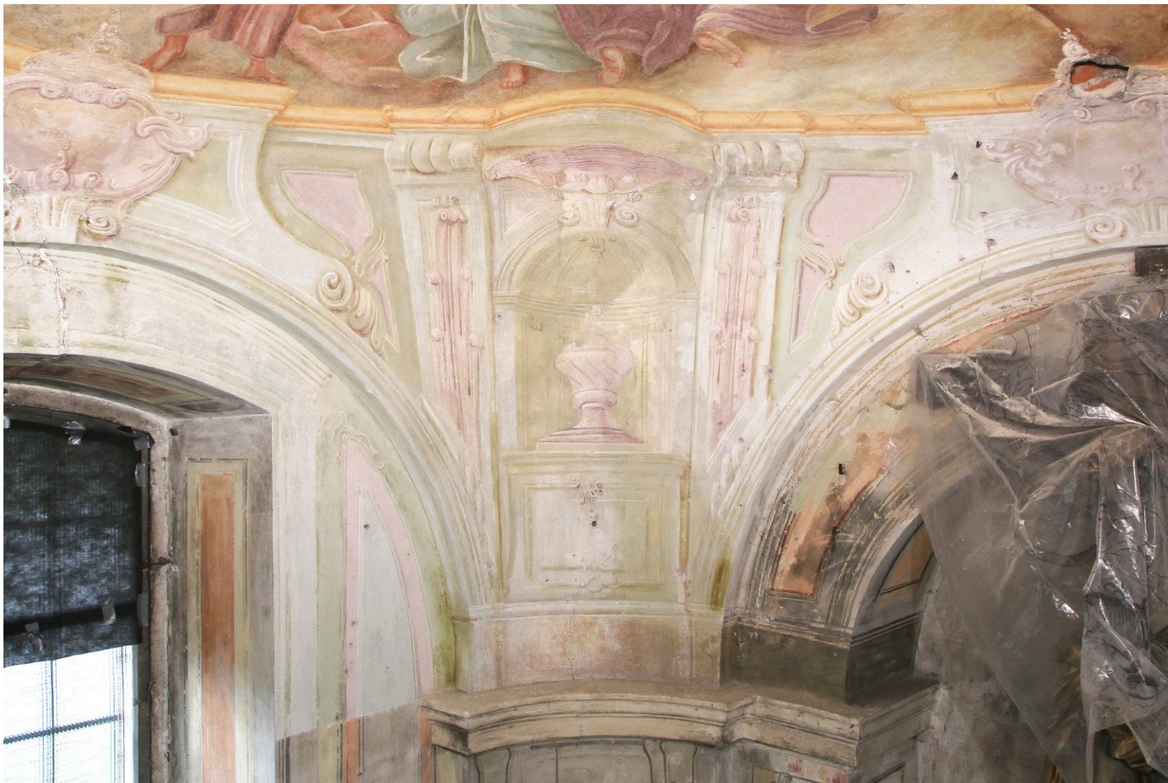
Obr. 77: Celkový pohled na severní kout kaple. Stav po sejmutí přemalby a očištění, v průběhu tmelení.
