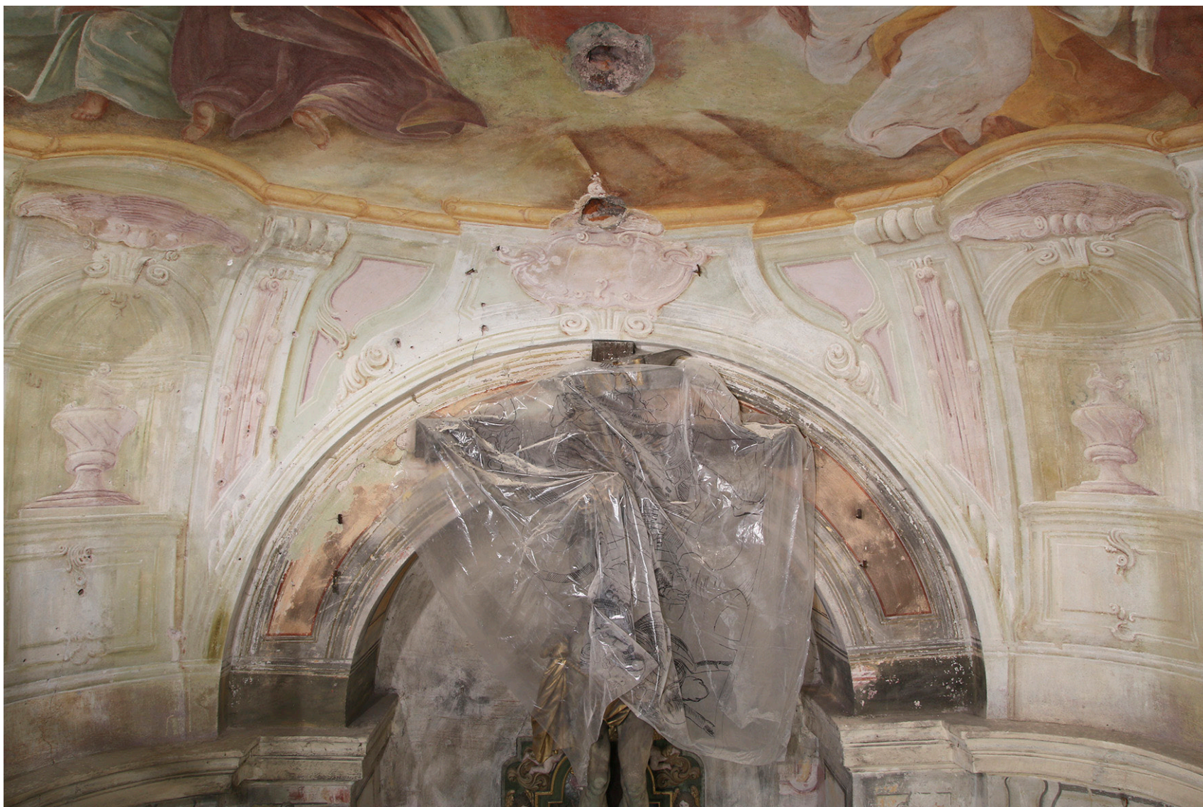
Obr. 70: Celkový pohled na SV stěnu kaple. Stav po se- jmutí přemal- by a očištění, v průběhu tmelení.
