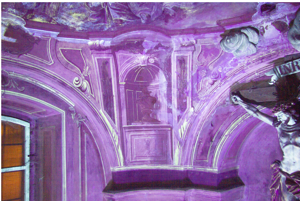
Obr. 27: Ztmavlá přemalba z 19. století. Pendentiv v severním koutě kaple, část SZ stěny a část oblouku nad oltářní nikou. Stav před restaurováním.
