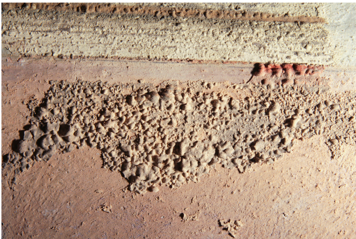
Obr. 33: Detail přemalby z 19. století v rozptýleném umělém bílém světle. Stav před restaurováním. Na fotografii je patrná povrchová ztráta barevné vrstvy.
