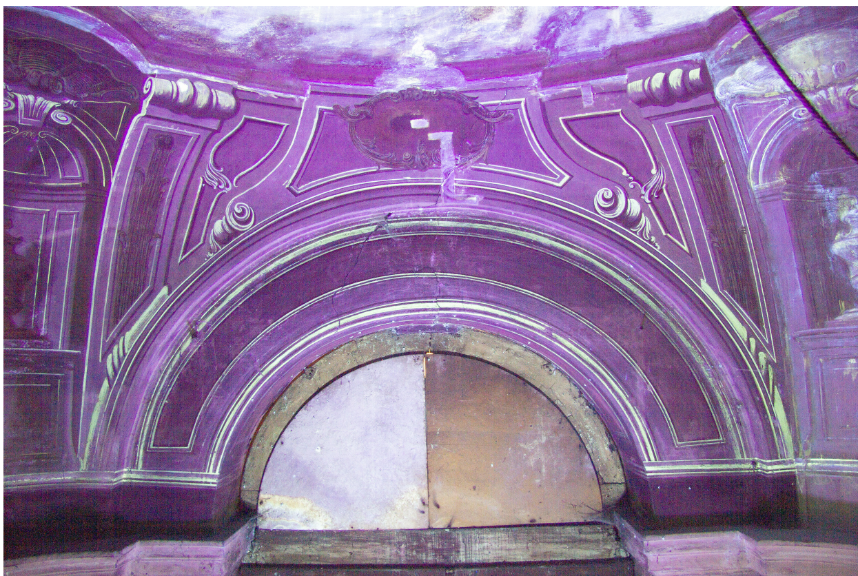
Obr. 21: Ztmavlá přemalba z 19. století. Oblouk nad vstupem do kaple, část pendentivu v jižním koutě a část v západním koutě. Stav před restaurováním.
