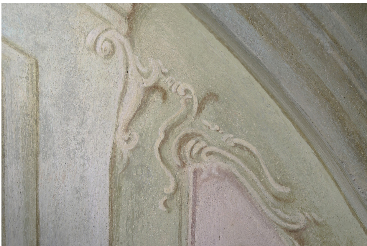
Obr. 86: Detail pendentivu jižního koutu kaple, pohled na podstavec iluzivní niky se zrekonstruovanými dekorativními prvky. Stav po restaurování.
