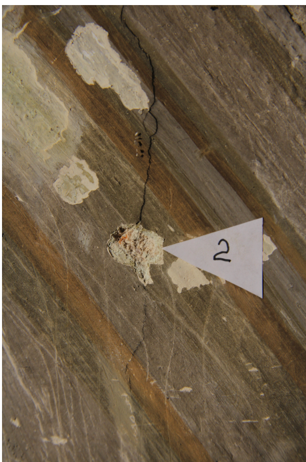
Obr. 13 a, b: Detaily míst odběru vzorků VI-V3 pro chemicko-technologický průzkum: a) (vlevo) lokalizace míst odběru vzorků VI a V3, vpravo V2. Vzorek V4 nebyl zdokumentován. Foto a grafické zpracování: ANM, FR, UPa.
