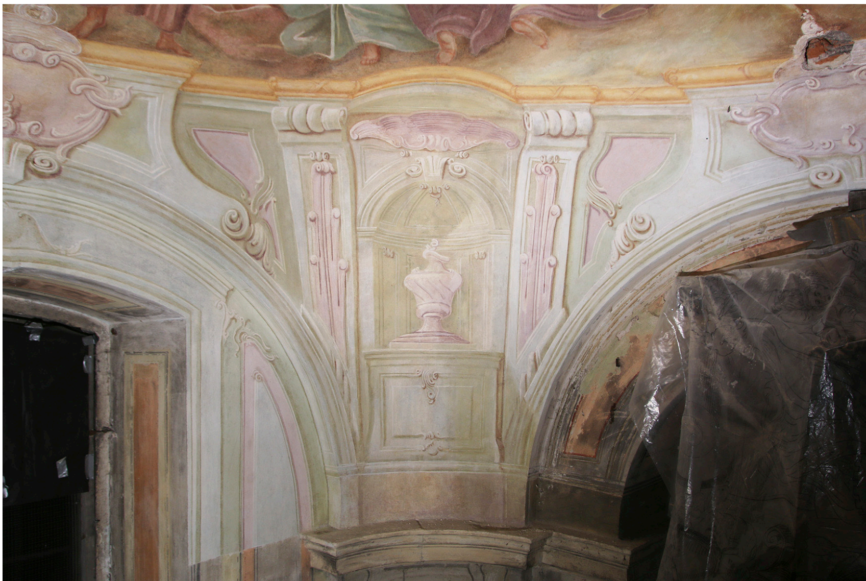
Obr. 85: Celkový pohled na sevní kout kap- le. Stav po restaurování.
