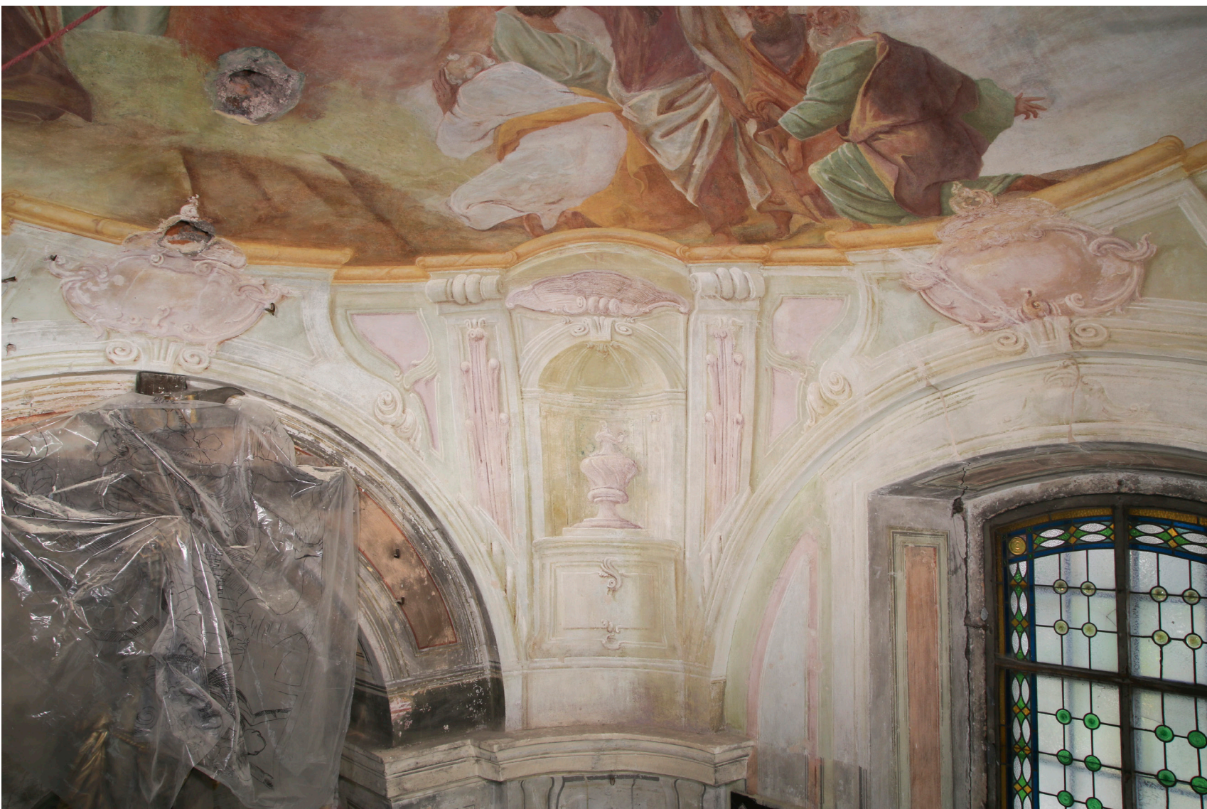
Obr. 71: Celkový pohled na východní kout kaple. Stav po sejmutí přemalby a očištění, v průběhu tmelení.
