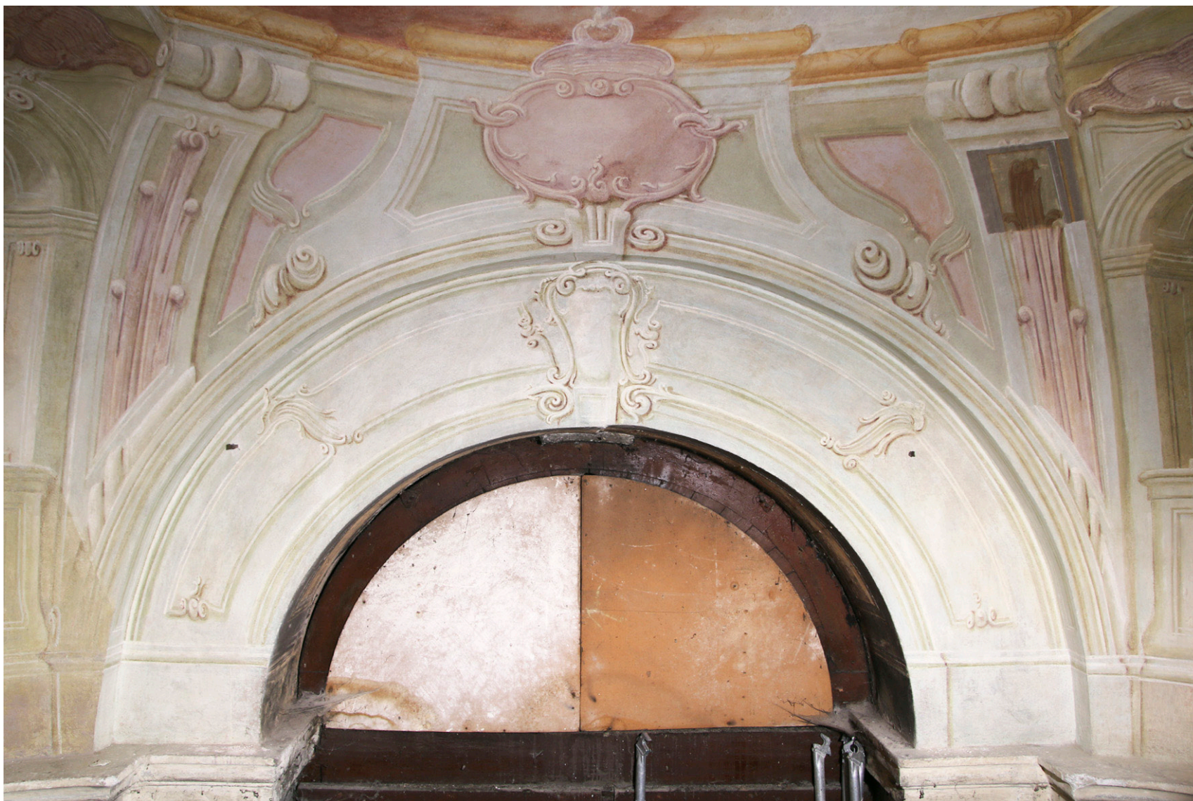
Obr. 82: Celkový pohled na JZ stěnu kap- le. Stav po restaurování.
