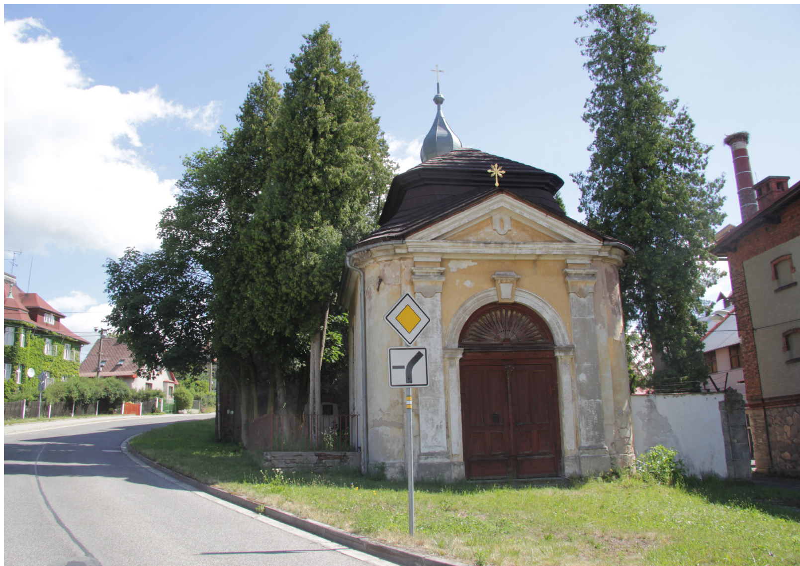
Obr. 01: Kaple Bolestné Panny Marie - současný stav, exteriér, pohled ze západní strany. Ulice Horská směrem na Janovičky.
