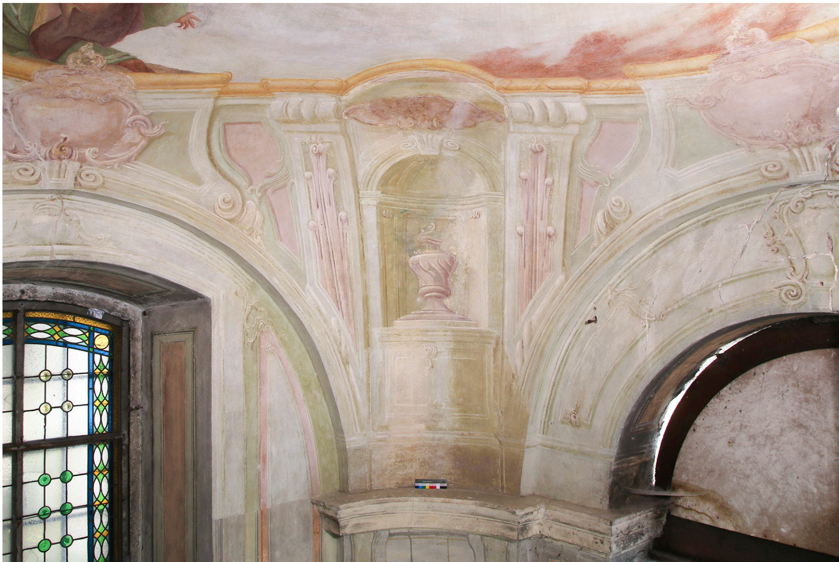
Obr. 73: Celkový pohled na východní kout kaple. Stav po sejmutí přemalby a očištění, v průběhu tmelení.
