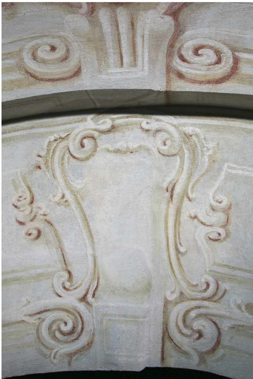
Obr. 90: Detail iluzivního zrcadla nad vstupem do kaple na JZ stěně. Stav po restaurování.
