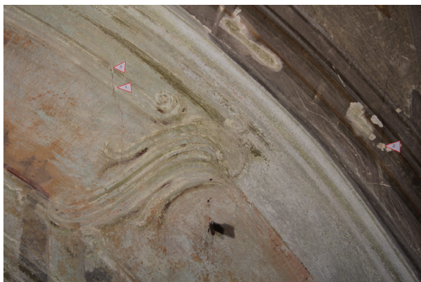
Obr. 12 a, b: Místa odběru vzorků VI-V3 pro chemicko-technologický průzkum. Popis míst odběru je uveden v Tab. I. Foto a grafické zpracování: ANM, FR, UPa.
