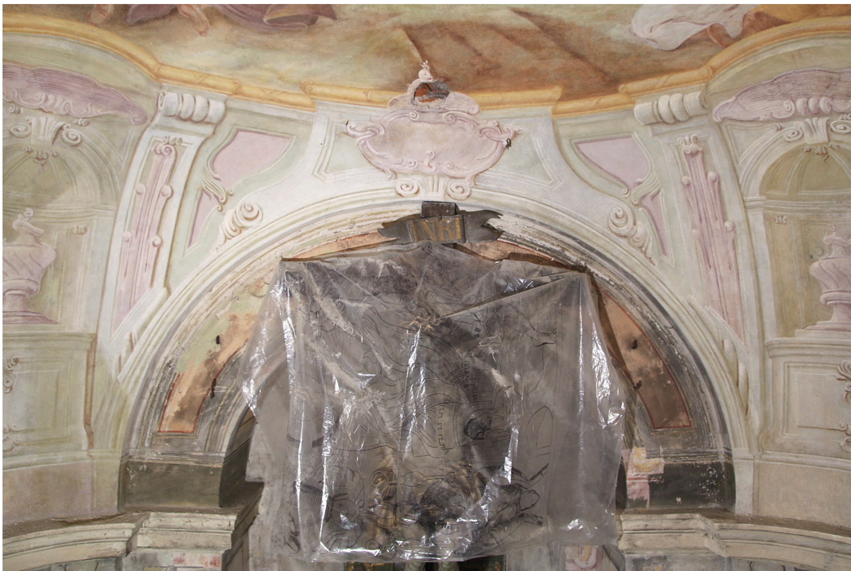
Obr. 78: Celkový pohled na SV stěnu kap- le. Stav po restaurování.
