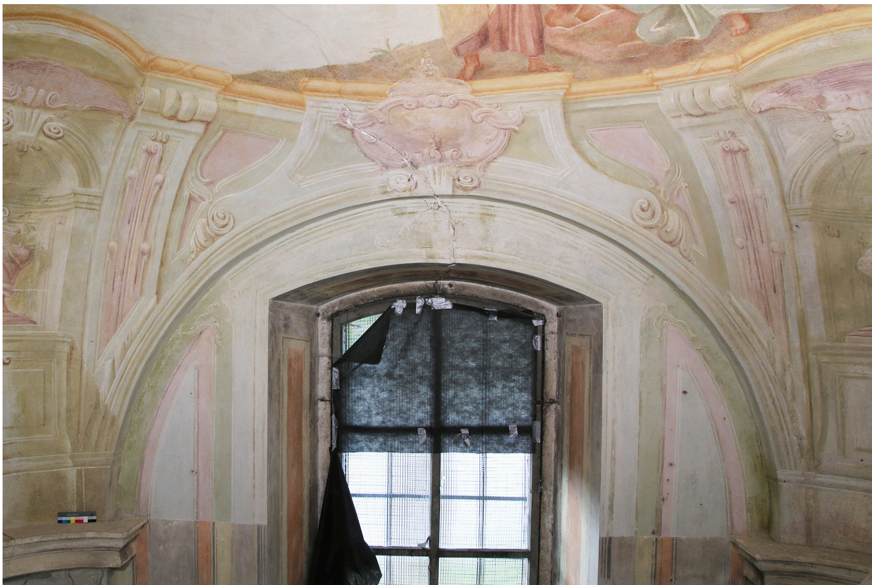
Obr. 76: Celkový pohled na SZ stěnu kaple. Stav po se- jmutí přemal- by a očištění, v průběhu tmelení.
