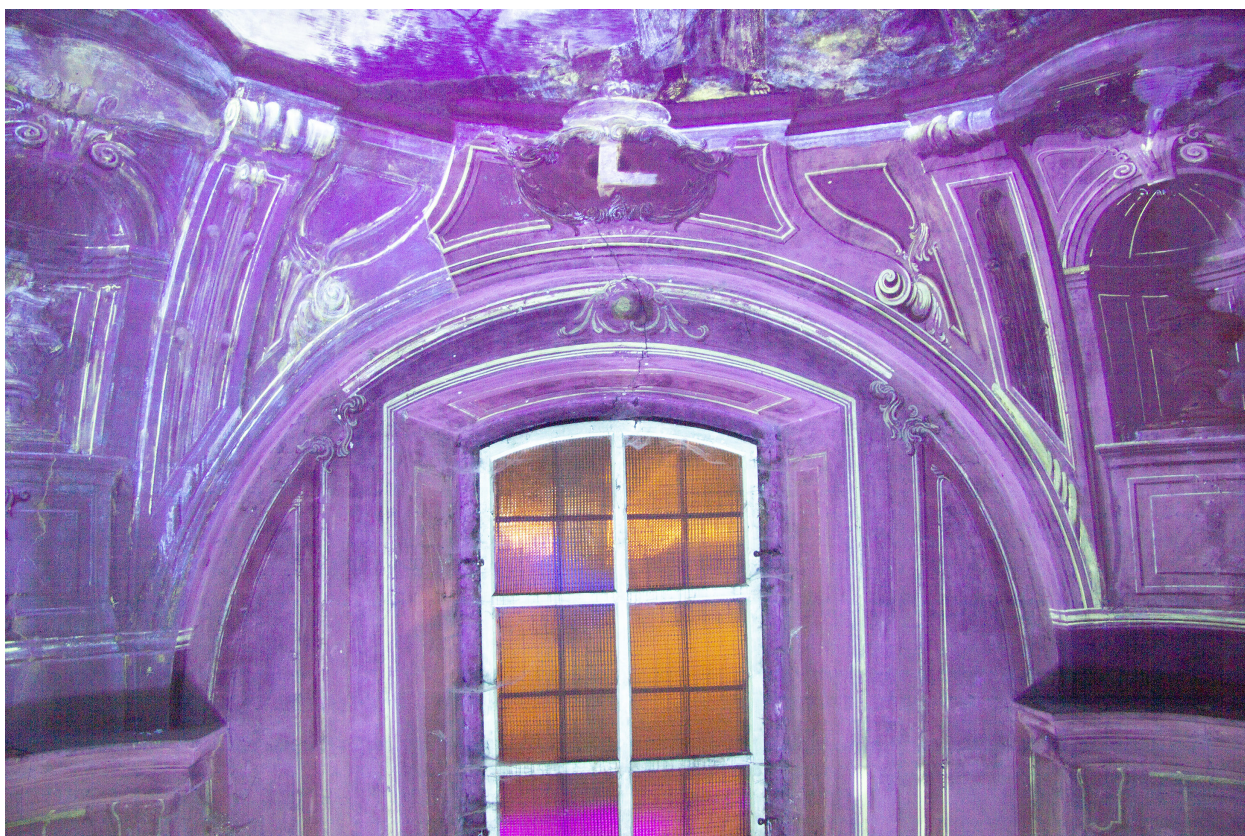
Obr. 25: Ztmavlá přemalba z 19. století. SZ stěna kaple, část pendentivu v západním koutě a část v severním koutě. Stav před restaurováním.
