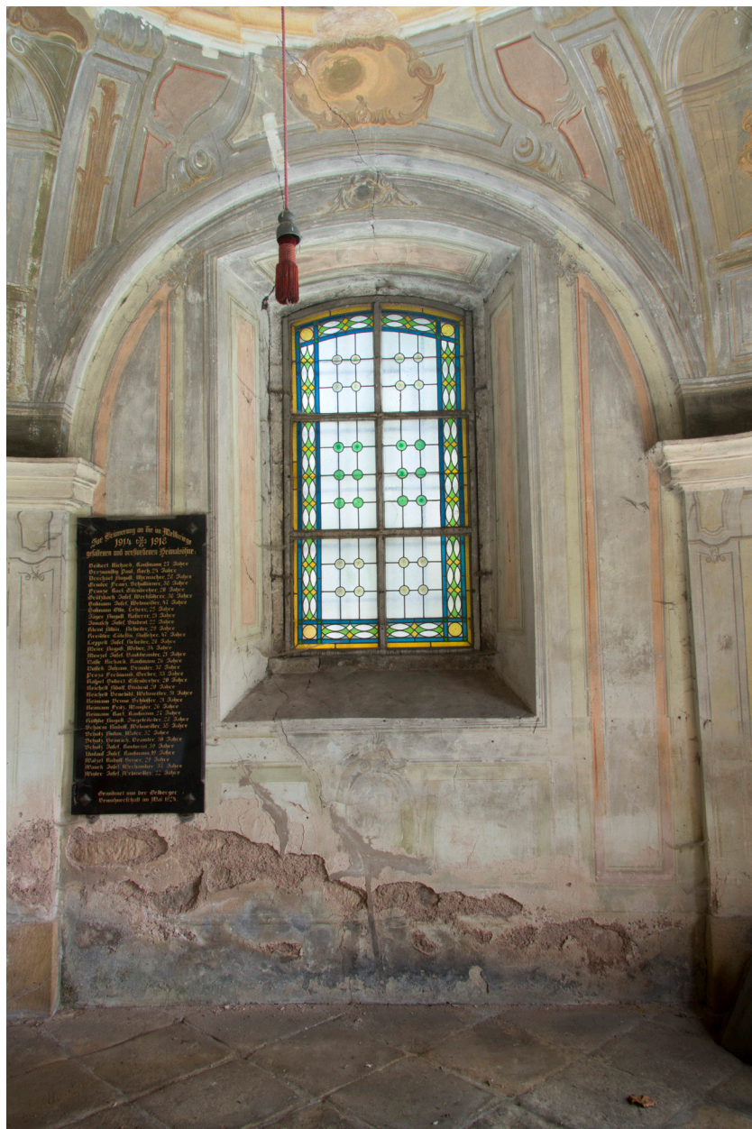
Obr. 07: Interiér kaple, JV stěna. Stav před restaurováním.
