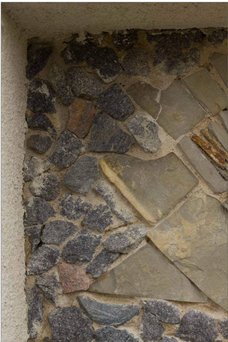
Obr. 16: Detail po osazení mozaikových kamenů v místě obnažené ocelové armatury v horní levé části mozaikového výjevu.
