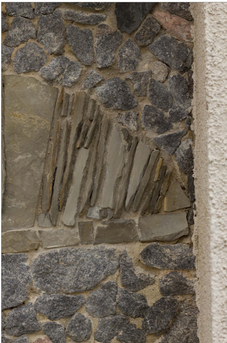
Obr. 16: Detail po osazení mozaikových kamenů v místě obnažené ocelové armatury v horní levé části mozaikového výjevu.
