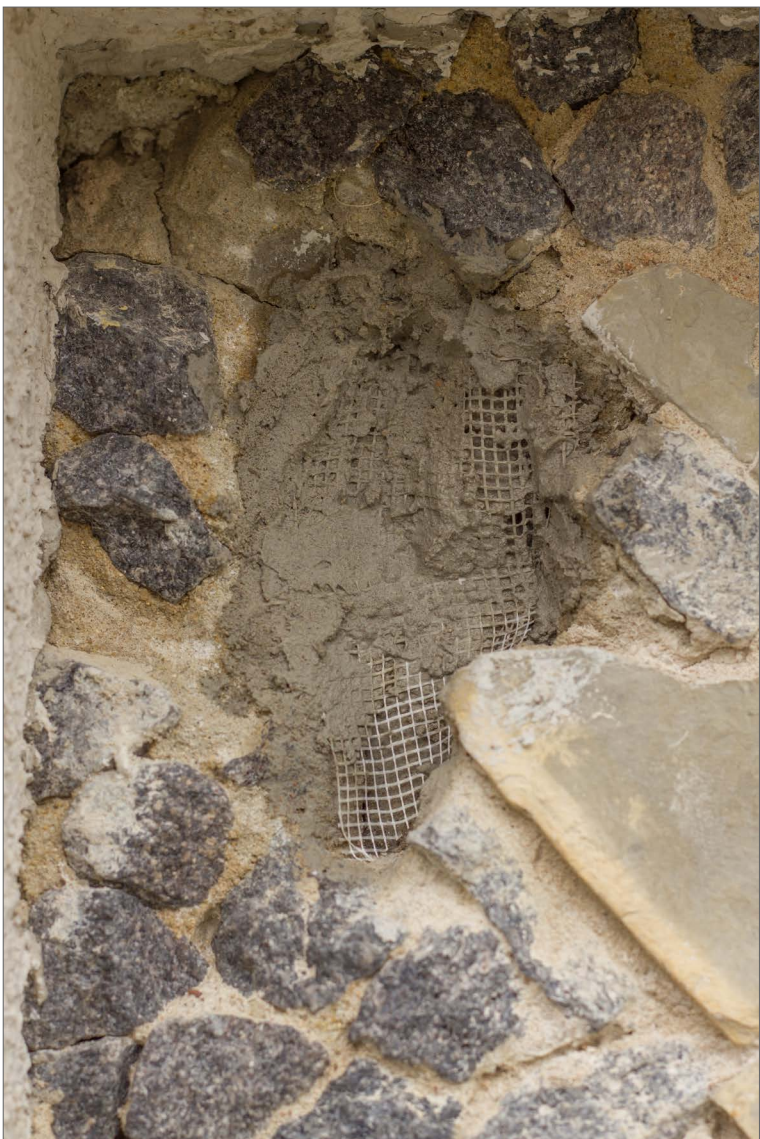
Obr. 14: Detail malty zpevněné armovací mřížkou v horní levé části mozaikového výjevu.
