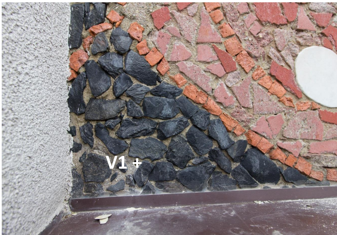
Obr. 72 Místo vrtu V1 ve výšce 7 cm; stanovení obsahu vodorozpustných solí (V1A, V1B).
