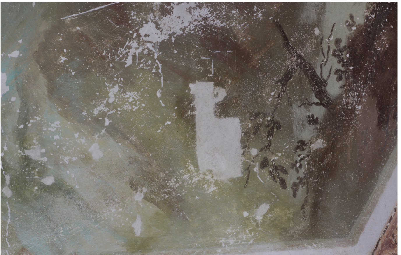
Obr. 36: Část malby v místě sondy po tmelení.
