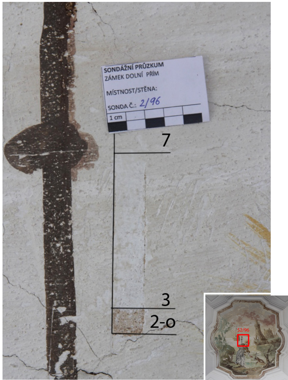
Obr. 4: Sonda č. 2/96: Strop presbytáře (sonda z roku 1996). 2-o - hist. om.-štuk; 3 - hist. bílý nátěr; 7 - druhá barevná vrstva - (před r. 1770)
