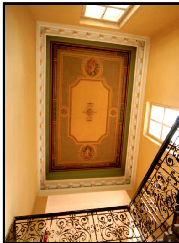
Obrázek č. 14 – Pohled na malovaný strop ve schodišťové věži
