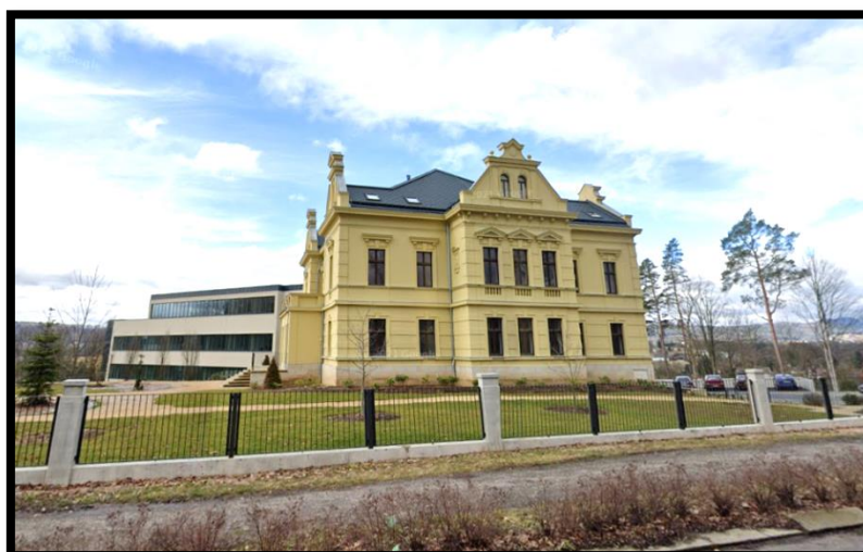
Obrázek č. 26 a 27 – Současný stav vily po rekonstrukci a modernizaci
