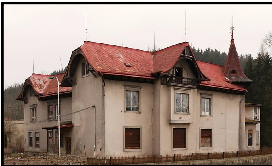
Obrázek č. 3 – Současný stav vily, pohled na jihozápadní nároží
