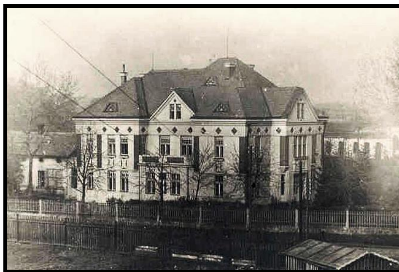
Obrázek č. 58 – Dobová fotografie finální podoby vily, pohled na jižní a východní průčelí
