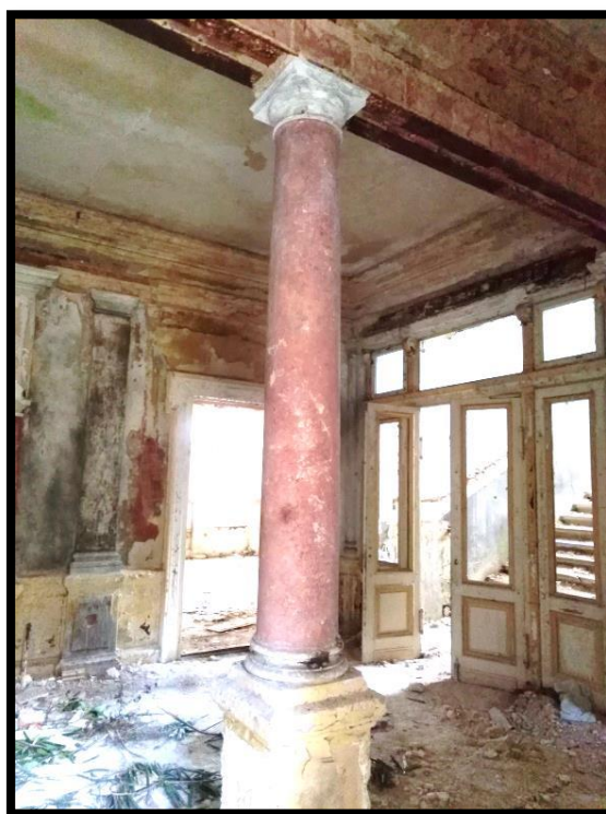
Obrázek č. 78 – Sloup z imitovaného mramoru v hale, za ním vstup na hlavní schodiště, stav z roku 2020 Autor: Michaela Koláčná
