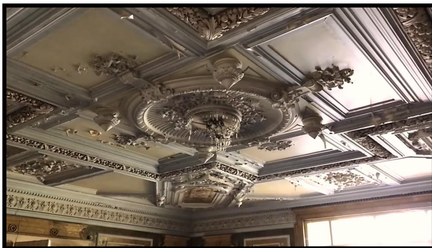
Obrázek č. 8 – Detail štukového stropu
