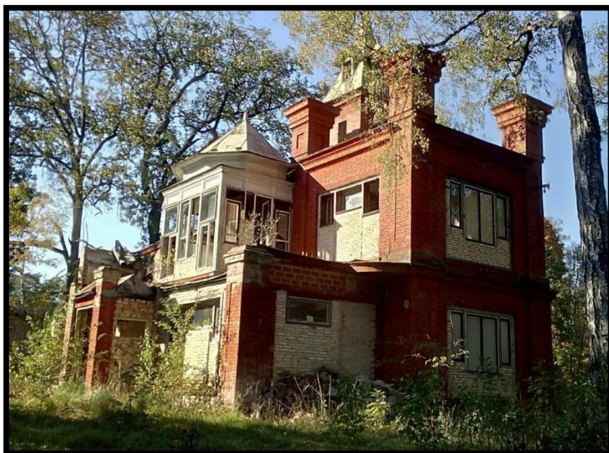
Obrázek č. 18 – Pohled na severovýchodní nároží, stav těsně před demolicí Autor: Petr Kenny
