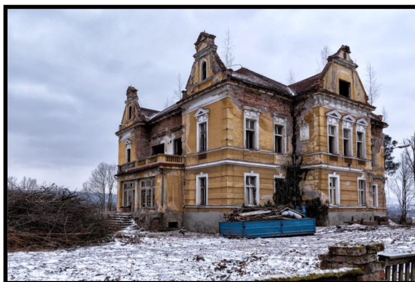
Obrázek č. 25 – Stav vily těsně před rekonstrukcí, která proběhla v roce 2020 Autor: DN-Foto
