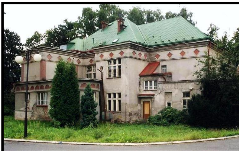
Obrázek č. 63 – Stav vily v roce 2001, o deset let později byla zbourána
