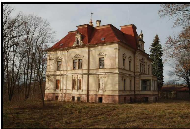
Obrázek č. 89 – Pohled na východní nároží, stav z roku 2009 Autor: Drbohlavová Jana Zdroj: https://pamatkovykatalog.cz/vila-11157964
