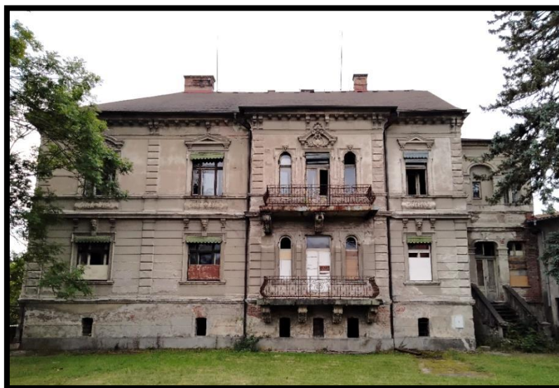
Obrázek č. 29 – Hlavní vstupní průčelí, současný stav, v porovnání s dobovou fotografií chybí převýšený štít (pravděpodobně byl sejmут při jedné z obměn střešní krytiny)
