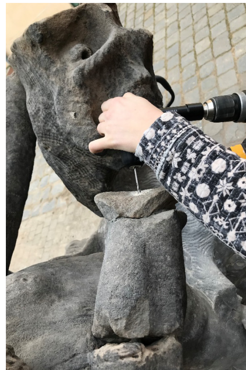
Obrázek 99 vrtání díry pro novou armaturu
