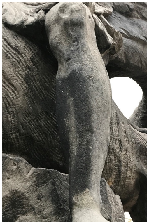
Obrázek 95 redukce černého povlaku – detail holeň
