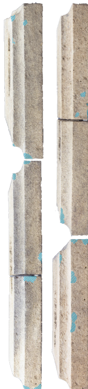
Obrázek 14 grafické poškození, nové tmely – podstavec
