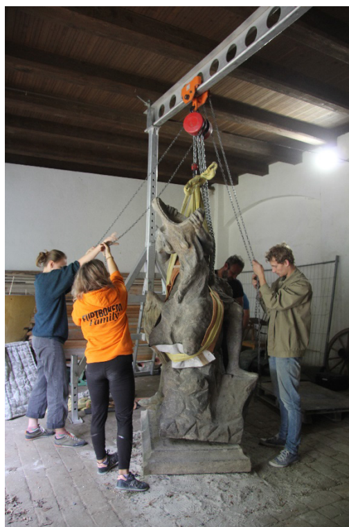
Obrázek 113 transport na místo – usazování skulptury na podstavec
