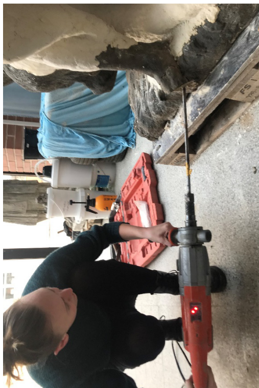
Obrázek 100 odvrtání armatury na chodidle muže
