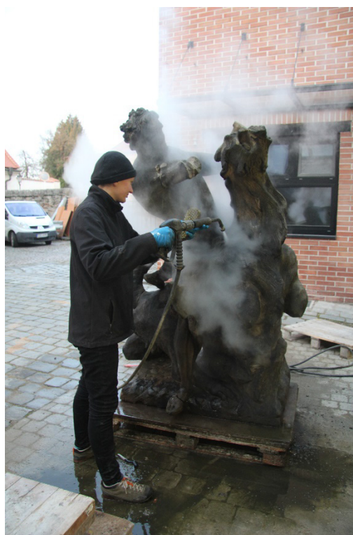
Obrázek 94 čištění bio. napadení vodní parou a umělohmotnými kartáči
