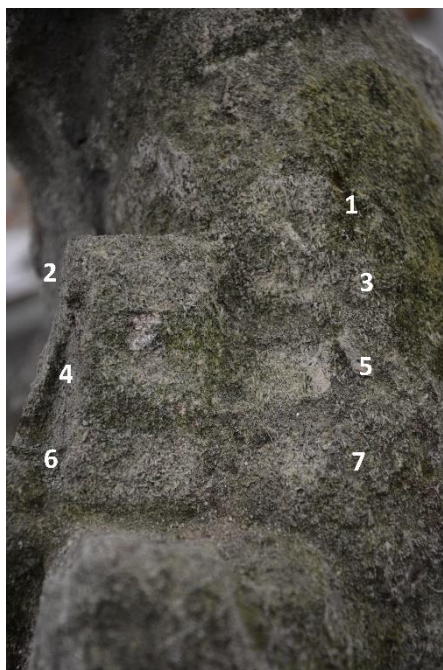
Obrázek 19 – Zkoušky čištění biologického napadení
