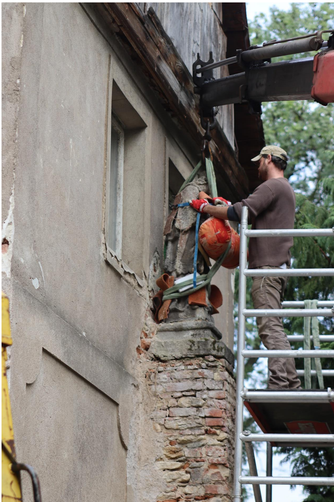
Obrázek 56 – Uvazování sochy před transportem. Zdvihání prováděno pomocí hydraulické ruky
