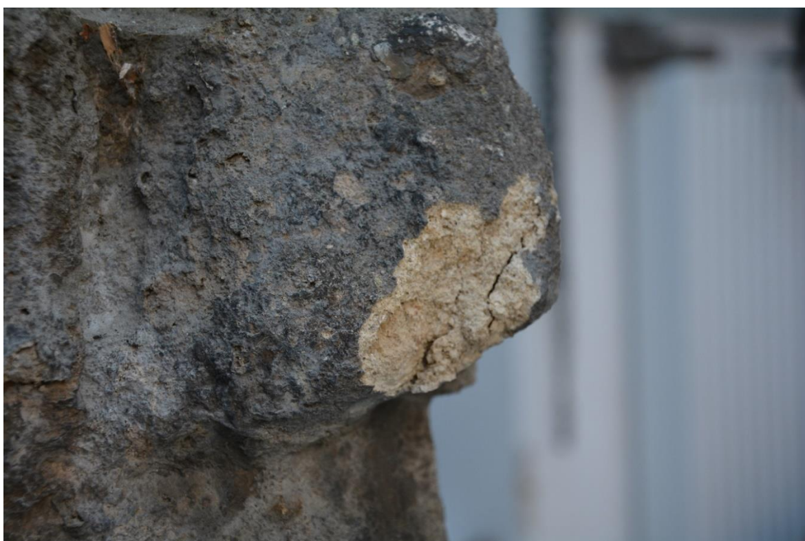
Obrázek 53 – Detail oddělující se části drapérie
