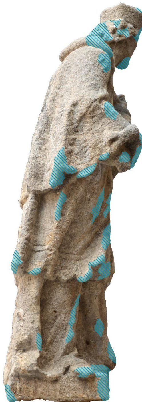
Obrázek 40 – Grafický zakres nových vysprávek, figura – pravá strana
