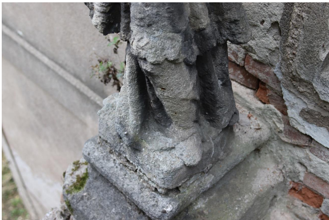
Obrázek 55 – Fotografie před demontáží sochy na svém původním místě, s detailem původního řešení osazení
