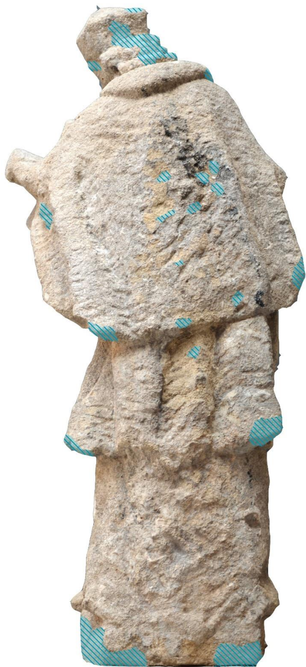
Obrázek 39 – Grafický zakres nových vysprávek, figura – zadní strana
