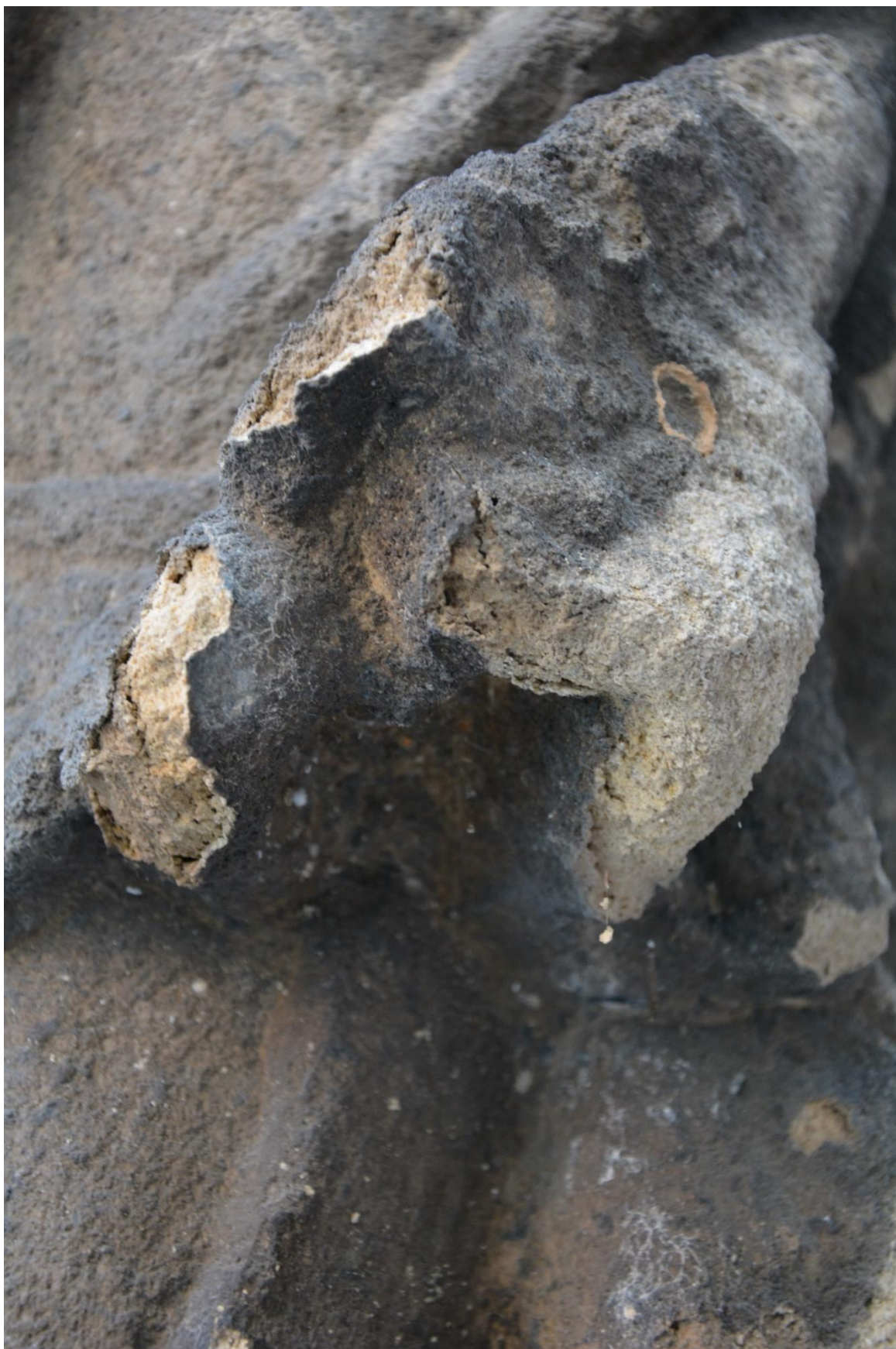
Obrázek 51 – Detail sádrovcové krusty s oddělovacími se částmi vrchní vrstvy, se značnou degradací horniny v odhalených místech
