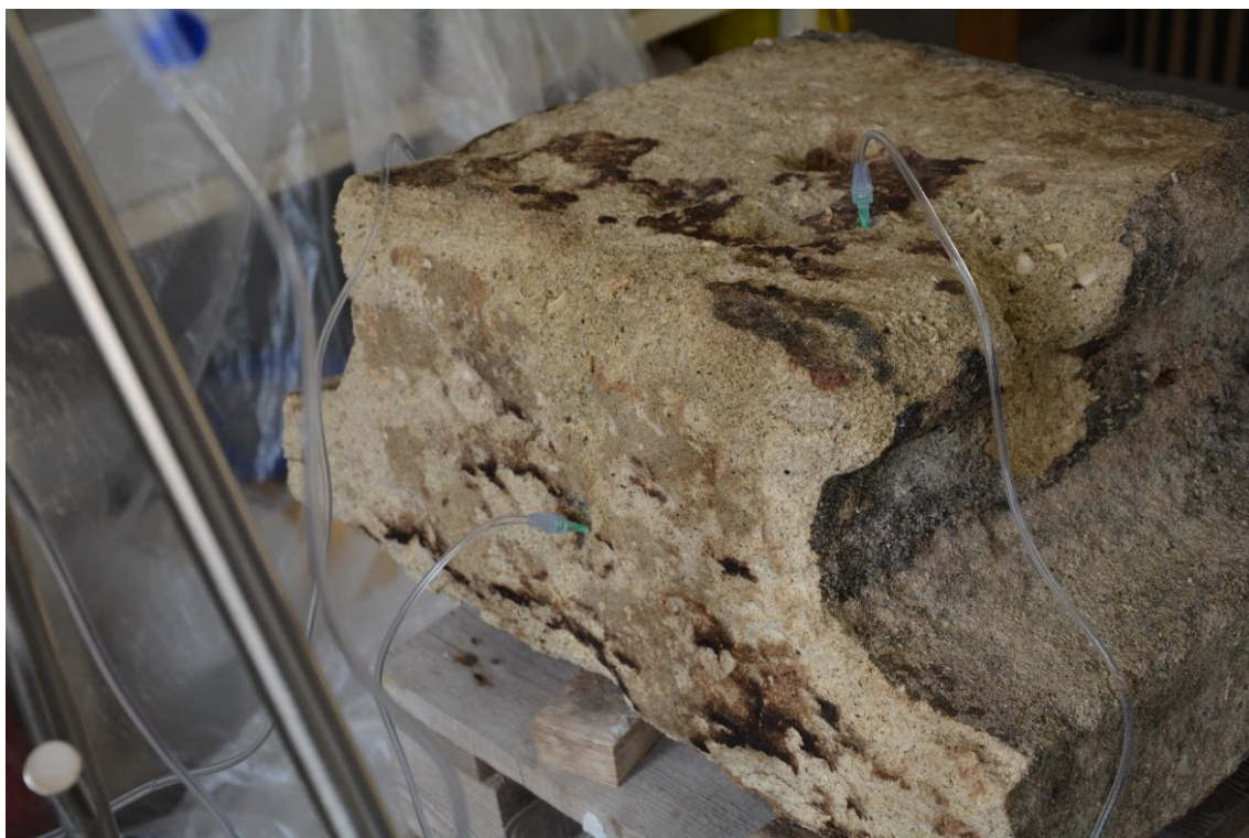
Obrázek 62 – Konsolidace – detail zavedení infuzí s injekčními jehlami do hmoty kamene
