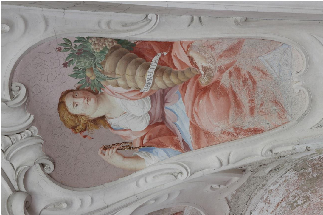
7. Výjev Štědrost – úbytek barevné vrstvy a povrchu intonaca ve spodní části výjevu.
