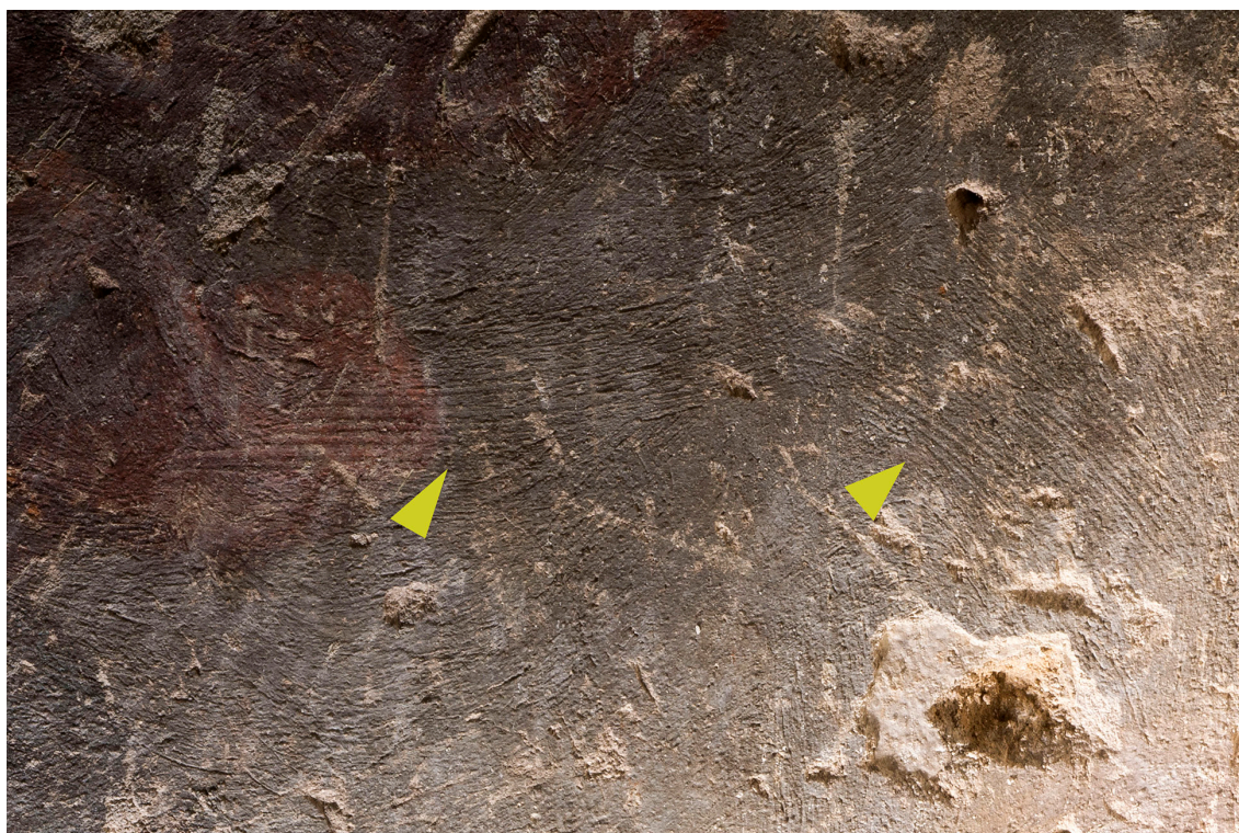
Obr. 15: Detail původní techniky. Historická dvouvrstvá omítka se světlým nátěrem (žlutá šipka). Tato vrstva se vyskytuje převážně na pravé polovině úseku s figurou archanděla Gabriela .
