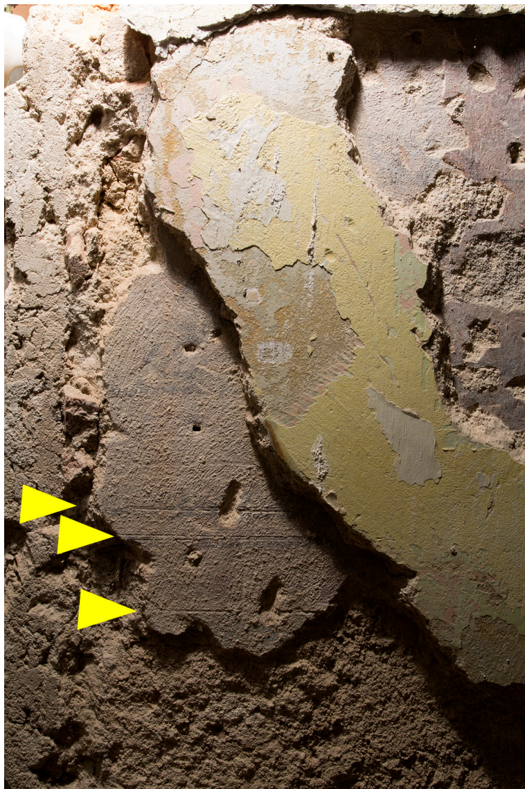
Obr. 18: Detail soklové partie s otiskem dveřního ostění otvoru do čerstvé omítky.
