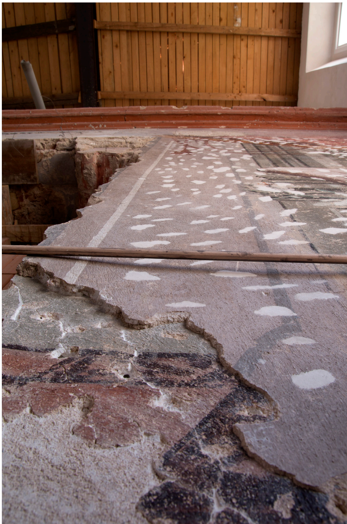
Obr. 21: Pohled na omítkovou a barevnou vrstvu, která měla za úkol dorovnat výškový rozdíl při okraji vstupu.
