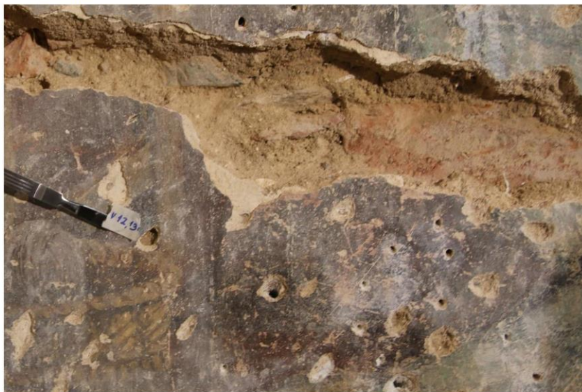
Obr. 46 Lokalizace odběru vzorků ke stanovení obsahů vodorozpustných solí V12, V13, detail.
