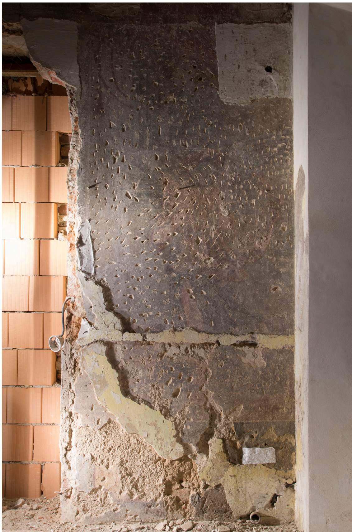
Obr. 35: Celkový pohled na restaurovaný úsek s figurou archanděla Gabriela. Ostré boční nasvícení zvýraznilo poškození, stopy úpravy povrchu, rezidua druhotných vrstev, rytou linku ukončující soklovou partii, druhotný nátěr na cementové bázi v pravém dolním koutu nanesený přes defekty.
