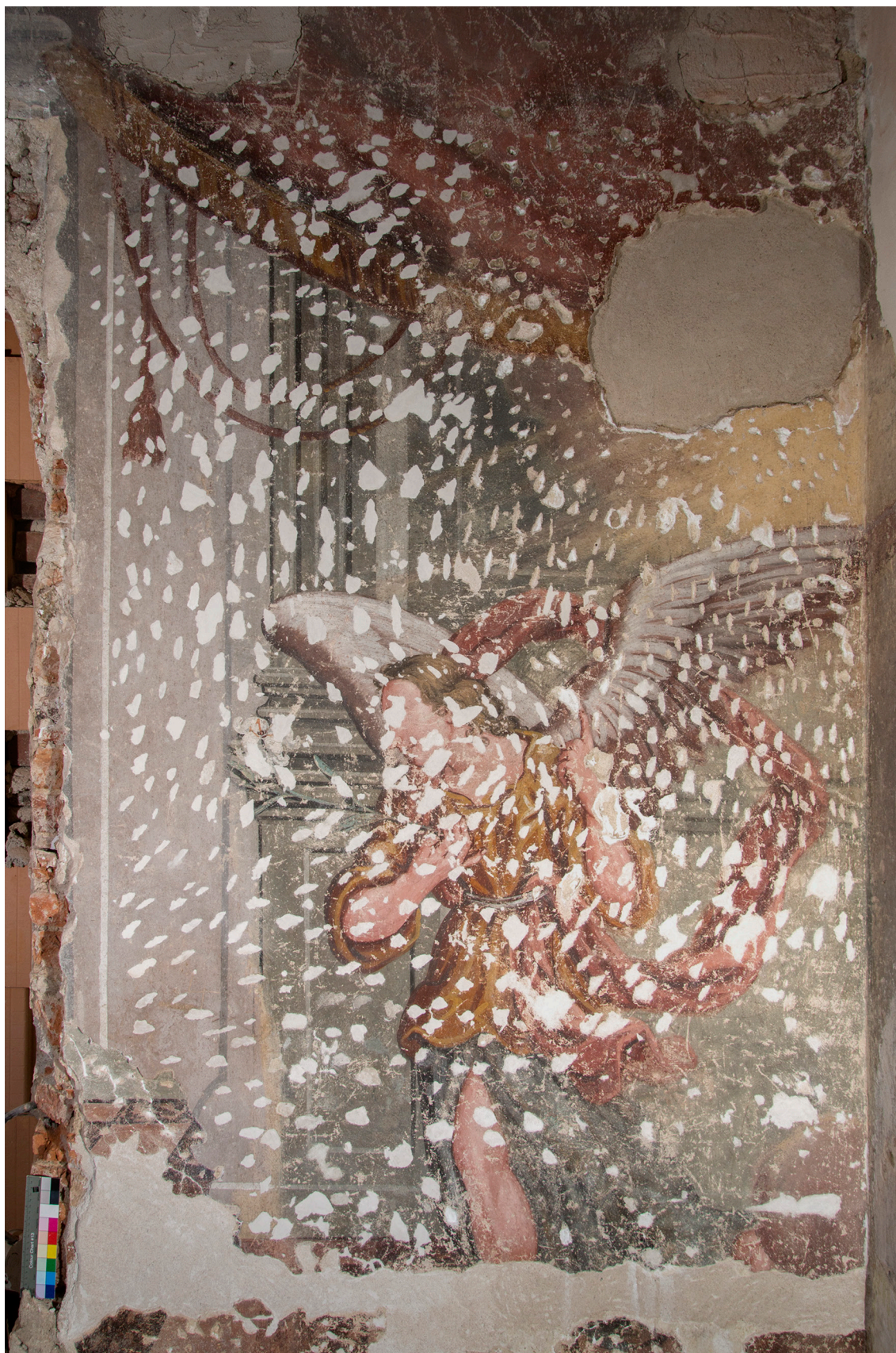
Obr. 44: Celkový pohled na úsek s figurou archanděla Gabriela , stav po tmelení.
