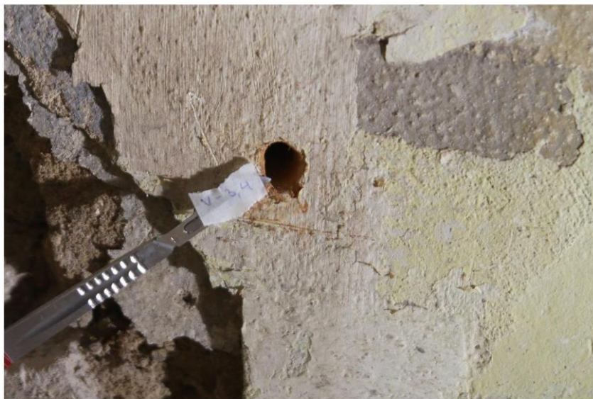
Obr. 42 Lokalizace odběru vzorků ke stanovení obsahů vlhkosti a vodorozpustných solí V3, V4, detail.
