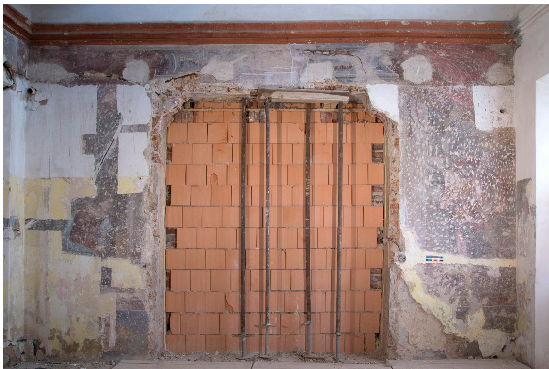
Obr. 09: Místnost 2.22 (oratoř). Pohled na část severní a východní stěny. Stav z roku 2019. Foto: Jan Frühauf.
