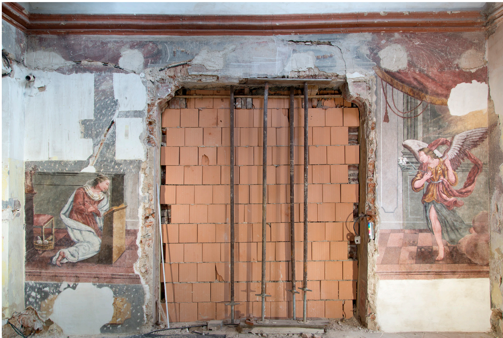
Obr. 58: Pohled na jižní stěnu s výjevem Zvěstování . Stav po restaurování.
