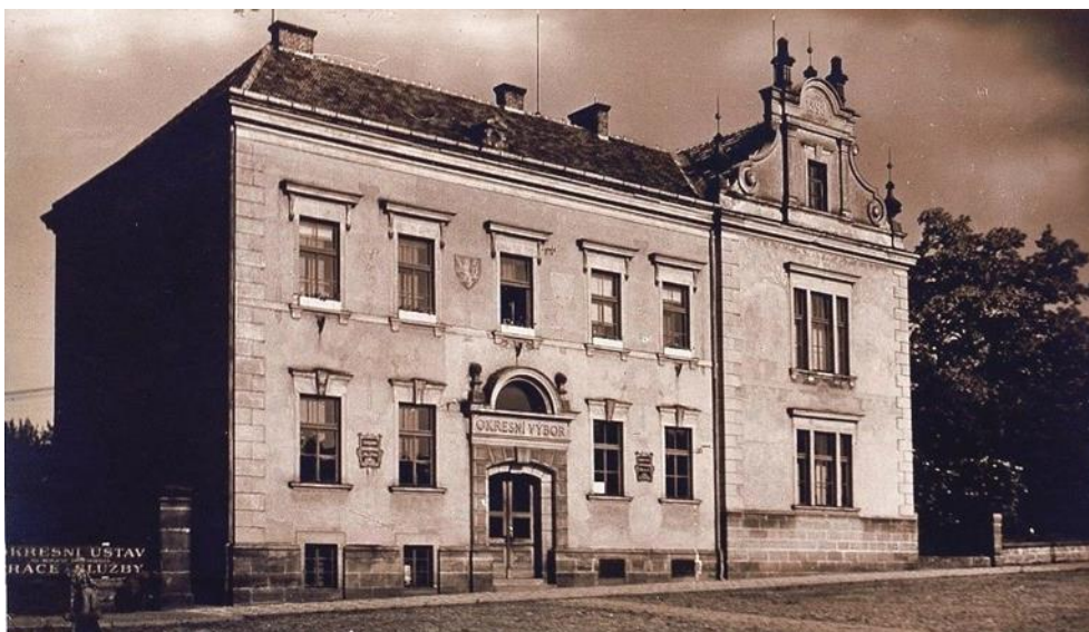
Obr. 2: Okresní výbor v Chrudimi na Tyršově náměstí na pohlednici vydané před r. 1938
