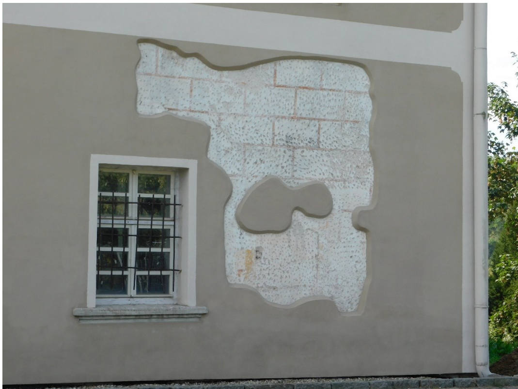
Obrázek 13 Odkrytá původní renesanční fasáda
