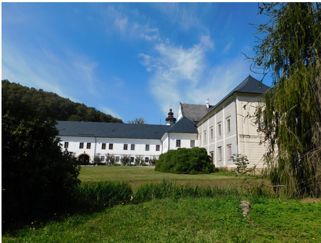
Obrázek 4 Jižní část zámku Velké Losiny
