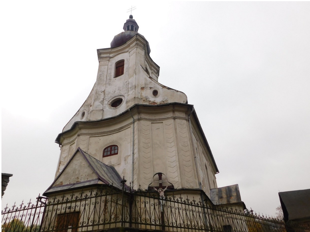
Obrázek 35 Průčelí kostela. v Pustých Žibřidovicích
