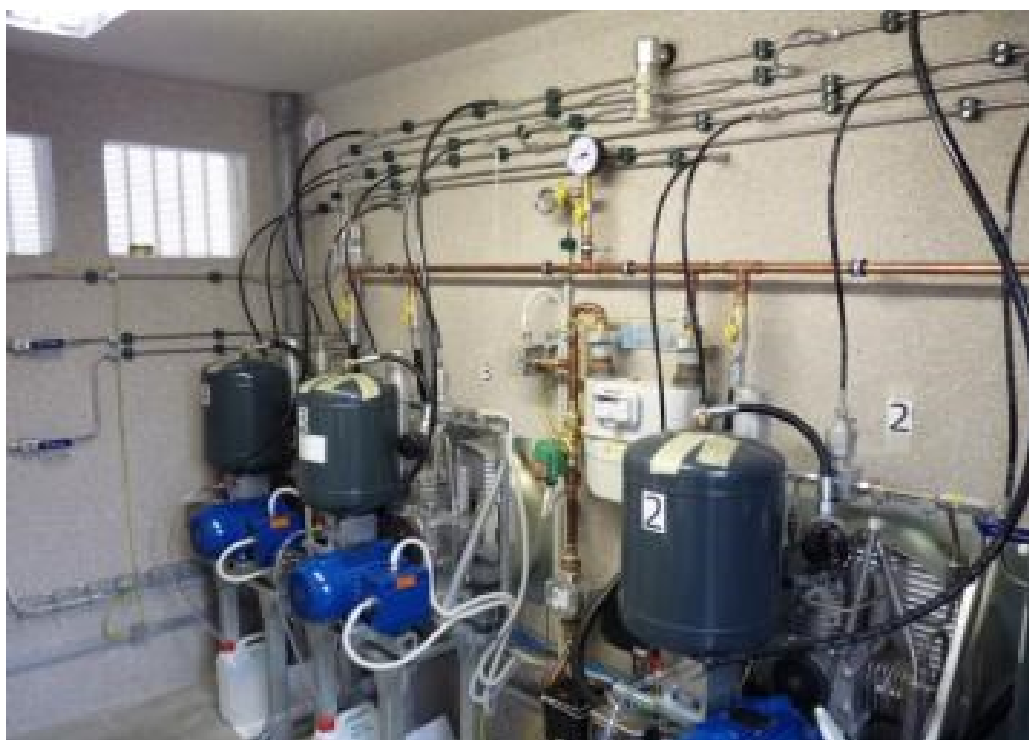
Obrázek 15 – Uložení kompresorů uvnitř plnicí stanice
