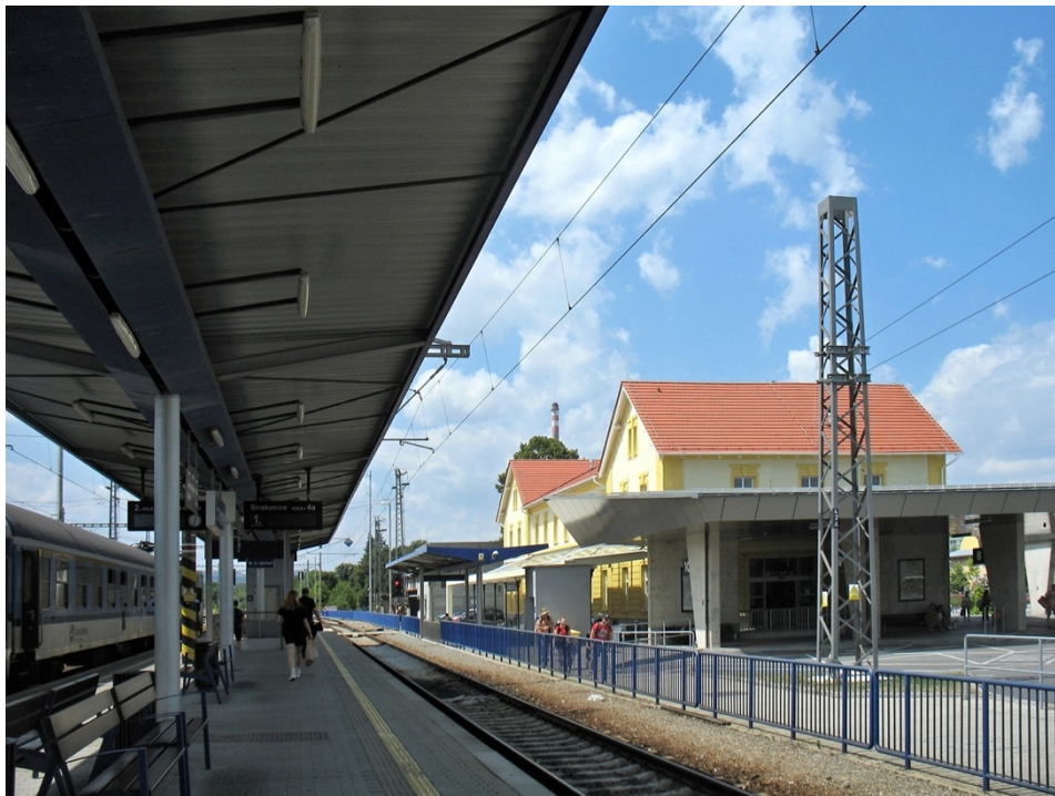
Obrázek 15 Přestupní terminál Strakonice (28)
