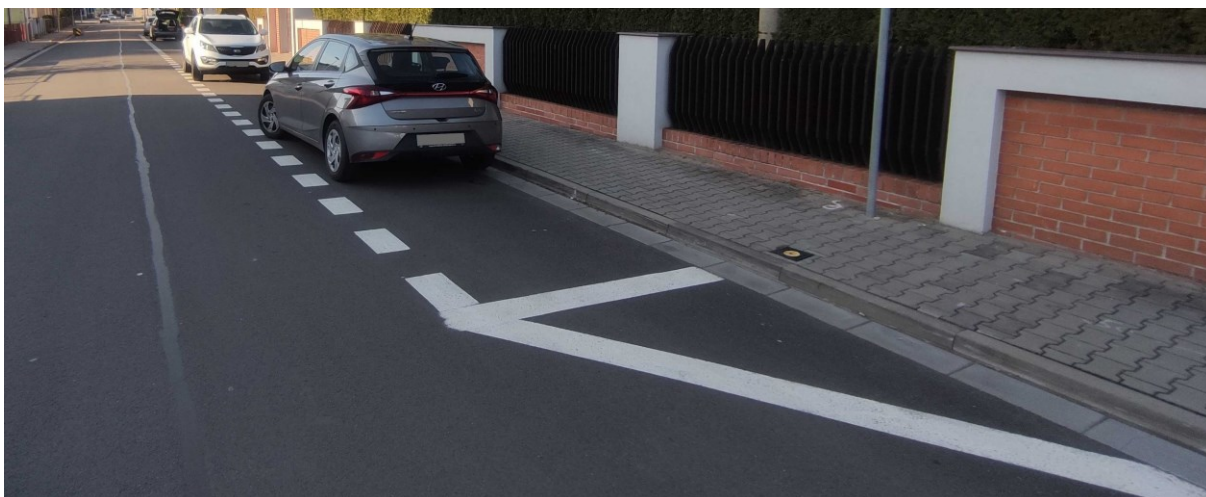
Obrázek 17 Podélně uspořádaná parkovací stání označená značením V 10d
