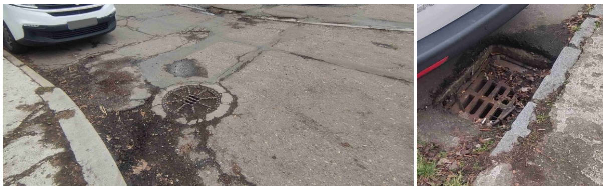
Obrázek 8 Popraskaná pozemní komunikace a propadlý kanalizační poklop
