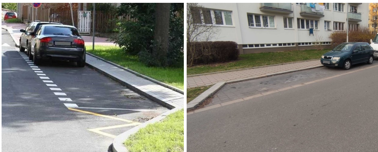
Obrázek 18 Vhodně označená podélně uspořádaná parkovací stání v zálivu
