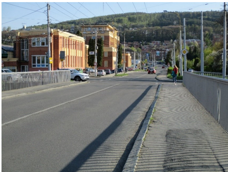
Obrázek 50 Úsek u vozovny (autorka)
