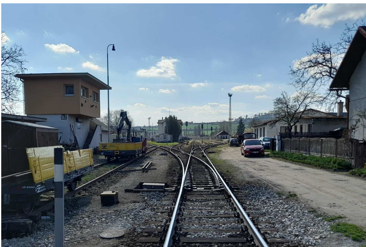
Fotografie 46 – celkový pohled na bransoužské zhlaví, vlevo odstavená mechanizace na koleji 4b a stavědlo 2
