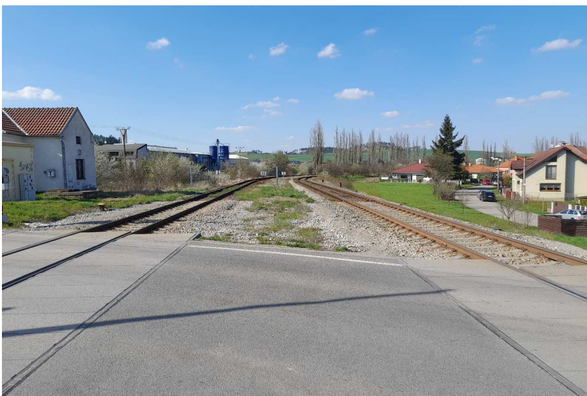
Fotografie 4 – pohled z přejezdu P3658 na souběh tratí 240 (vpravo) a 241 směr do stanice
