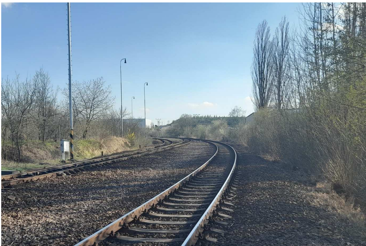
Fotografie 5 – vjezdový směrový oblouk s obloukovou kolejovou spojkou
