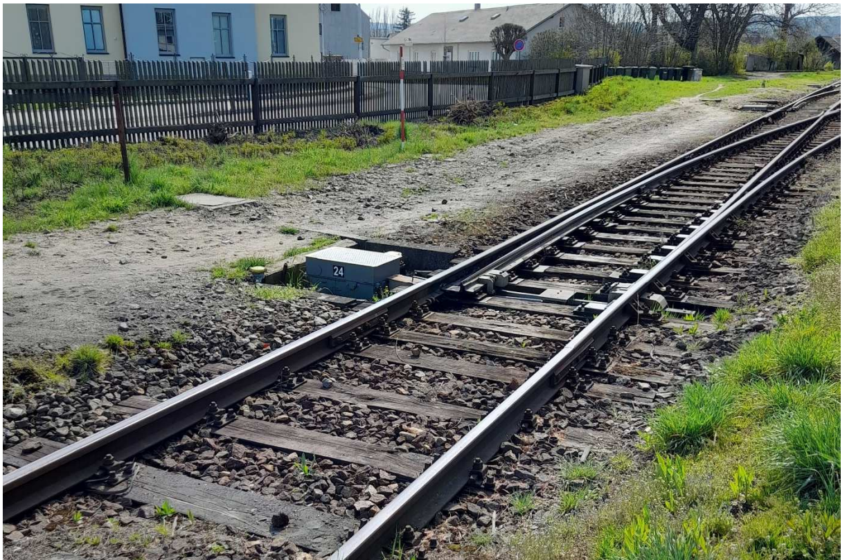
Fotografie 40 – výhybka č. 24
