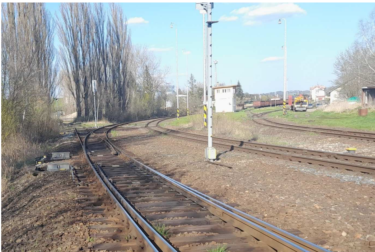
Fotografie 9 – výhybka č. 5 a 6, konec druhé obloukové kolejové spojky a odbočení na vlečku EIT Trading
