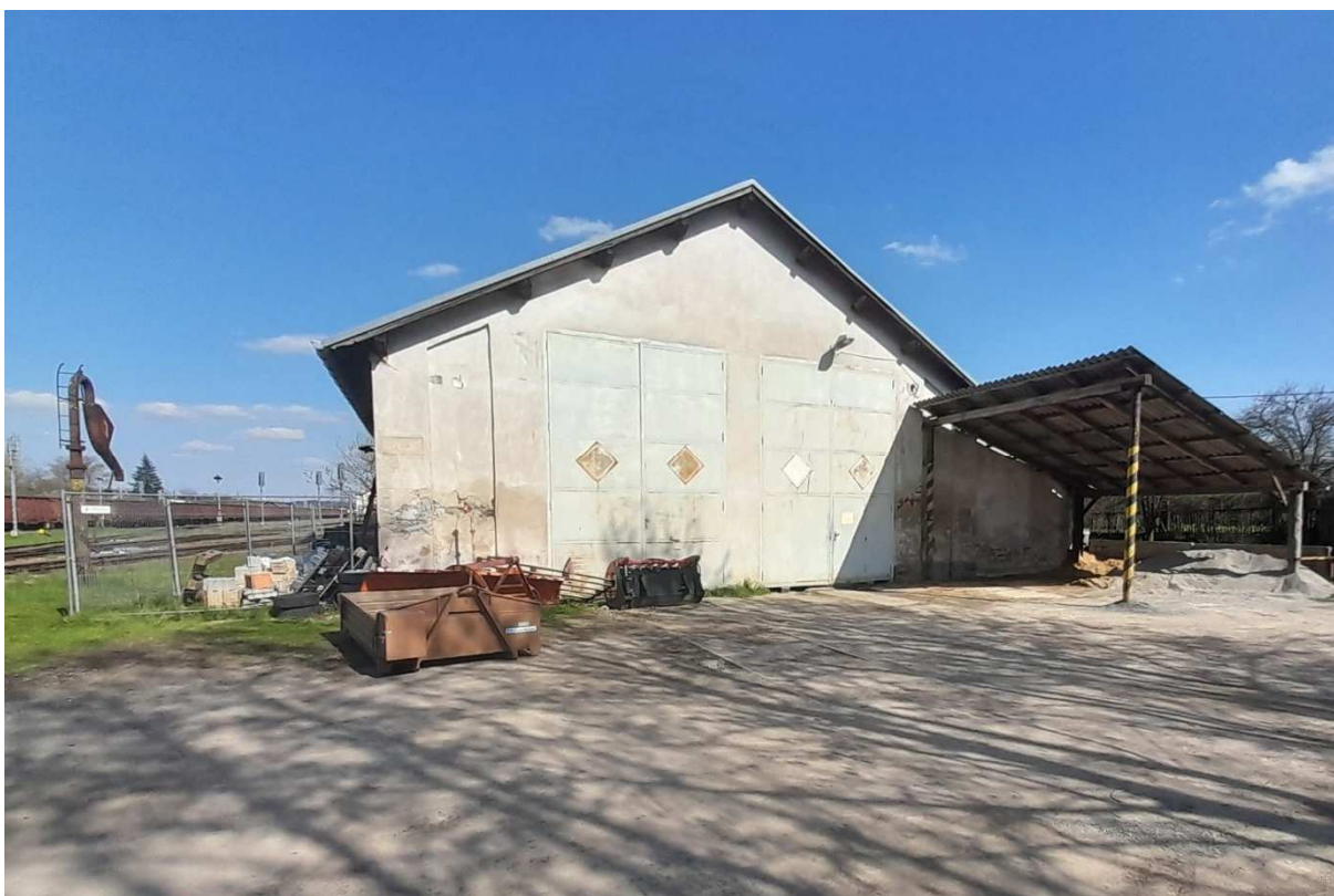
Fotografie 16 – budova bývalého depa
