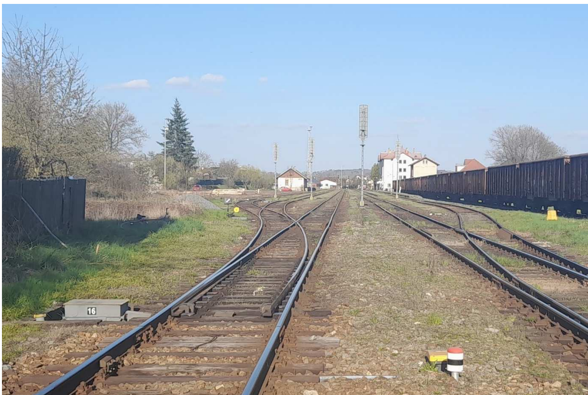
Fotografie 19 – výchybka č. 16, zkrácená mateční kolej, rozvětvení do kolejí 5 a 7
