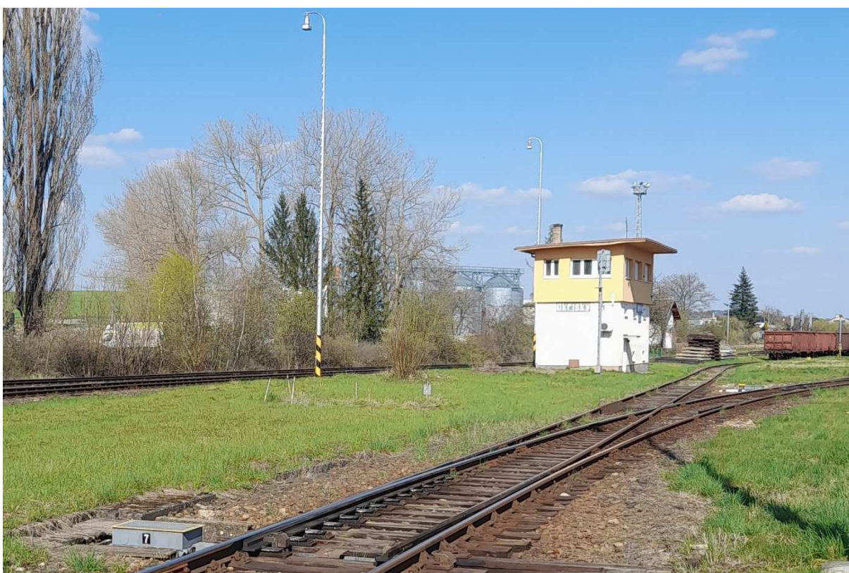
Fotografie 12 – výchybka č. 7, v pozadí budova stavědla 1
