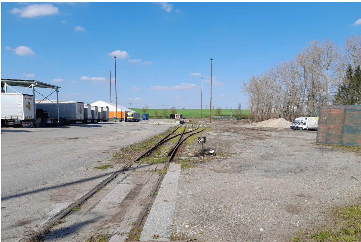
Fotografie 11 – kolejiště vlečky v areálu firmy EIT Trading s.r.o.
