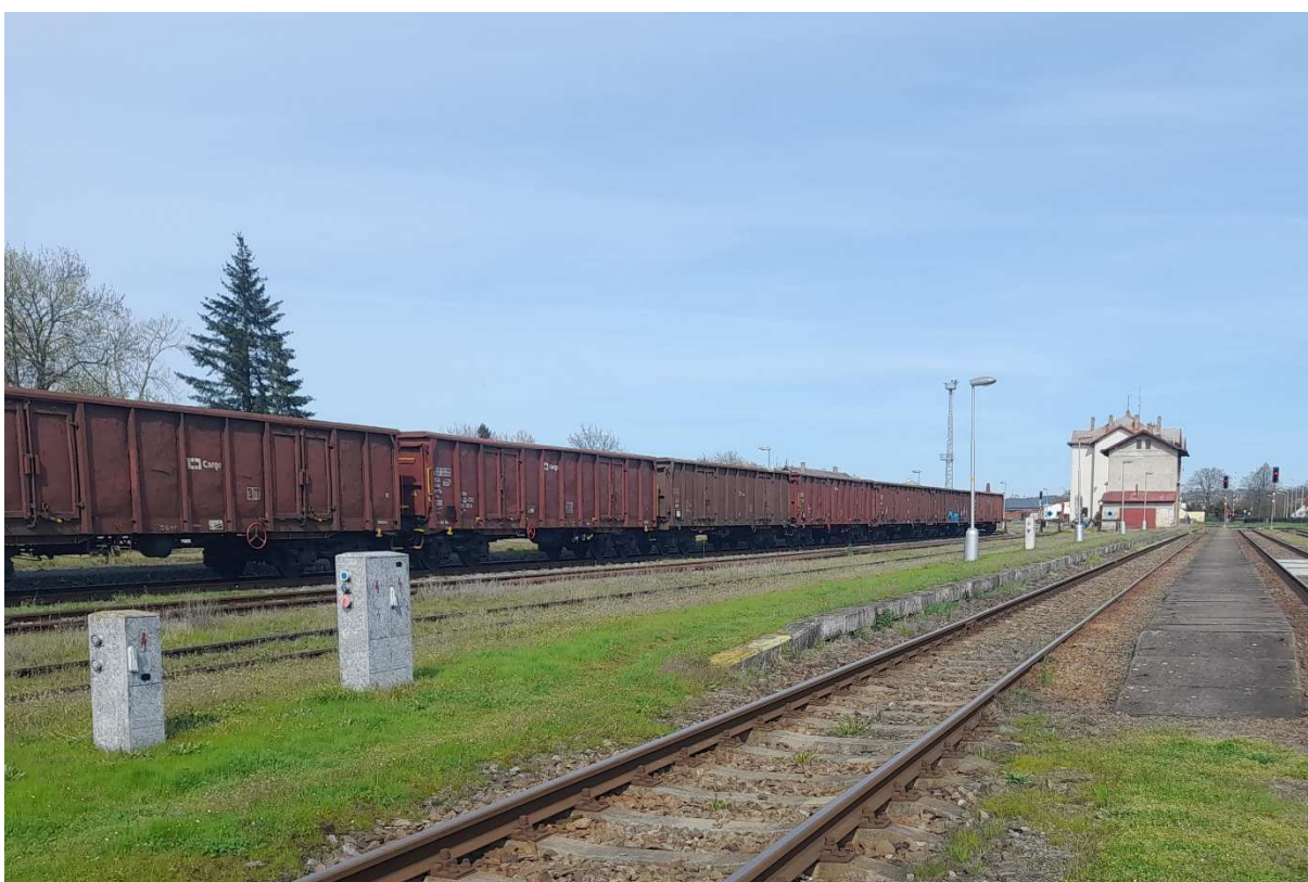
Fotografie 26 – zařízení pro vytápění vozů při odstavení souprav u desáté koleje
