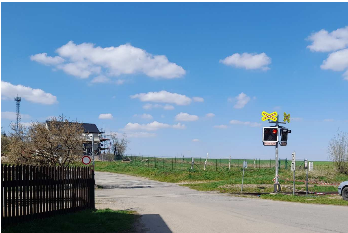
Fotografie 49 – železniční přejezd P3660
