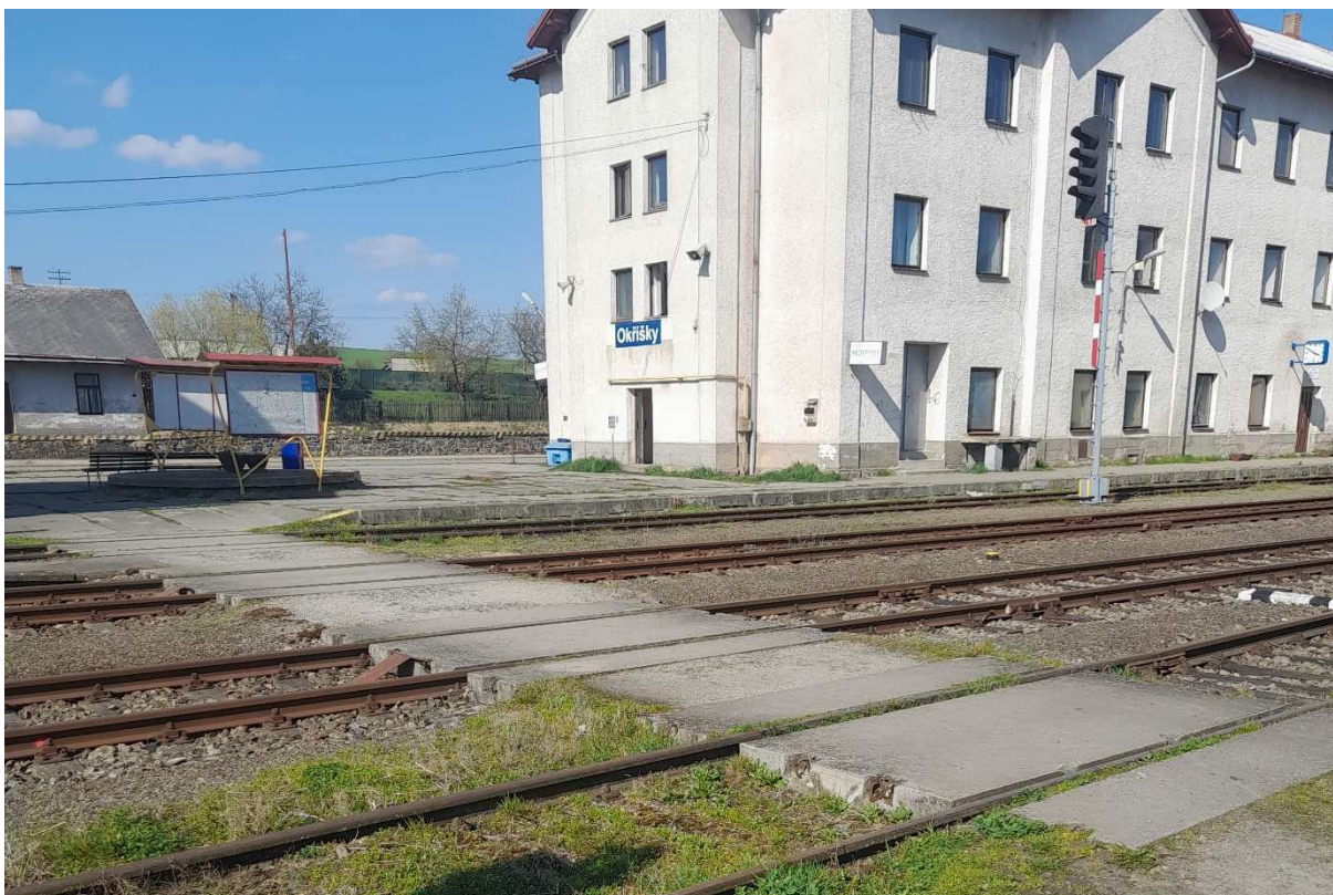
Fotografie 31 – přístup k nástupišti 2/2 přes desátou kolej, od 12. koleje slouží jako služební přechod
