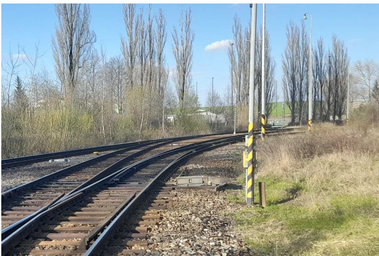
Fotografie 8 – výchybka č. 4, odbočení do sudých kolejí 4 – 18a
