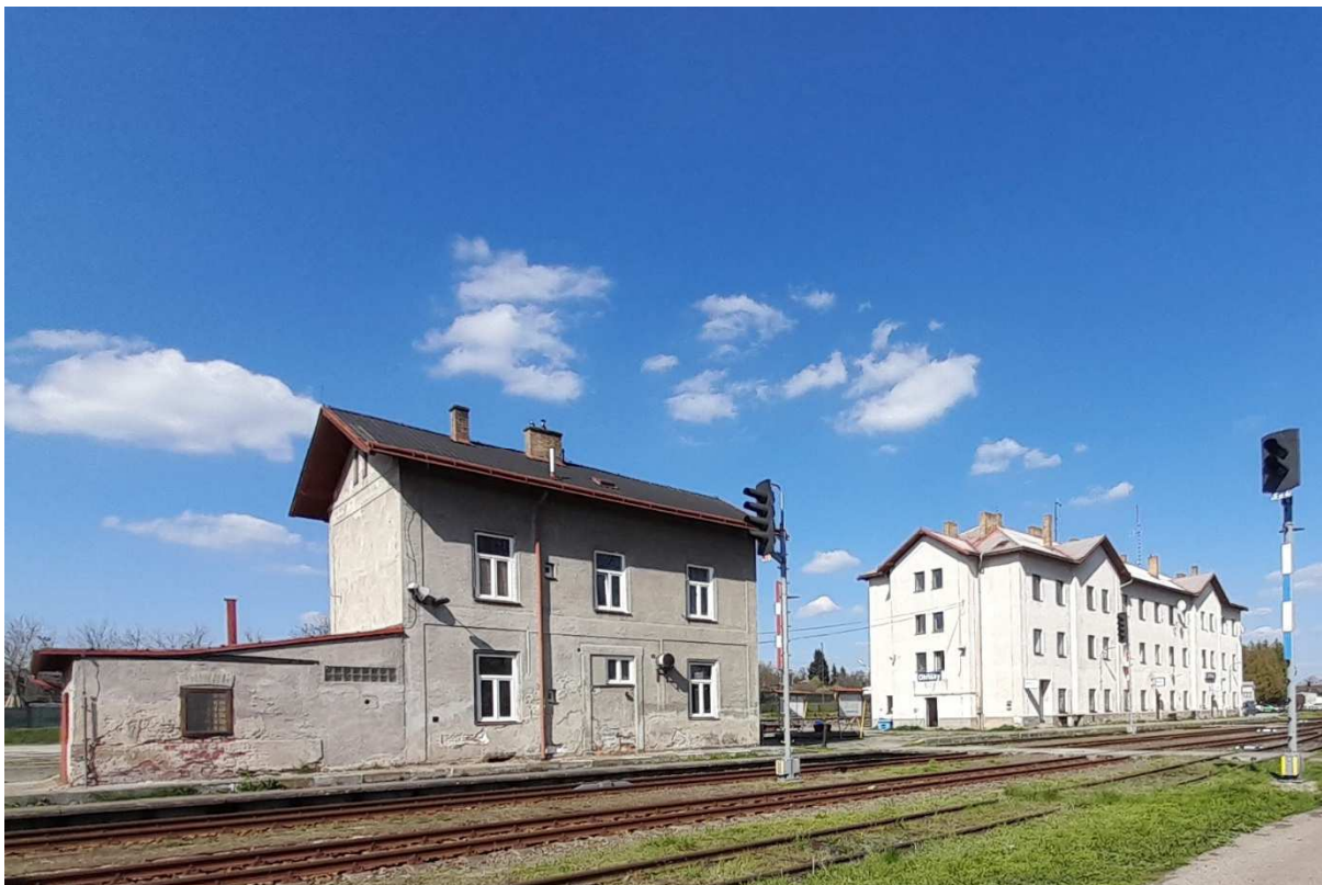
Fotografie 29 – bývalá a současná výpravní budova
