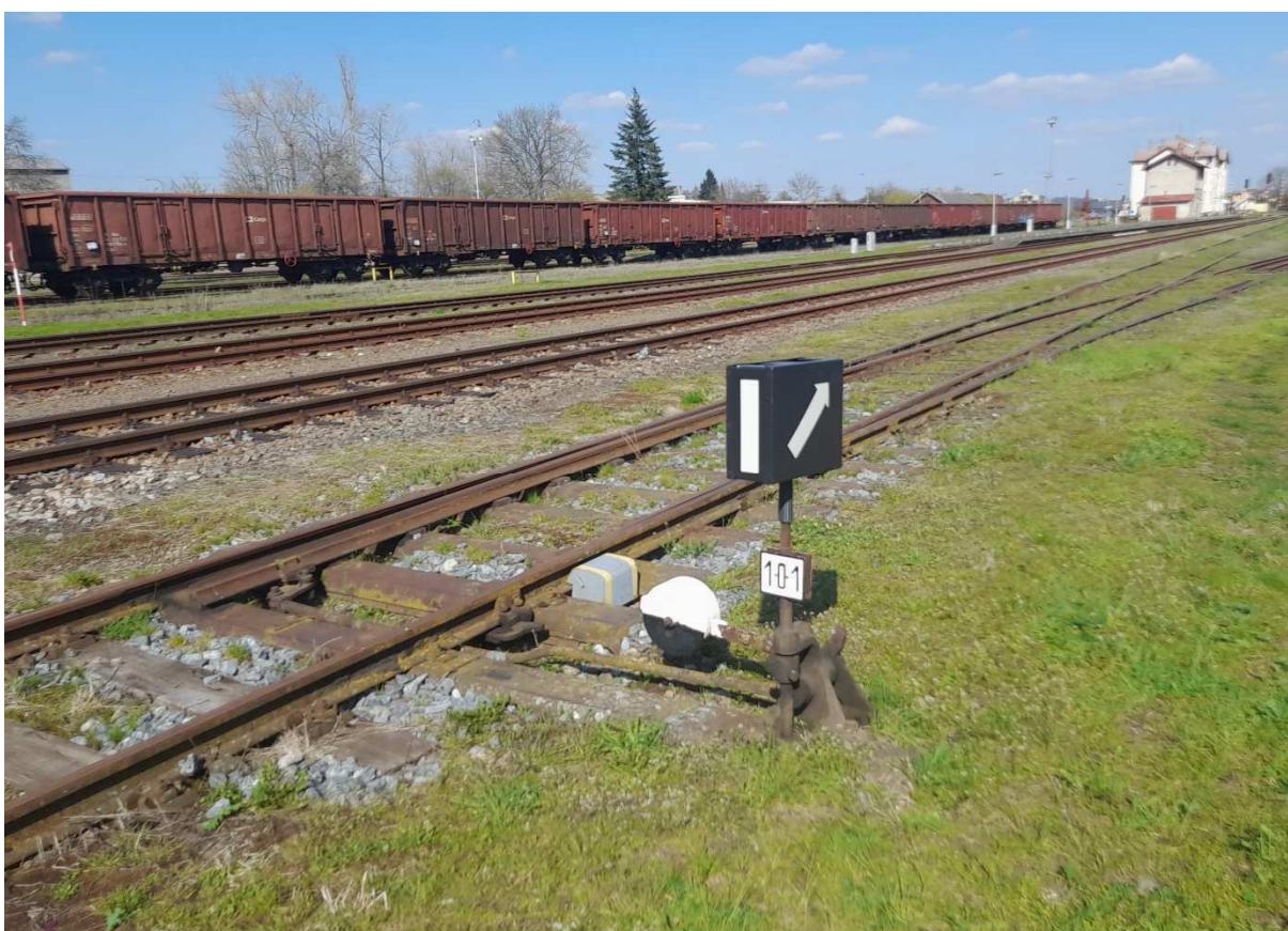
Fotografie 24 – výchybka č. 101, jediná výchybka ve tvaru A
