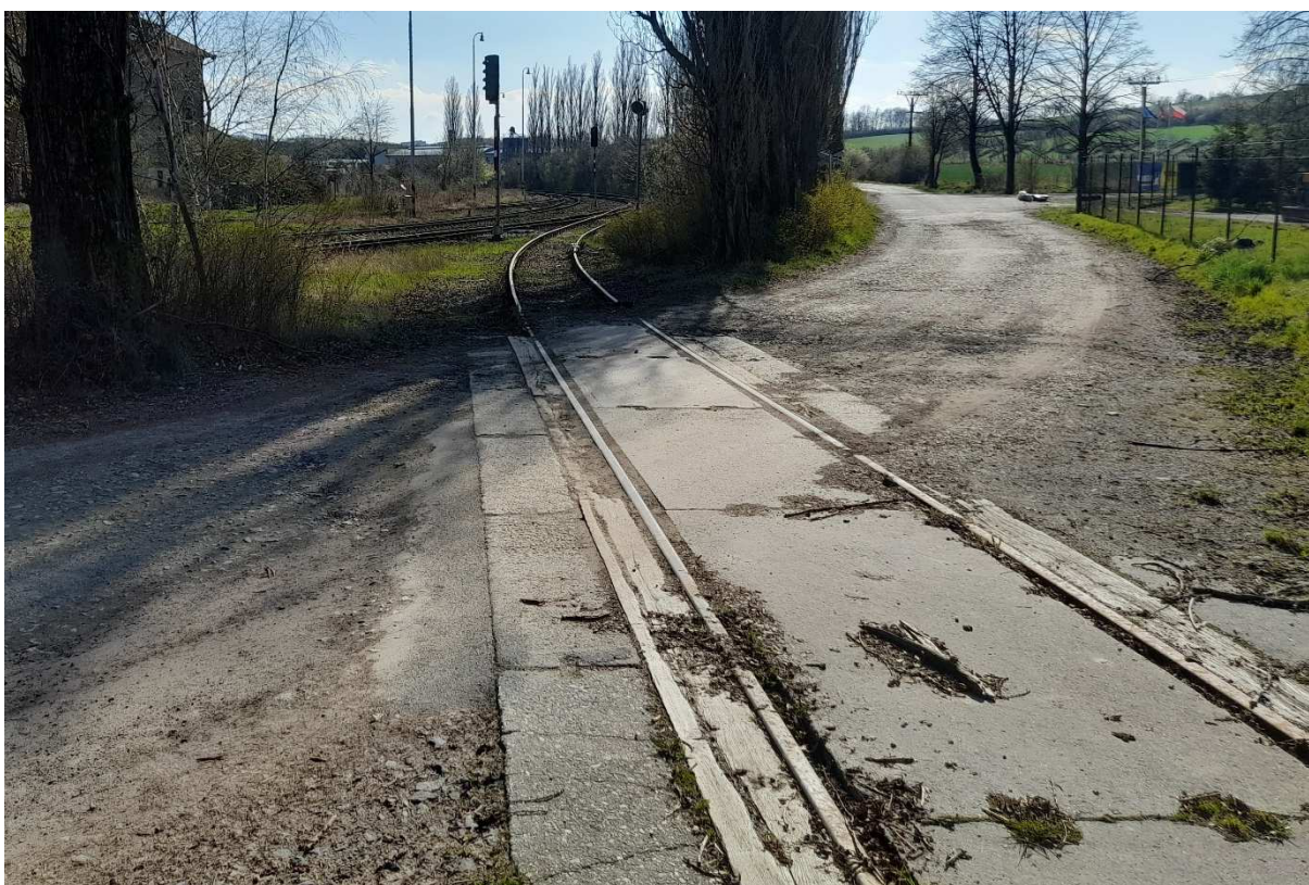
Fotografie 10 – příjezdová komunikace z ulice Za Tratí, křížení s vlečkou EIT Trading
