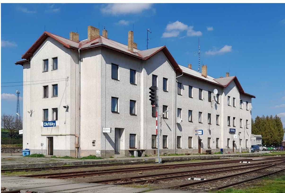
Fotografie 36 – výpravní budova
