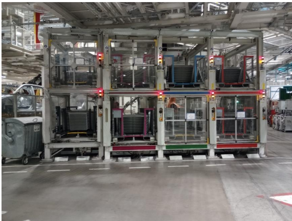
Obrázek 2.13 Zásobníky se střechami
