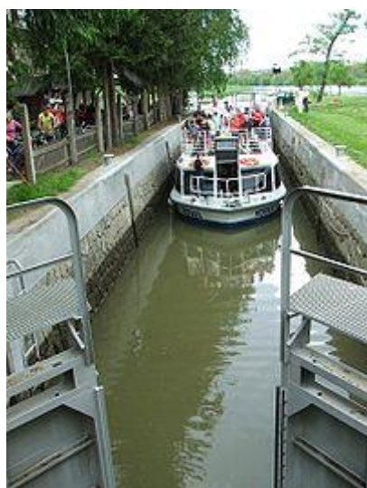
Obr. 27 Zdymadlo – Baťův kanál – plavební komora Spytihněv 25
