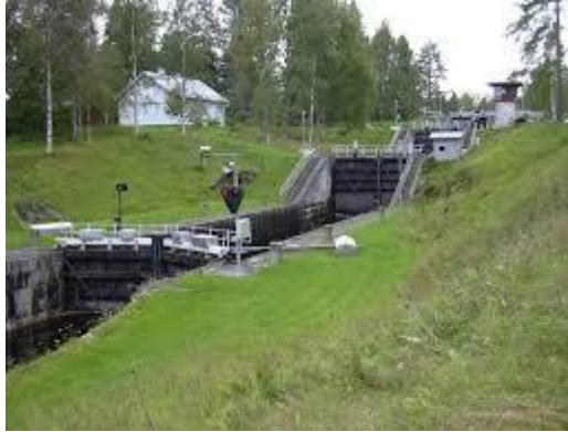
Obr. 29 Kaskáda zdymadel na Varistaipkaeském kanále ve Finsku 27
