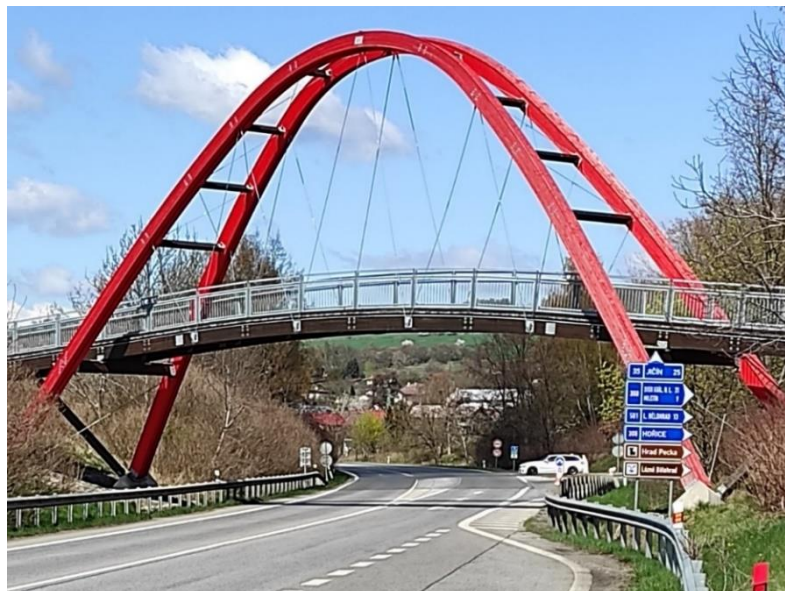
Obrázek 9 – Lávka přes silnici I/35
