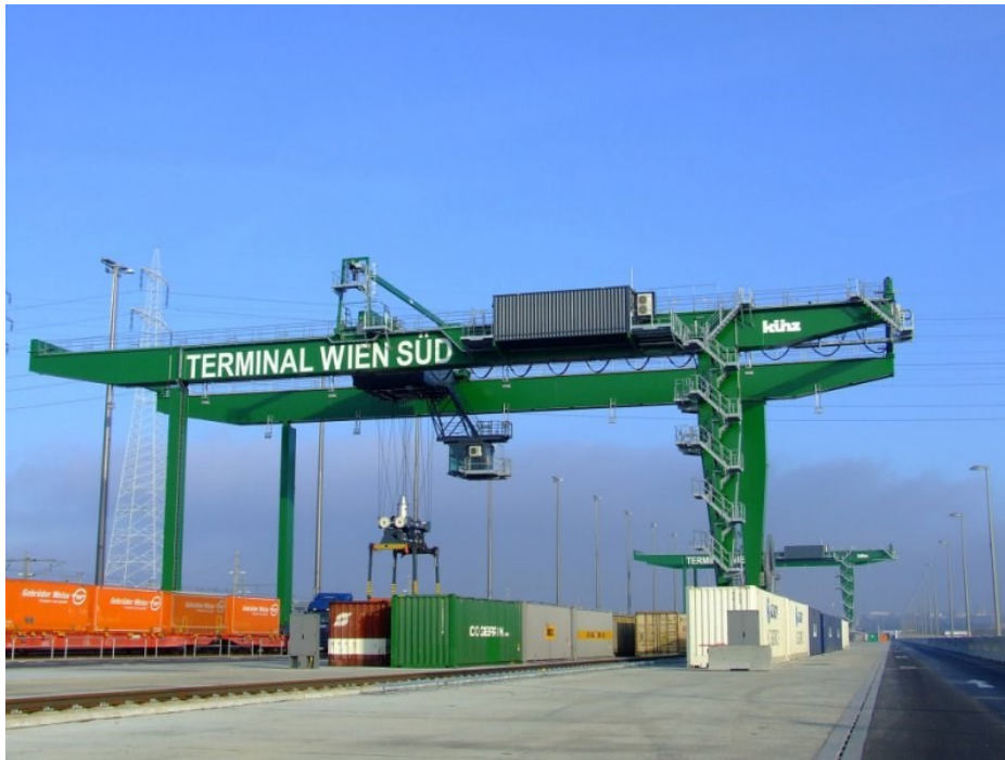
Obrázek 22 Portálový jeřáb (Terminal Wien Süd, 2021a)
