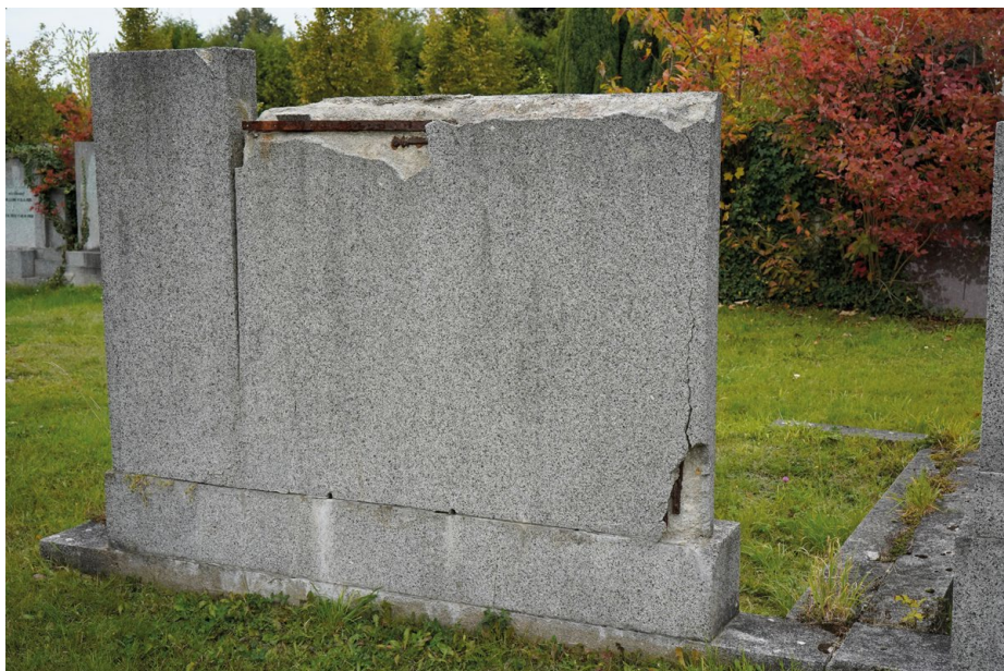
Obr. 24: (nahore) Degradace náhrobních stél z umělého kamene a terrazza je nejčastěji urychlená korozí železných armatur. Hřbitov v Hrádku nad Nisou.
