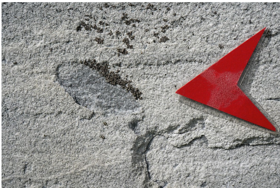
Obr. 39 a–b: Při focení detailů poškození nebo materiálu náhrobků je vhodné zhotovit také celkový snímek objektu s vyznačením fotografovaného detailu. Velikost měřítek by měla být přizpůsobená velikosti fotografované plochy. Obr. 40: (vpravo nahoře) Pro focení s makroobjektivem je vhodné využít měřítko v rozměru několika málo cm, aby nezasahovalo do fotografované plochy. Hřbitov v Javorníku.
