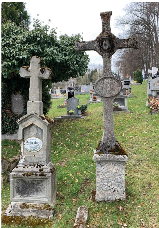
Obr. 24: (nahore) Degradace náhrobních stél z umělého kamene a terrazza je nejčastěji urychlená korozí železných armatur. Hřbitov v Hrádku nad Nisou.
