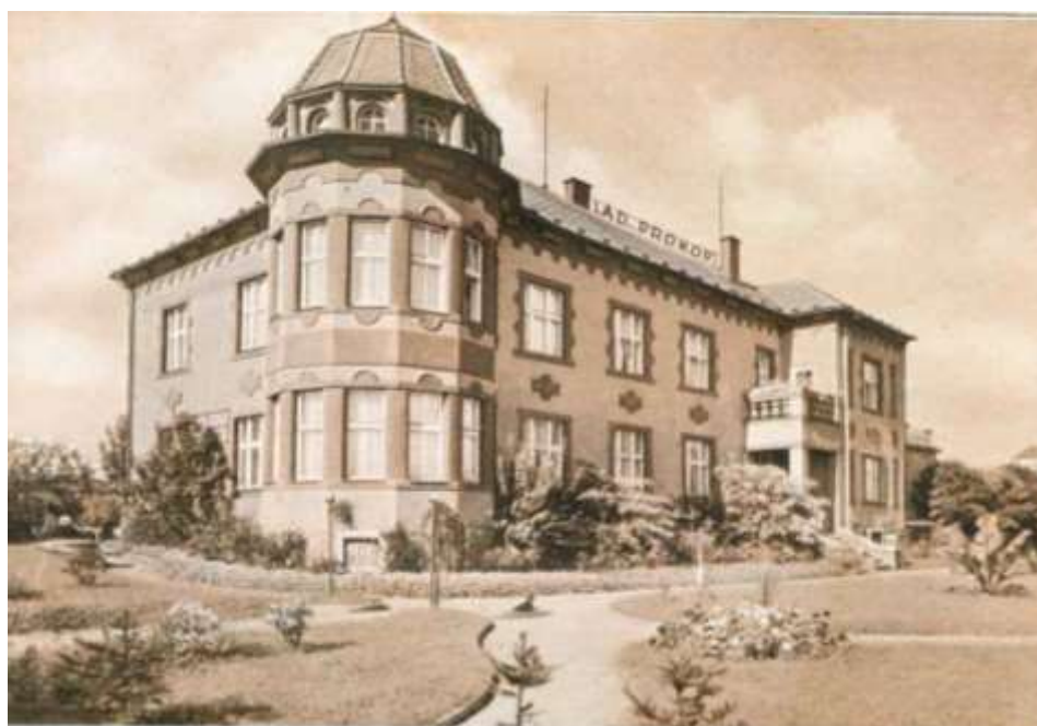
Obrázek 174. Stav přibližně v roce 1925 (dobová pohlednice)
