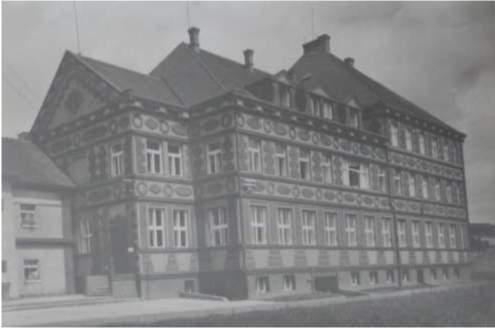
Obrázek 27. Fotografie správní budovy firmy Sochor z doby výstavy (Archiv architektury MAS NTM, f. 85 Janák, fotografie autorka)
