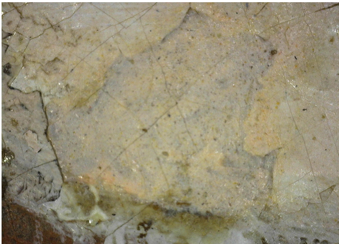
Obr. 90 Průběh restaurování, detail vytmeleného defektu
