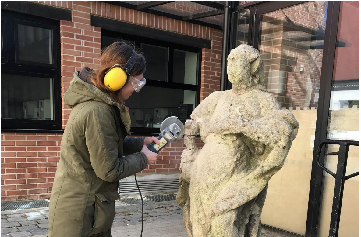
Obrázek 136 Odstraňování cementových tmelů úhlovou bruskou
