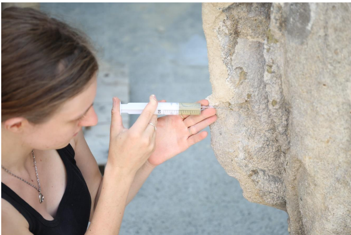
Obrázek 150 Injektování dutin pod krustami maltovinou Ledan TAI, figura
