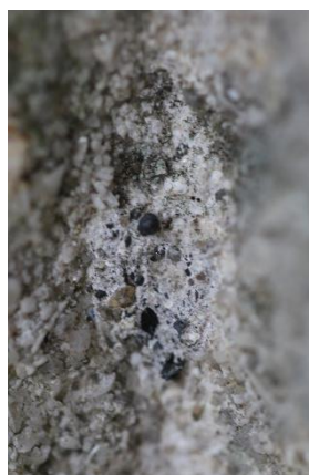
Obrázek 38 Detail vrstvy nátěru
