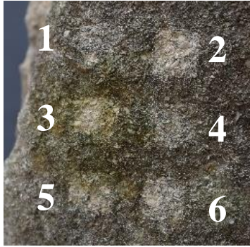
Obrázek 42 Zkouška čištění červené řasy, plášť
