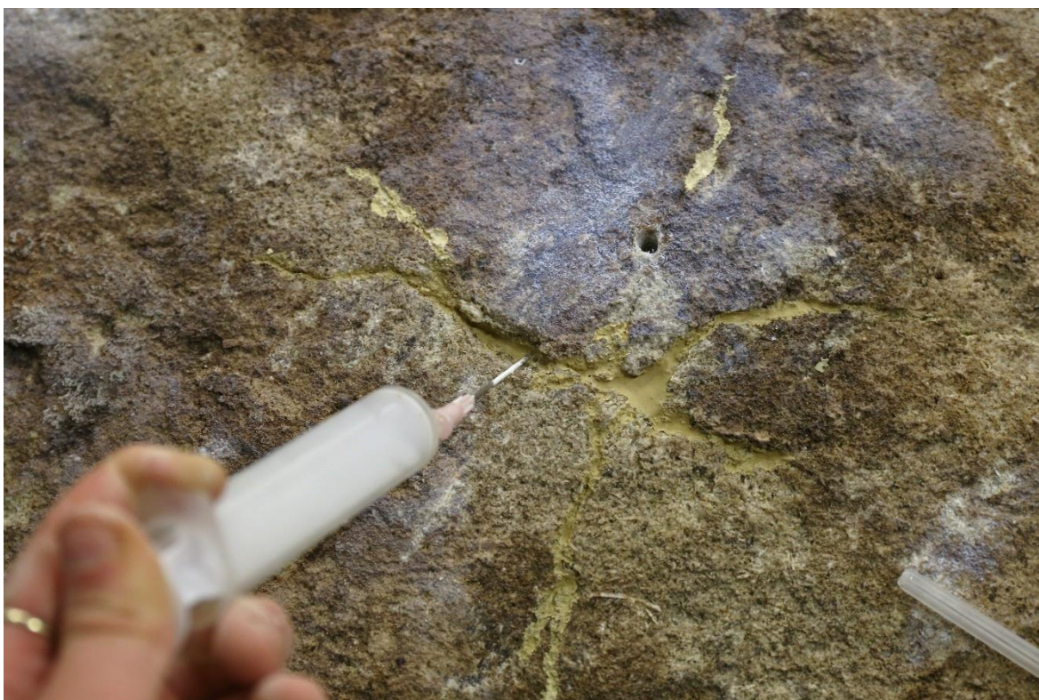
Obrázek 151 Injektování maltoviny Ledan TAI do prasklin, hlavice
