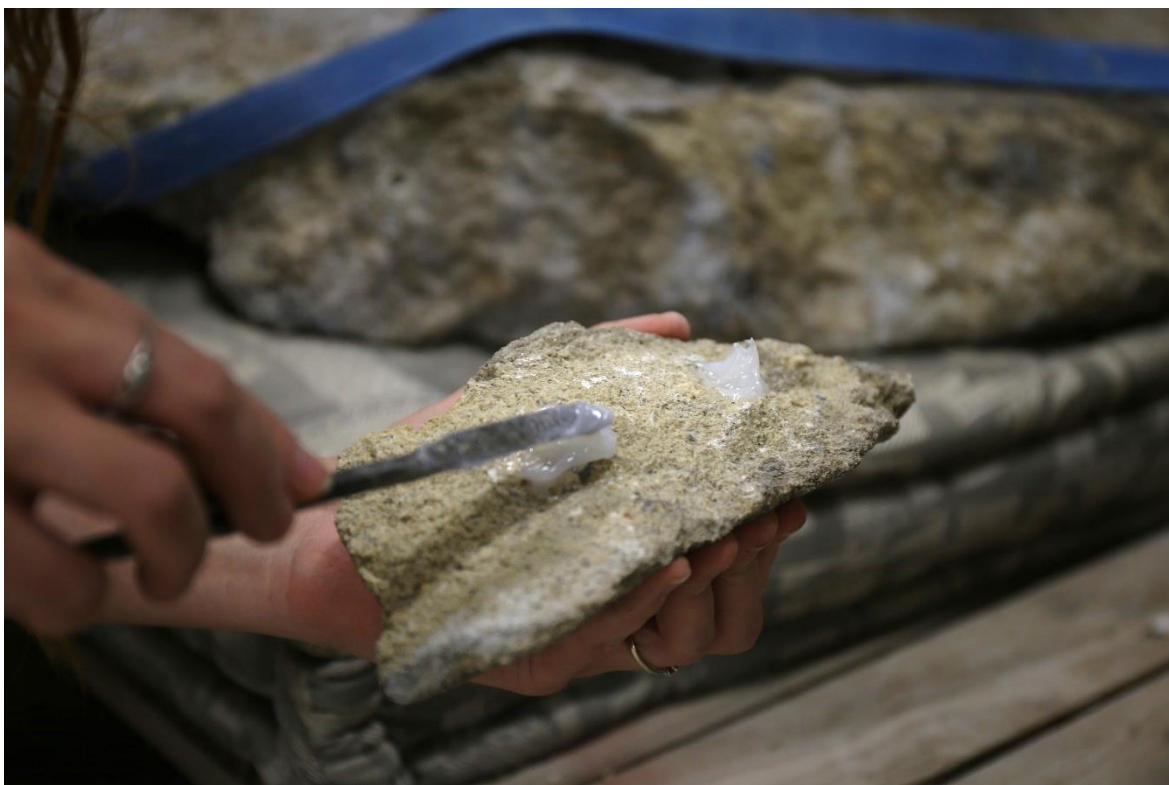
Obrázek 148 Aplikace epoxidové pryskyřice Akepox 5010 na styčnou plochu
