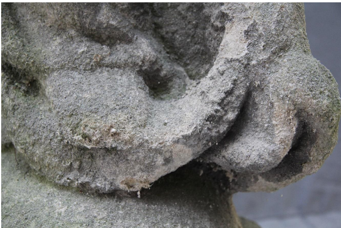
Obrázek 113 Detail narušeného kamene solemi
