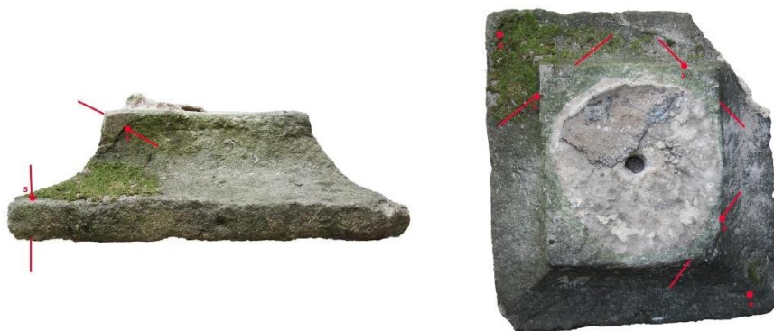
Obr. 6 a, b: Lokalizace míst měření rychlosti UZ transmise na podstavci k plastice Panny Marie Immaculaty z Hoješína. Hodnoty rychlosti UZ transmise jsou uvedeny v Tab. 2 .
