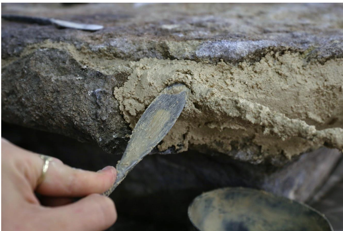
Obrázek 159 Vrstvení vápenného tmelu na nerezovou armaturu, hlavice
