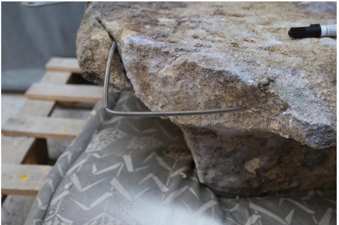
Obrázek 153 Detail nové nerezové armatury rohu hlavice
