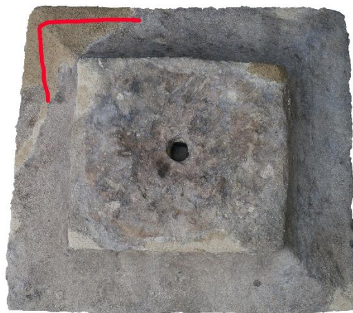
Obrázek 90 Hlavice, nová armatura
