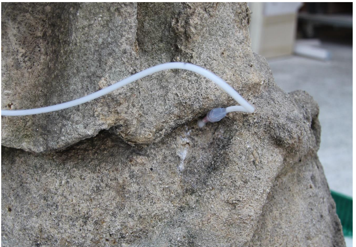
Obrázek 143 Detail místa aplikace konsolidantu do materiálu pomocí infuze
