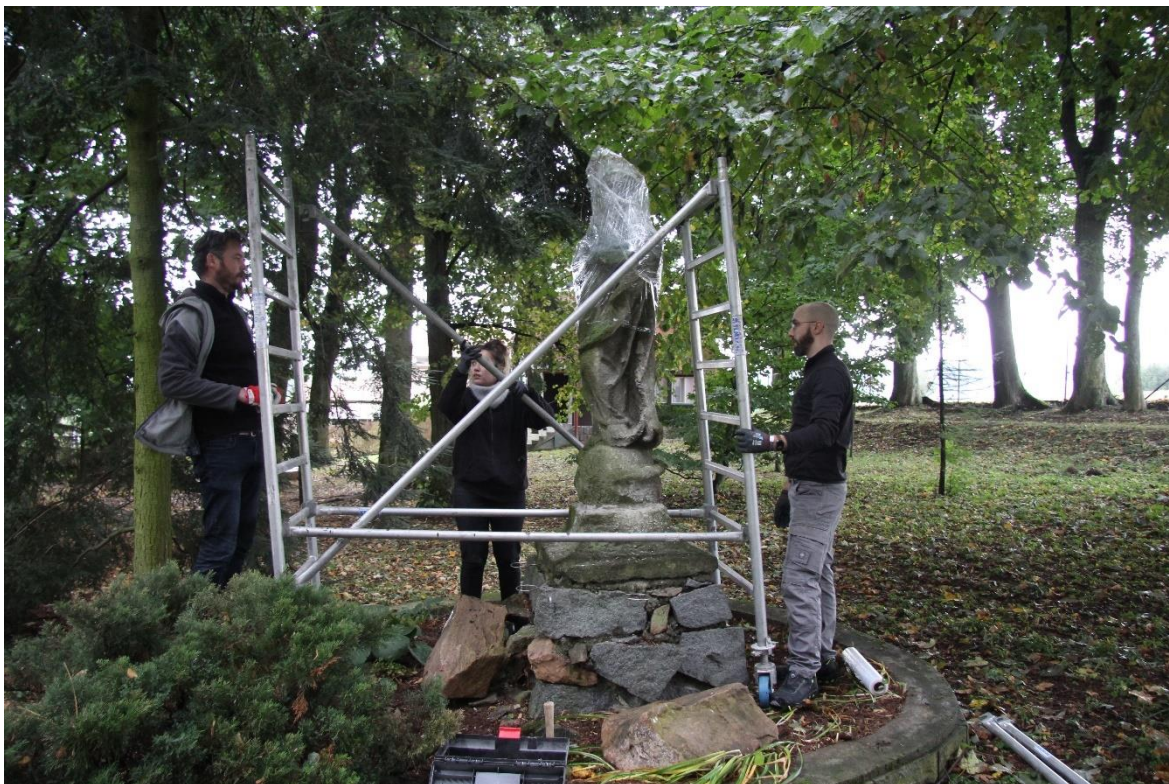
Obrázek 126 Stavba lešení pro zvednutí figury
