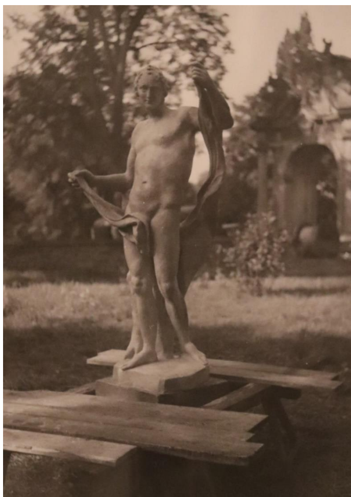
Obr. 2. Fotografie z roku 1965 po restaurátorském zásahu, originál z Konopiště
