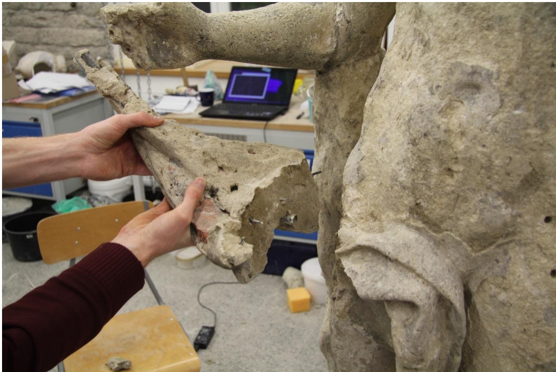
Obr. 89. Odstranění dožilého doplňku draperie
