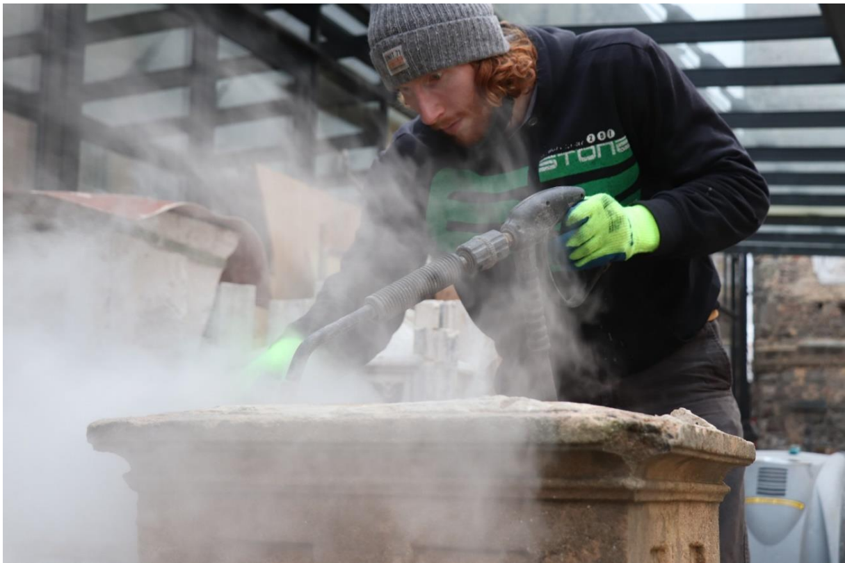
Obr. 86. Čištění biologického napadení za pomoci vodní páry
