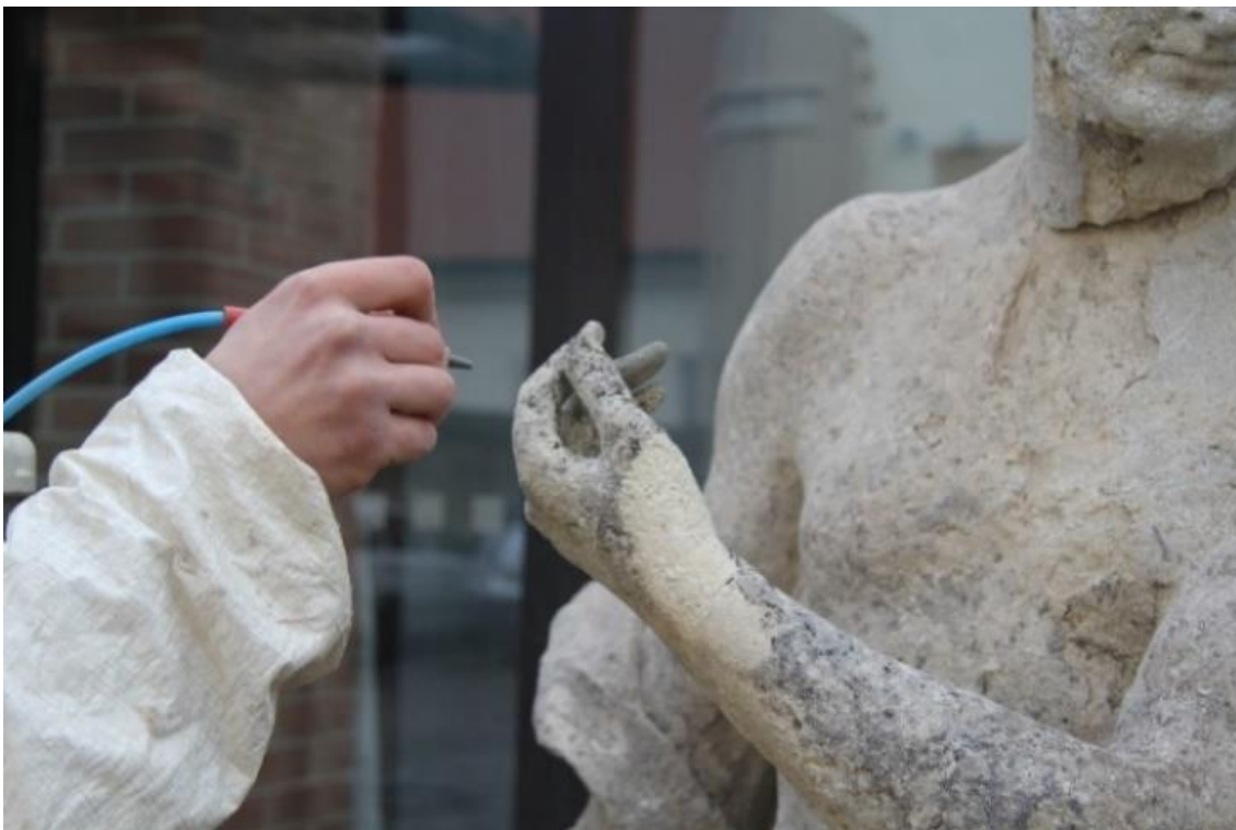
Obrázek 51 abrazivní čištění skulptury Apollóna od biologického napadení
