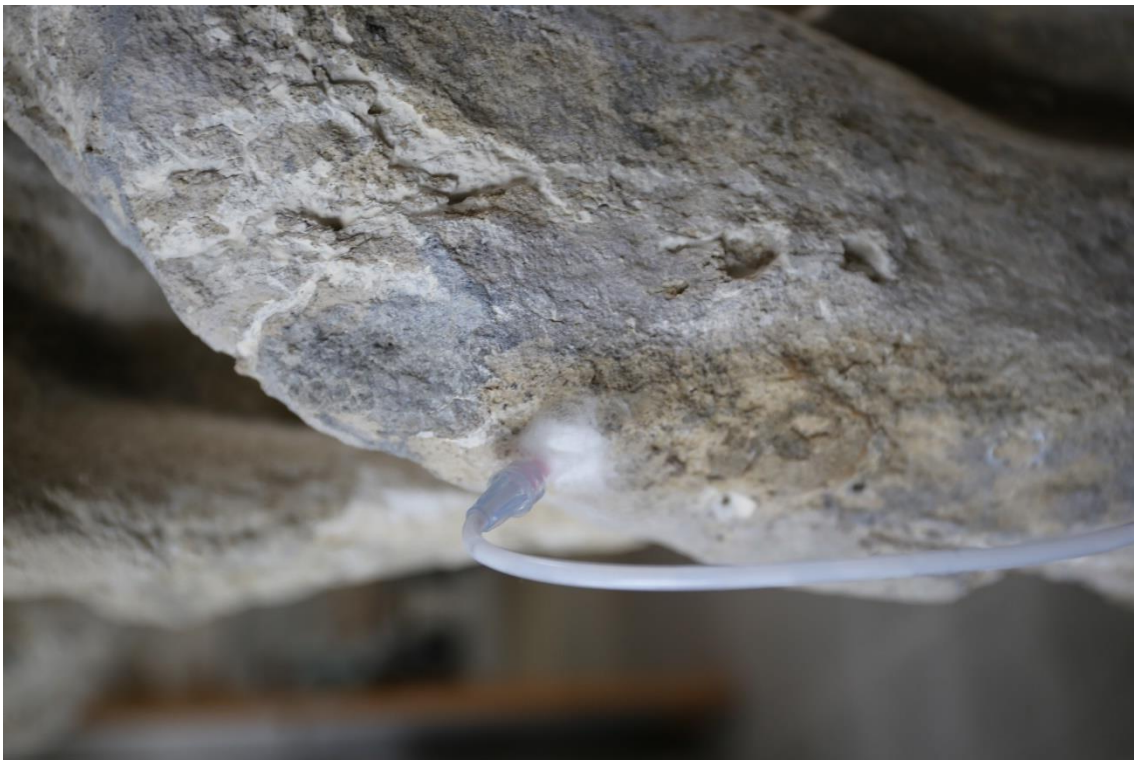
Obrázek 56 strukturální konsolidace sochy Apollóna organo-kremičitanem pomocí infuze
