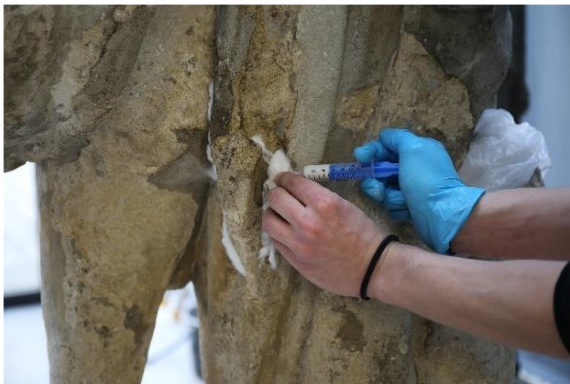
Obrázek 54 injektování prasklin skulptury Apollóna
