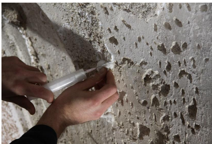
Obrázek 14 Průběh injektování
