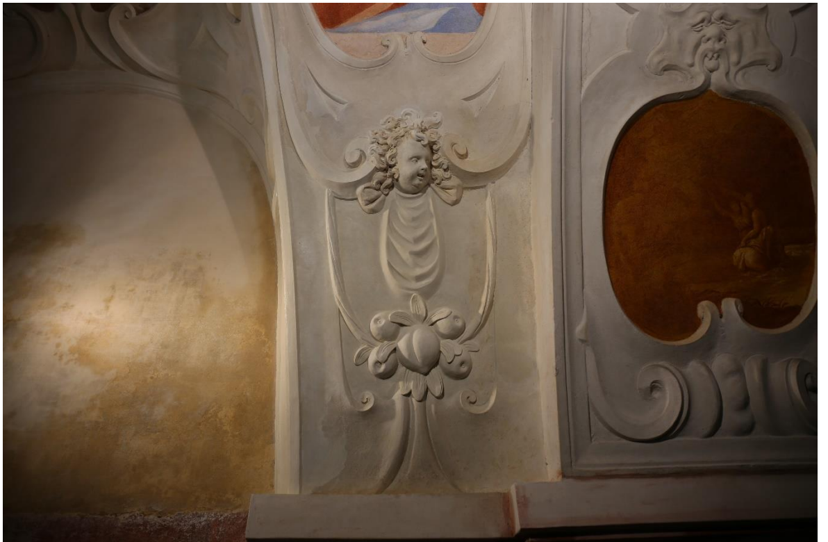
Obrázek 51 Pohled na klenební pas po plastické retuši
