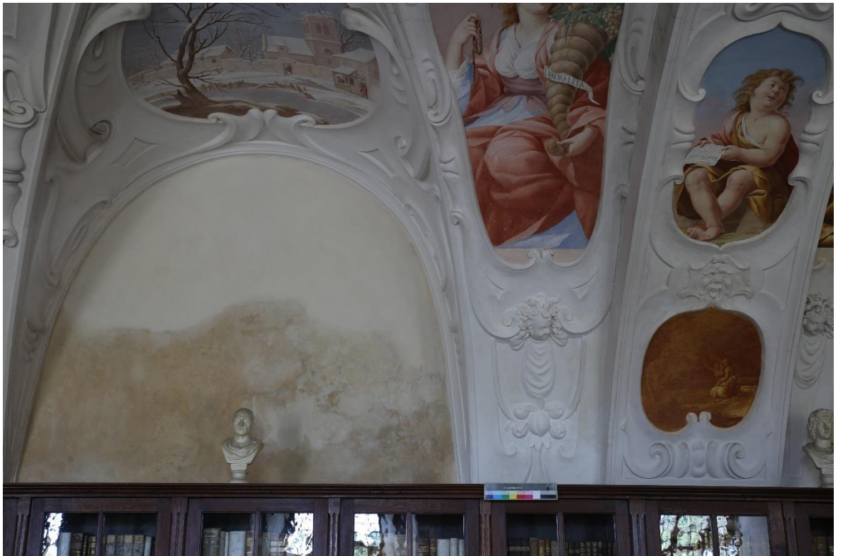
Obrázek 52 Stav po restaurování (po aplikaci vápenného nátěru)
