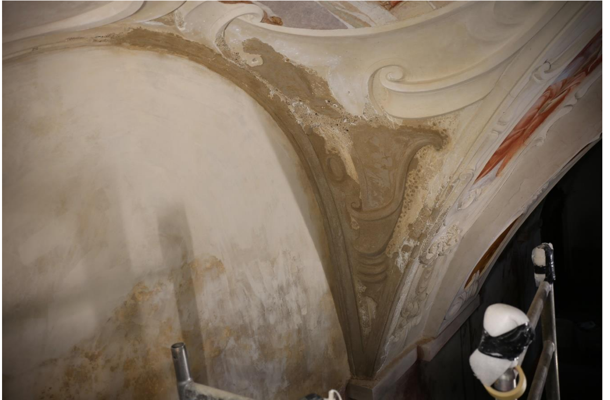
Obrázek 41 Nanášení jádrové malty na trojbokou výseč klenebního pasu (kartuš)
