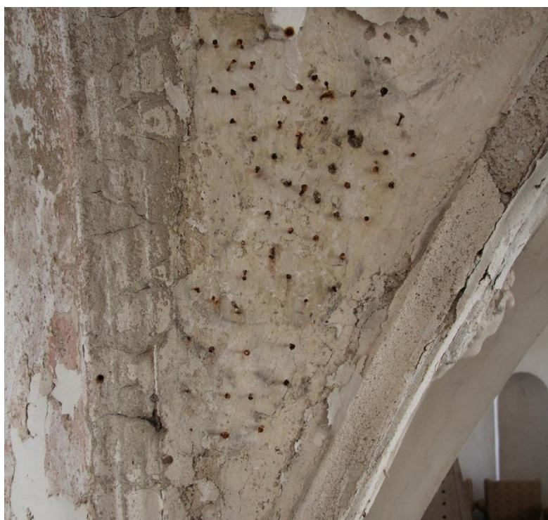
Obrázek 32 Trojboká výseč – pohled na hřebíčky a podkresbu po odstranění sádrové vysrávky
