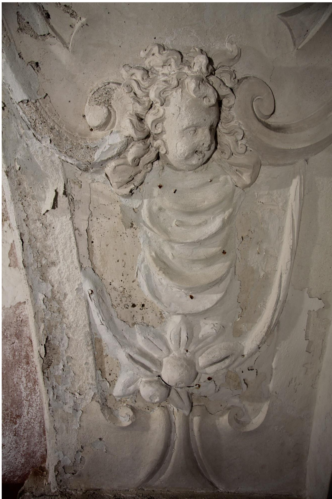
Obrázek 28 Hlava putta se sádrovými vysprávkami
