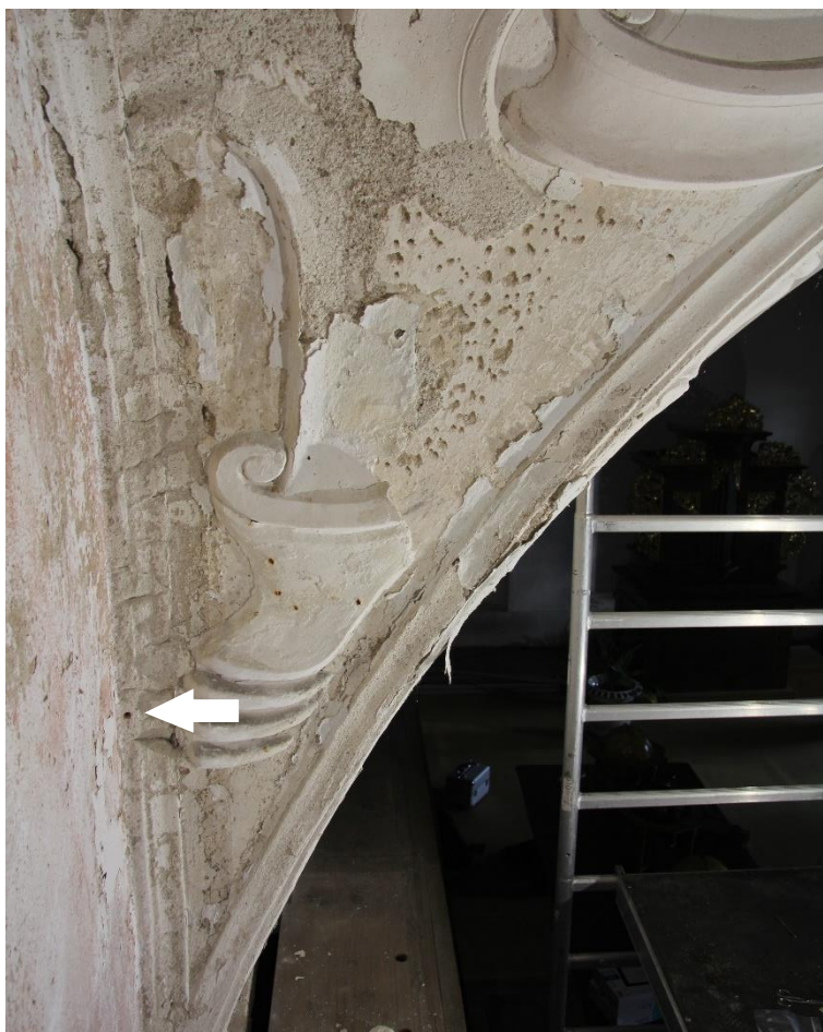
Obrázek 6 Místo odběrů vzorků na přítomnost vodorozpustných solí
