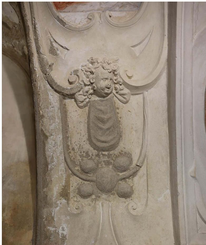
Obrázek 42 Nanášení jádrové malty (stuhý s ovocným festonem, uzly drapérie)
