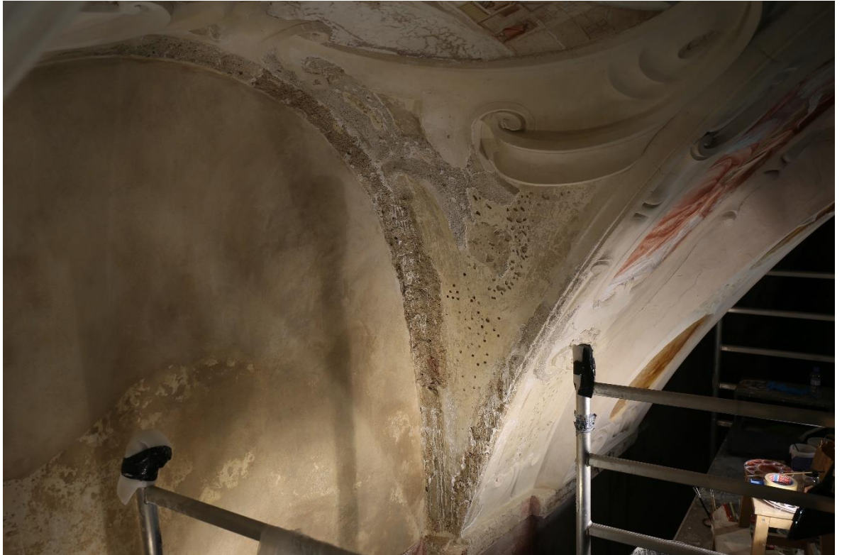
Obrázek 35 Trojboká výseč – zpevněný, vyinjektovaný a očištěný povrch od sekundárních vrstev a vysprávek
