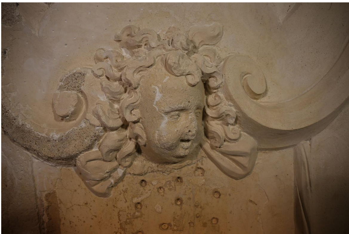
Obrázek 37 Detail hlavy putta – očištěný, zpevněný a vyinjektovaný povrch
