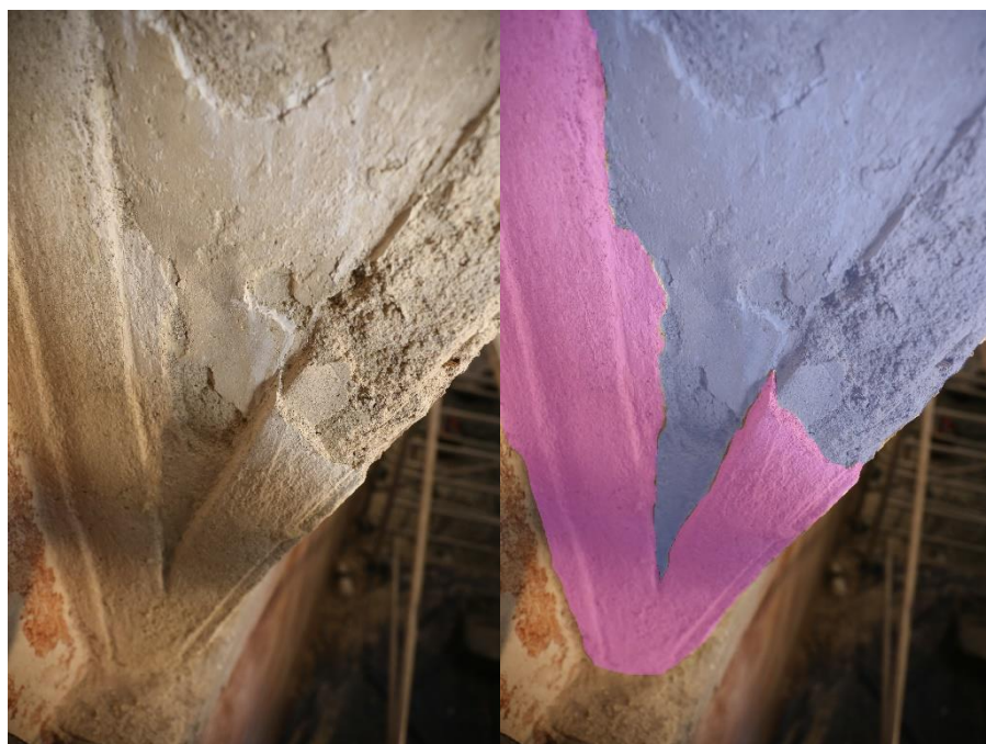
Obrázek 13 Růžová – sekundární štuková vrstva; Modrá – originální vrstva
