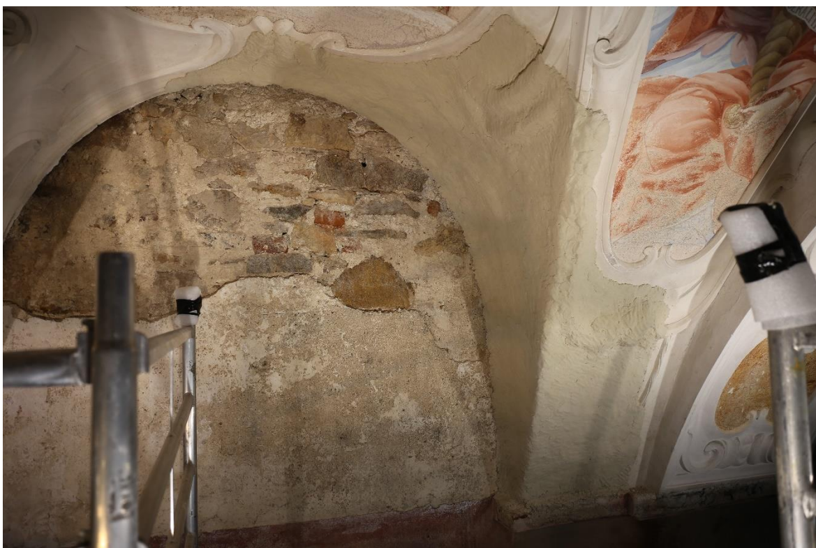
Obrázek 38 Odsolovací zábal
