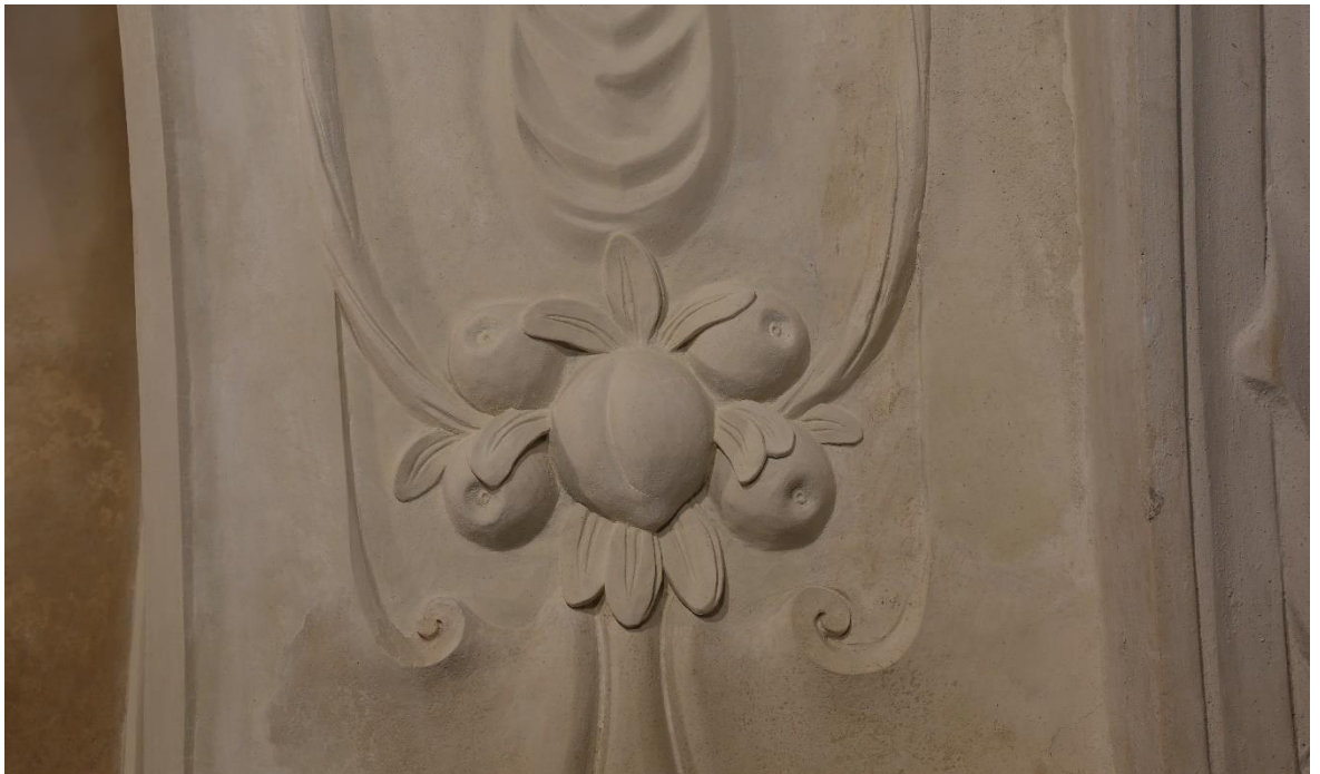
Obrázek 49 Detail plastické rekonstrukce stuh s ovocnou kompozicí
