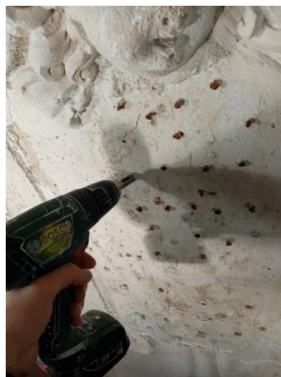
Obrázek 12 Odstraňování hřebíčků pomocí jádrového vrtáku
