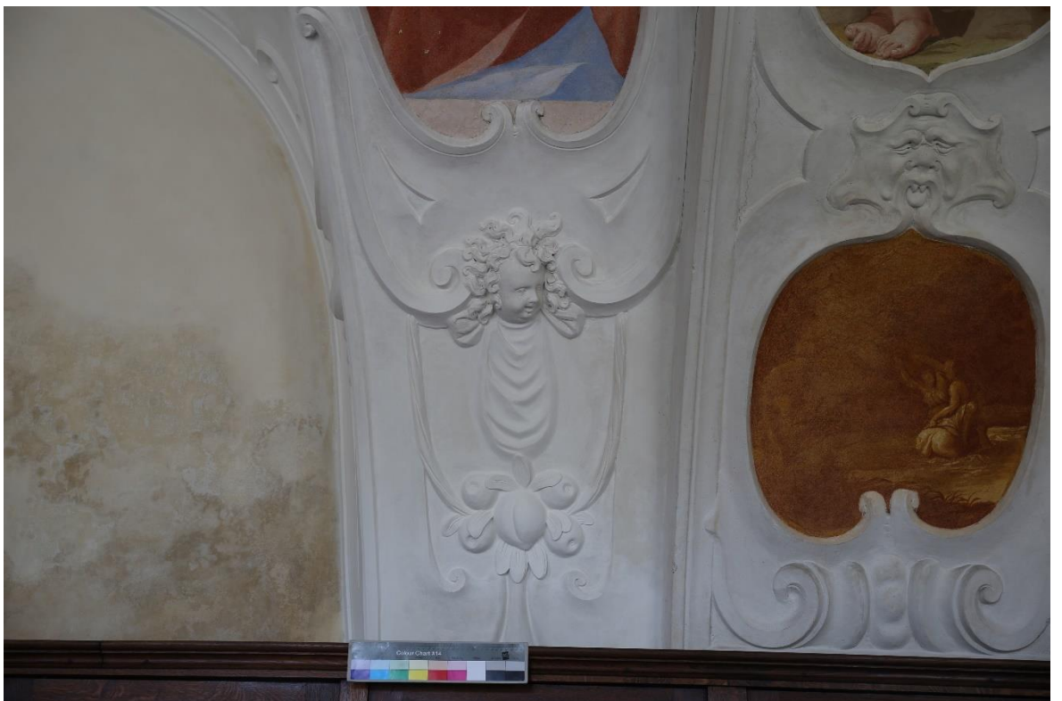
Obrázek 53 Pohled na klenební pas – stav po restaurování
