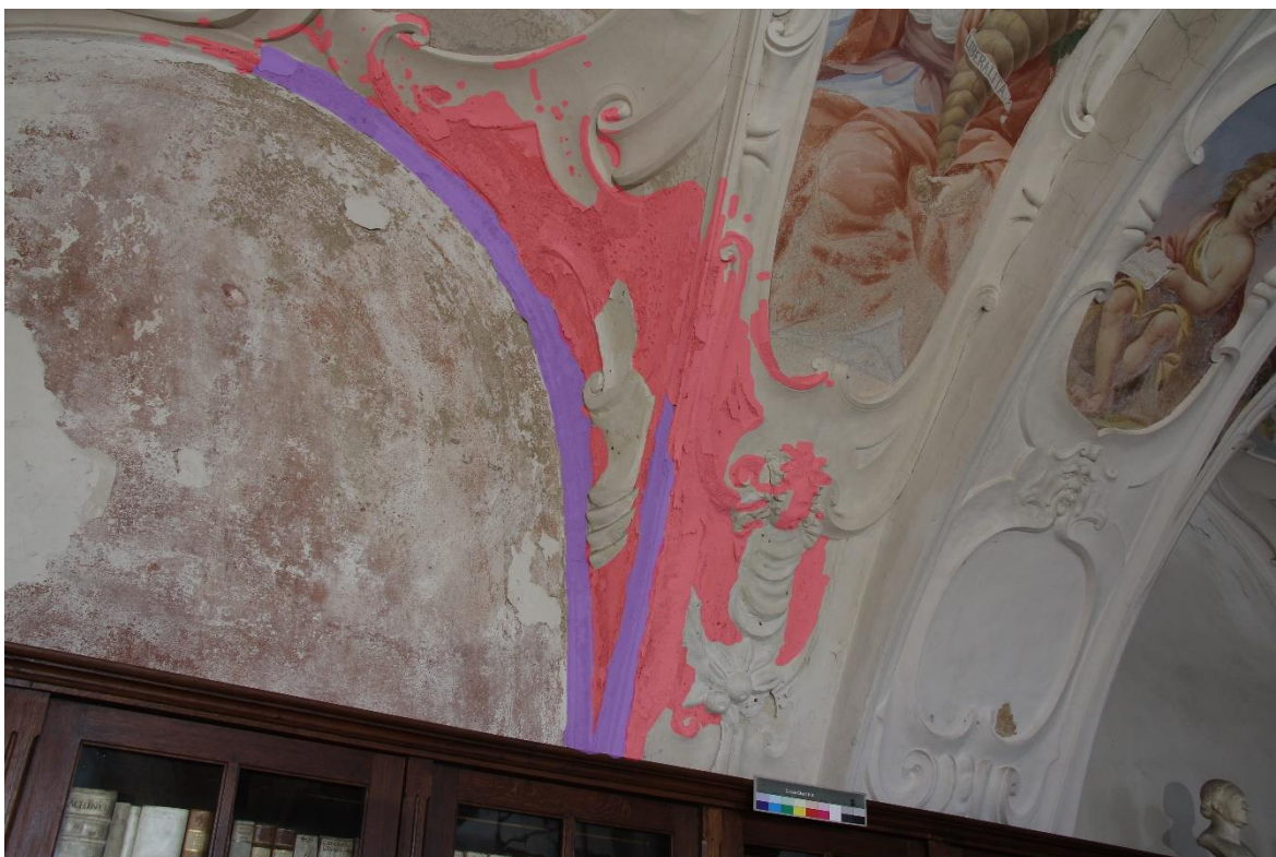
Obrázek 18 Zákres degradovaného materiálu a sekundární štukové vrstvy
