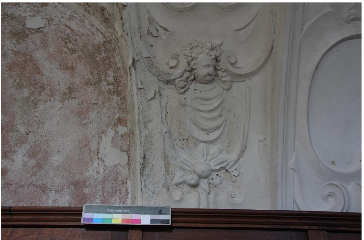
Obrázek 23 Přední pohled na klenební pas s hlavou putta a nevhovující sádrovou vysprávkou
