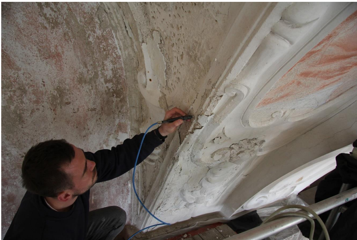
Obrázek 31 Odstraňování sádrových vysrávek
