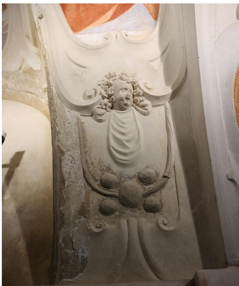
Obrázek 44 Průběh tmelení klenebního pasu (jemná finální vrstva)
