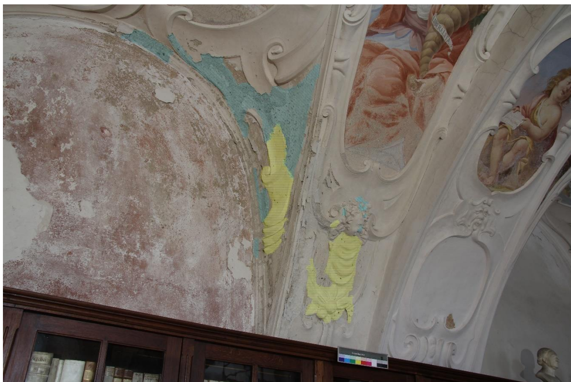
Obrázek 17 Zákres sádrových vysprávek a chybějící plastické modelace
