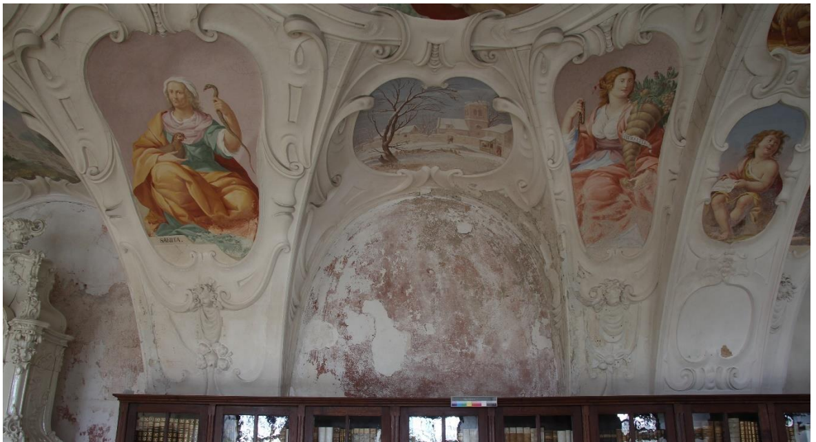
Obrázek 22 Celkový pohled na restaurovanou část
