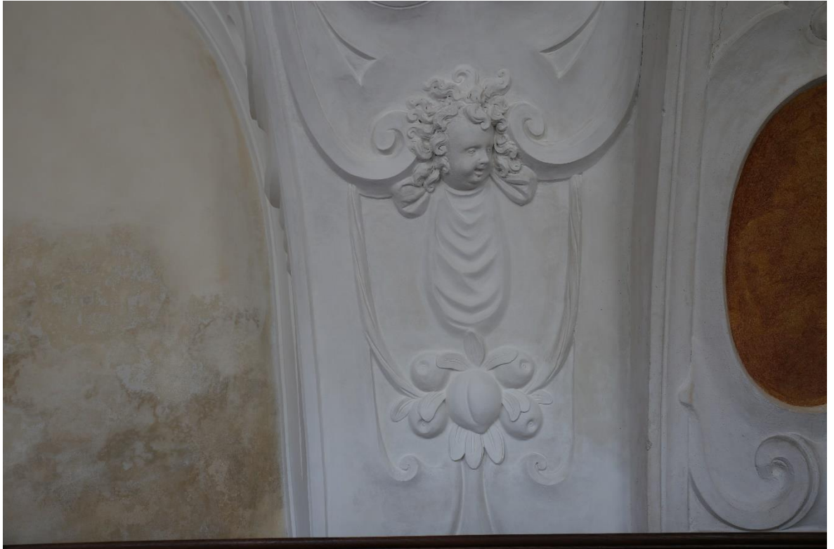
Obrázek 56 Pohled na klenební pas – stav po restaurování
