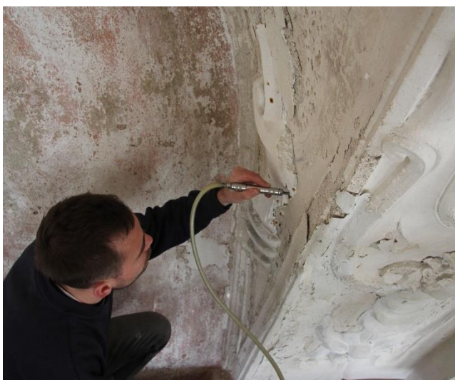
Obrázek 11 Odstraňování sádrové vysprávky
