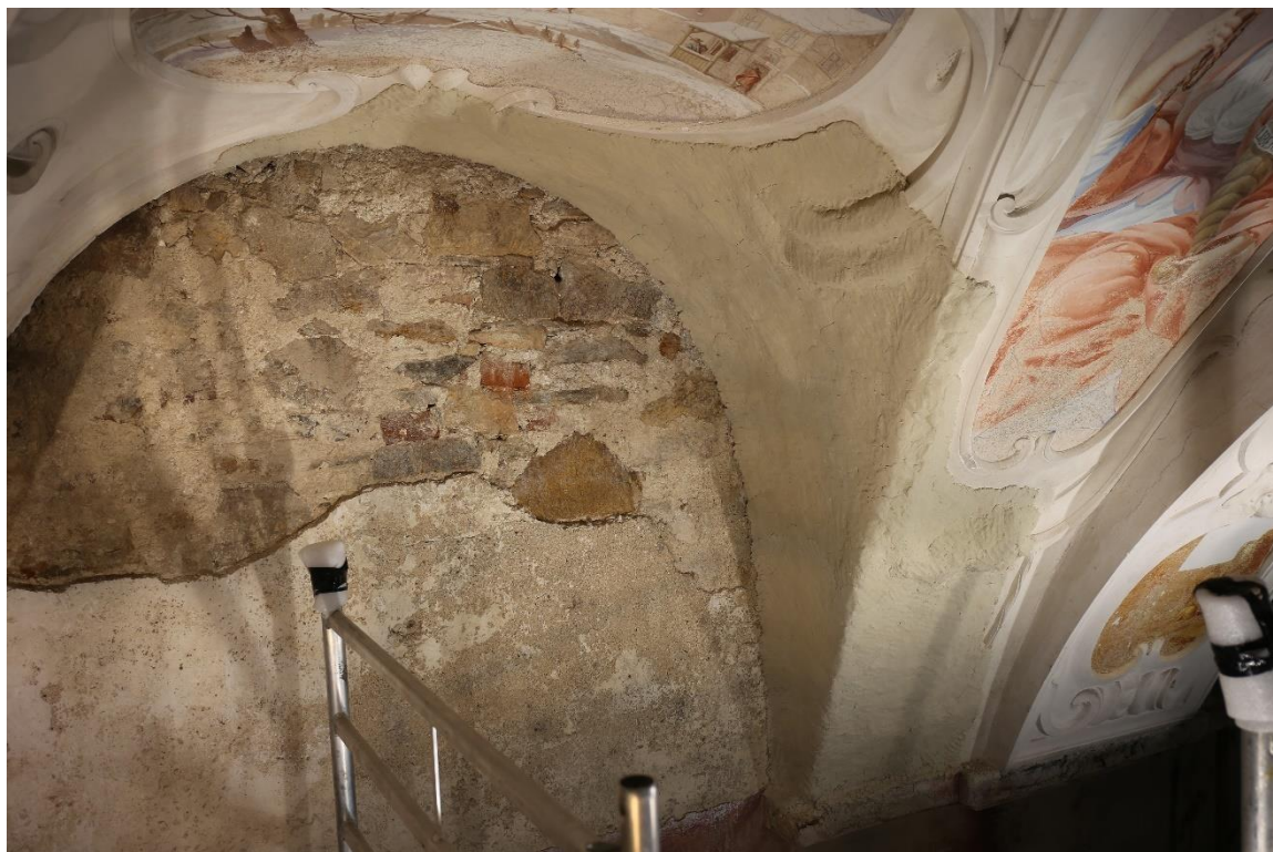
Obrázek 15 Odsolovací zábal
