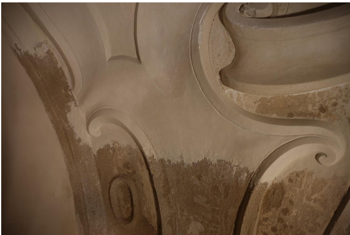
Obrázek 43 Průběh tmelení kartuše na trojboké výseči (jemná finální vrstva)
