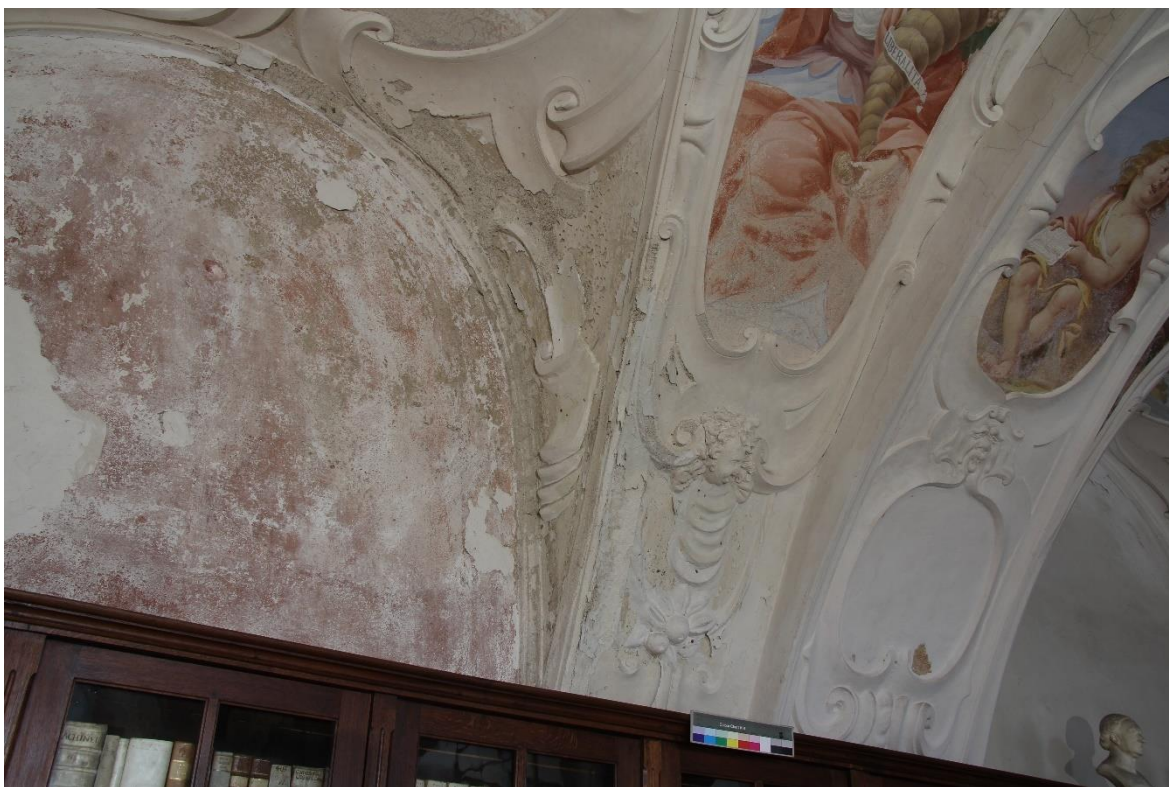
Obrázek 24 Celkový pohled na restaurovanou trojbokou výseč klenebního pasu a klenební pas
