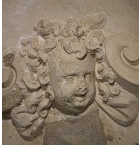
Obrázek 46 Stav po očištění, zpevnění a vyinjektování
