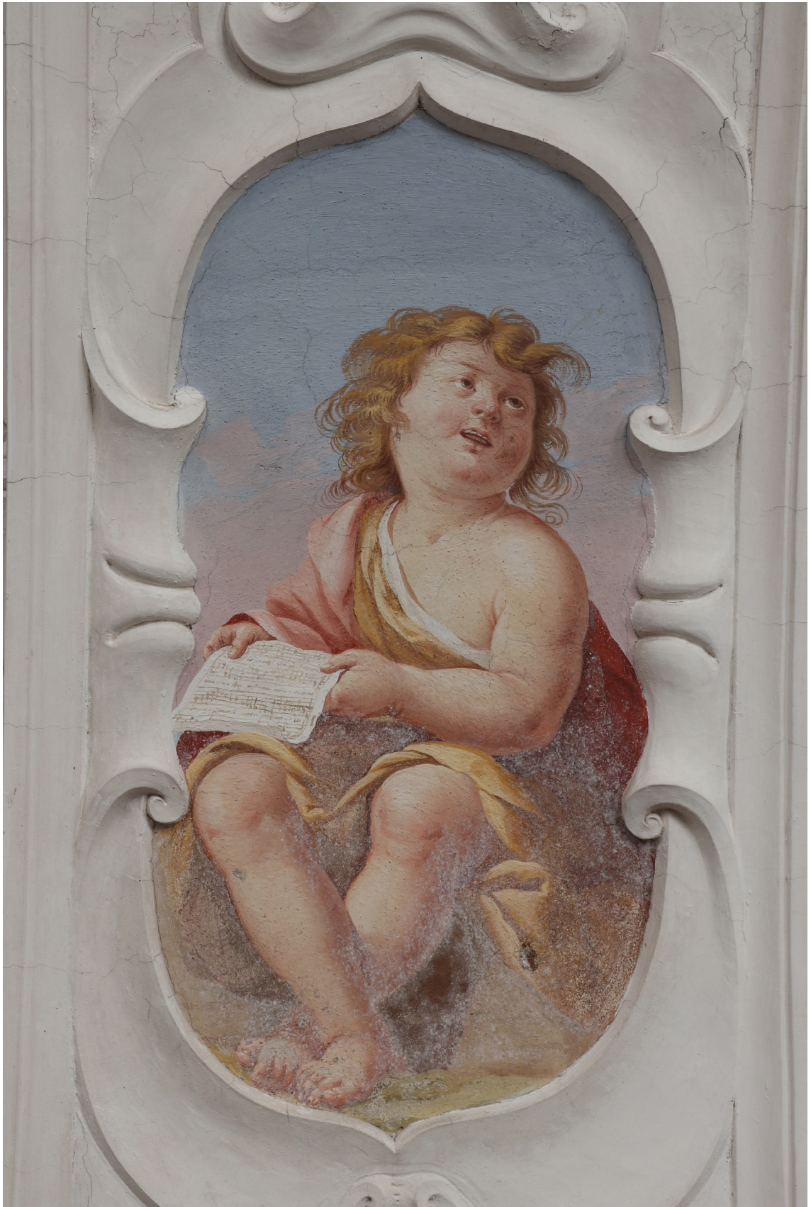
Obr. 03: Celkový pohled na výjev Zpívající putto s notami – Stav před restaurováním.- Na fotografii je badatelné drobné mechanické poškození a dále mikrobiologické napadení pokrý- vající v podobě bílého povlaku spodní část výjevu.
