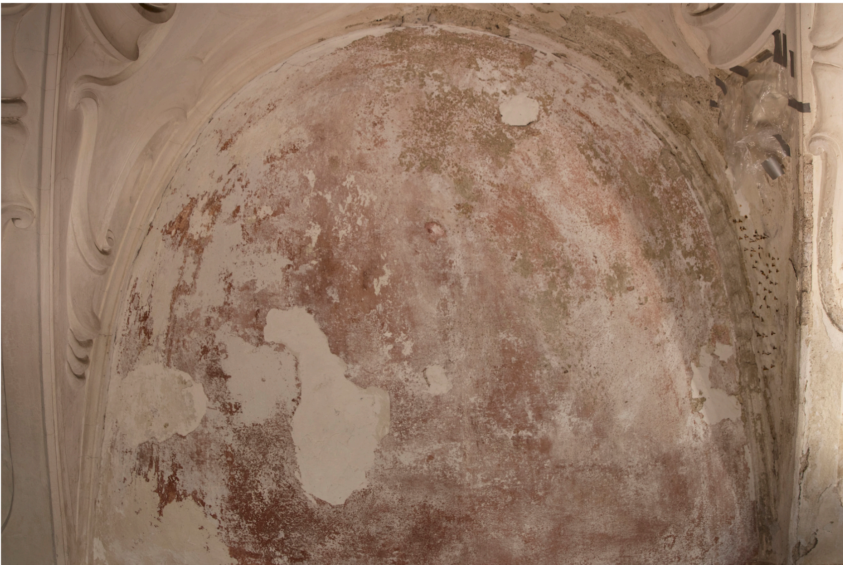
Obr. 13: Pohled na přidělenou lunetu severní stěny na které můžeme pozorovat ztrátu adheze bílé barevné vrstvy a fragmentálně zachovalé iluzivní mramorování v růžové barvě. Dále jsou v horní části viditelné druhotné, zřejmě sádrové tmely. – Stav před restaurováním.
