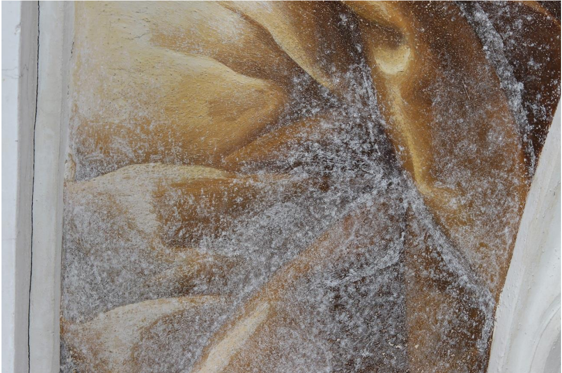
17. Detail výjevu Pokora – zasažení biologickým napadením ve formě bílého povlaku.
