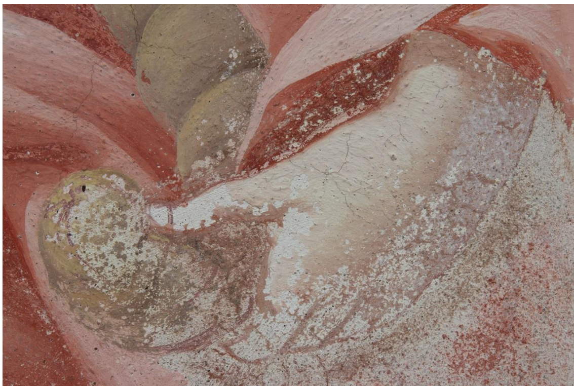
13. Detail výjevu Štědrost – odlupování barevné vrstvy ve formě šupin a odhalování intonaca s podkresbou.
