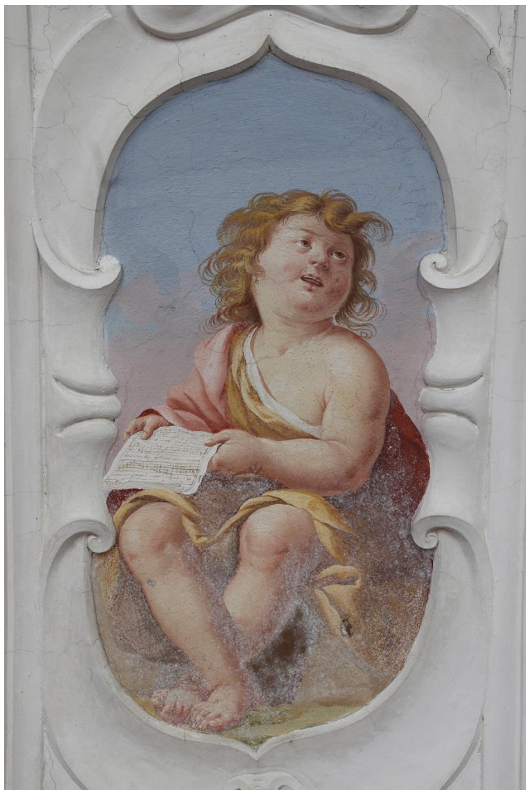
9. Výjev Zpívající putto s notami – zasažení spodní části výjevu biologickým napadením ve formě bílého povlaku.
