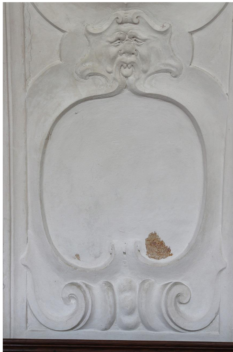
10. Výjev s neznámým motivem – zrcadlo bylo v minulosti překryto bílým nátěrem zřejmě z důvodu silného poškození malby.
