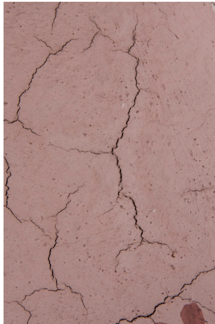
Obr. 43: Zkoušky čištění znečištěných prasklin. Zábál z buničiny Arbocel BC 200 . Stav po čištění.
