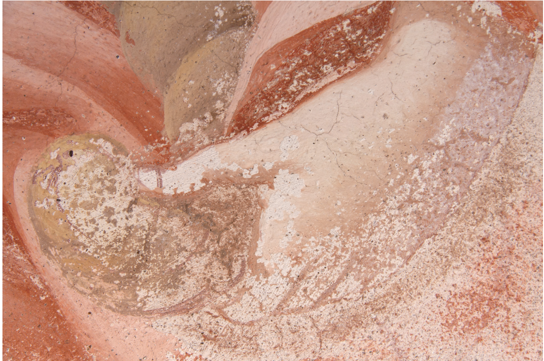
Obr. 20: Detail poškození v oblasti ruky třímající roh hojnosti. Fotografie v rozptýleném denním světle. Můžeme pozorovat různé fenomény poškození, jako jsou například ztráta barevné vrstvy, zpráškovatění a šupinatění barevné vrstvy či biologické napadení. Stav před restaurováním.
