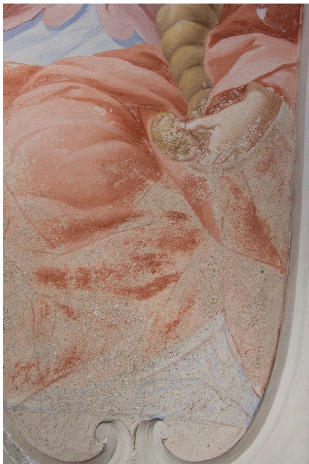
Obr. 64: Sekvence; polocelek. Stav po konsolidaci a očištění.
