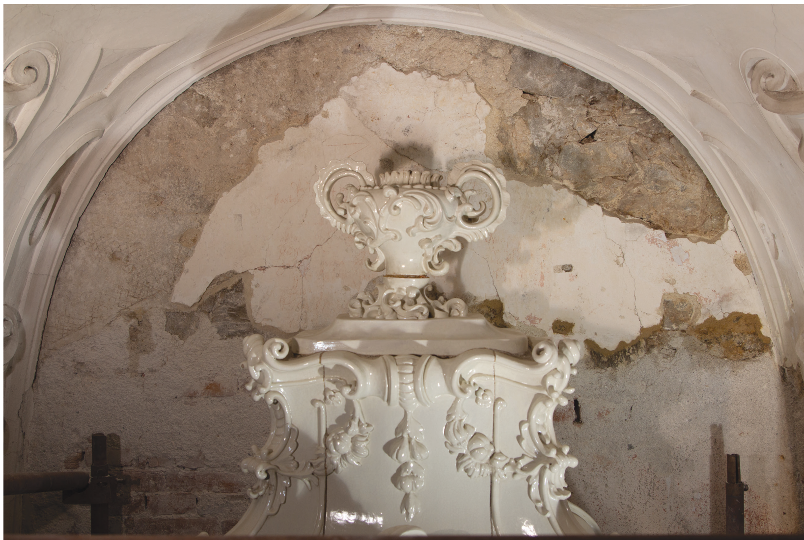
Obr. 45: Celkový pohled na lunetu po očištění a odstranění zcela dožilých nátěrů a omítek.
