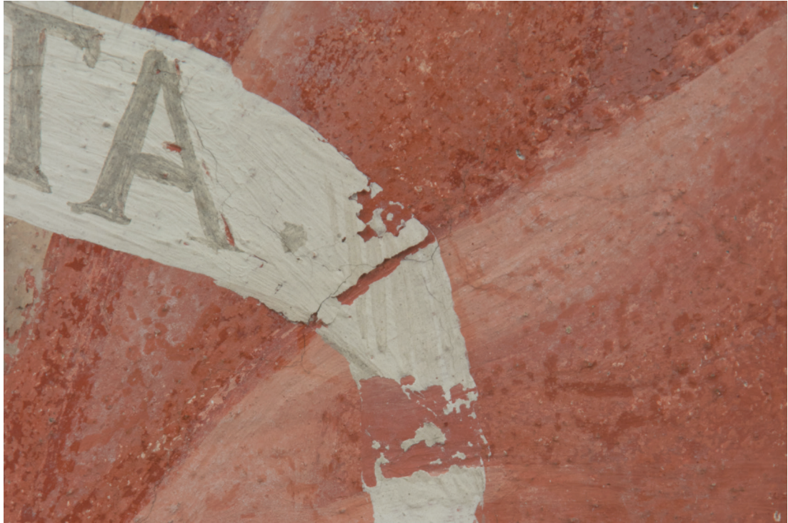
Obr. 18: Detail poškození: ztráta barevné vrstvy a šupinatění barevné vrstvy. Stav před restaurováním.
