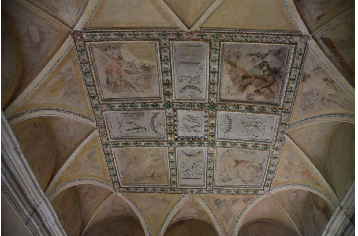
Obr. č. 226 Zrcadlová klenba zdobená štukovými reliéfy a malbou. Rytířský sál zámek Nelabozseves. Foto: Petr Kuneš, 2021
