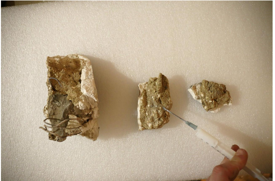
Obr. č. 177 Po odstranění sekundárních tmelů byly zvolněné fragmenty konsolidovány vápennou nanosuspenzí Calosil E25
