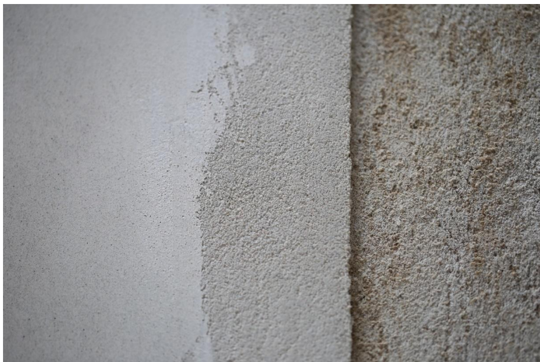
Obr. č. 221 Detail na stratigrafickou výstavbu podkladových omítkových vrstev od arriccio po finální intonachino
