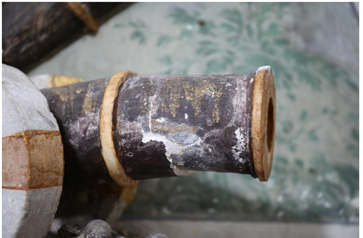
Obr. č. 175 Průběh odstraňování sekundárních zásabů v podobě štukových tmelů zahalujících původní povrch
