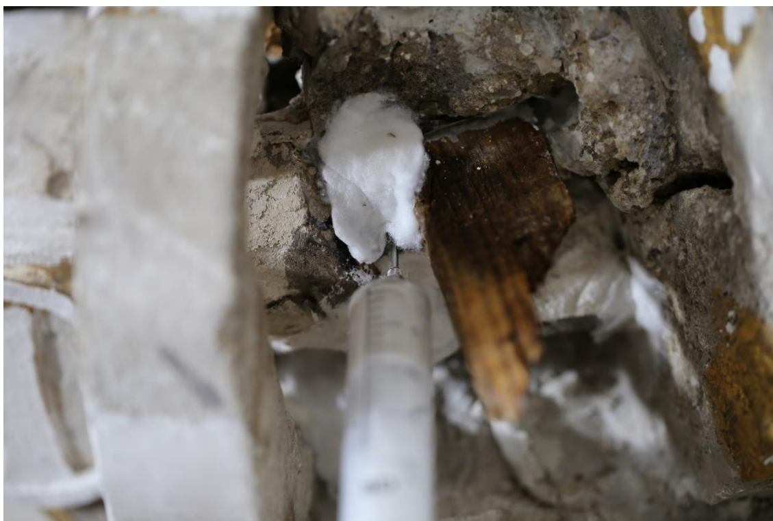
Obr. č. 179 Trhliny ve štukové hmotě byly zpevněny vápennou suspenzí v etanolu CaLoSiL E25 a injektovány injektážní směsí PLM-A
