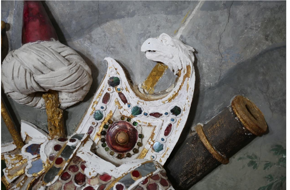
Obr. č. 203 Nanášení podkladu a tmelení chybějících míst na štítě
