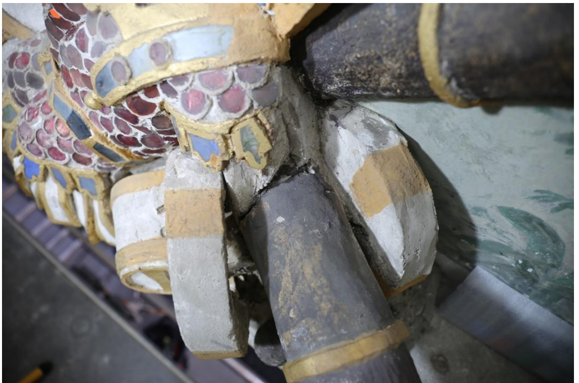
Obr. č. 153 Štuková výzdoba. Kanon jako součást válečné trofeje. Pohled z bora. Stav před restaurováním.
