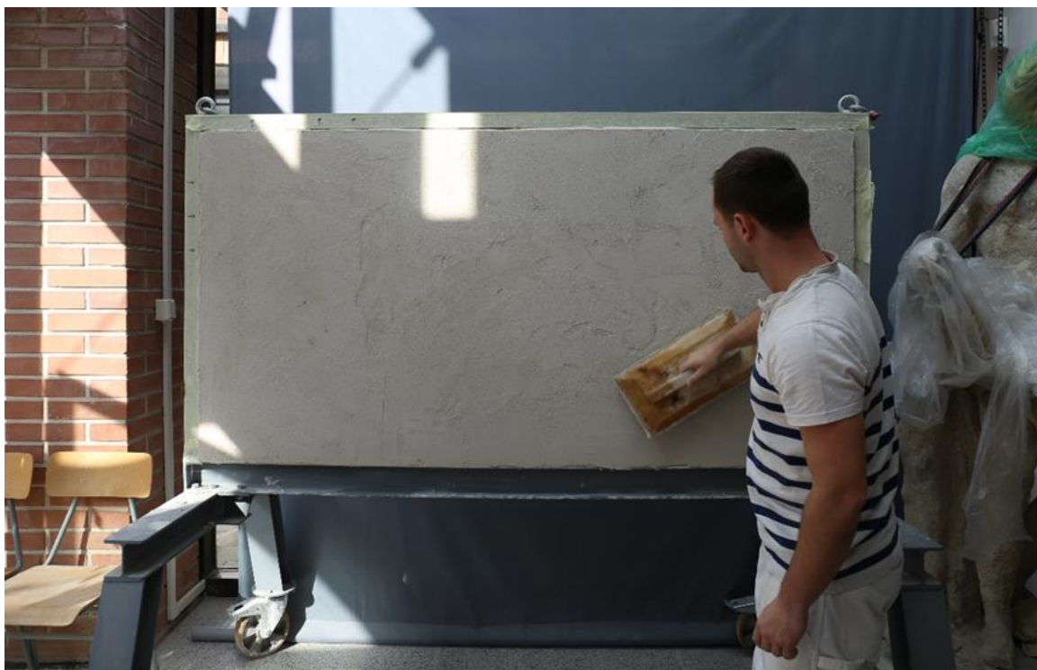
Obr. č. 217 Nanesení a zpracování vrstvy první hrubší vrstvy intonachina dřevěným hladítkem
