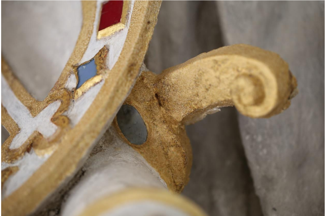
Obr. č. 174 Stav po retuši zřazení na rukověti
