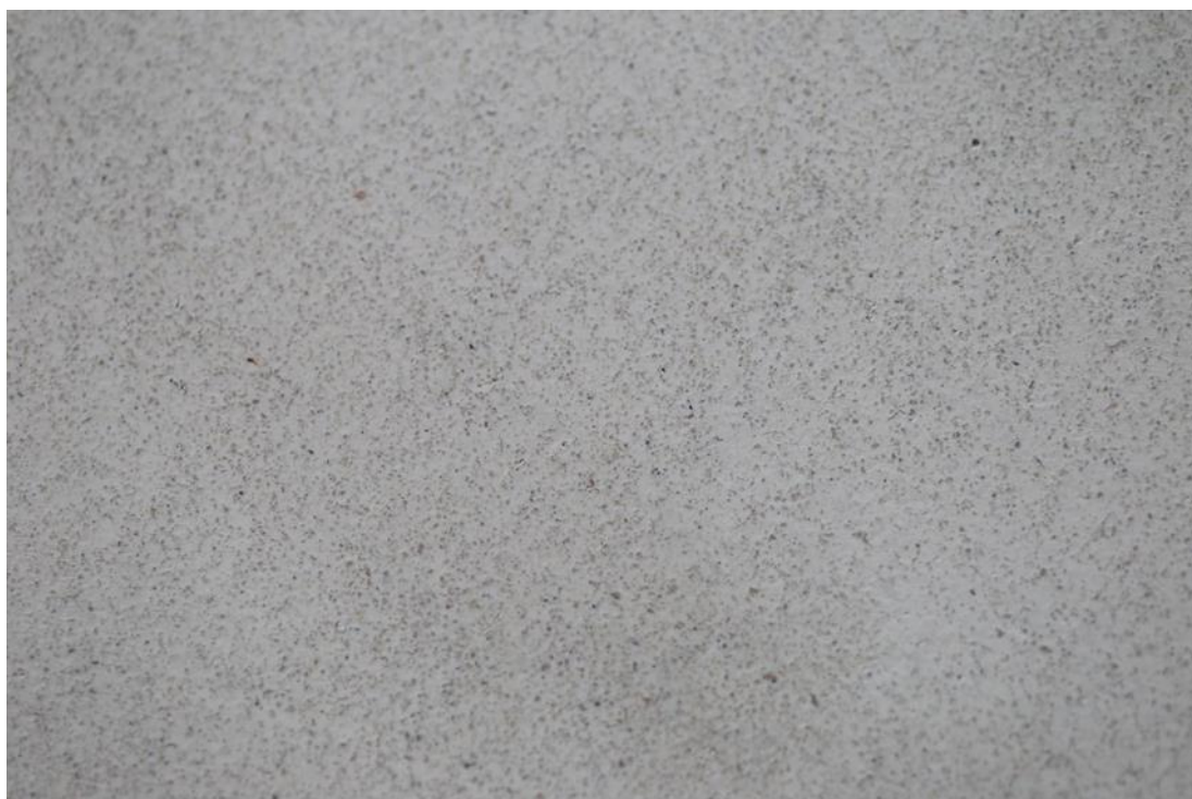
Obr. č. 220 Detail na finální povrch intonachina
