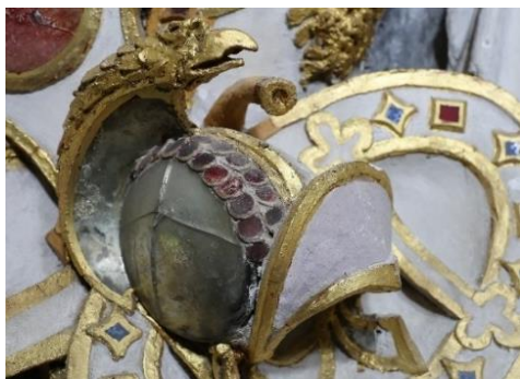
Obr. č. 17 Části měsíčního nebo korunového skla inkrustovaného ve štukové výzdobě, kde se výrazně podílí na hmotě helmice a celkovém výrazu imitujícím helmici ve stylu alla antica zdobené zlatem. Na ploše je patrné mechanické poškození v podobě hvězdicové praskliny sahající až k okrajům skla. Helmice se nachází po pravici plastiky Marta.
