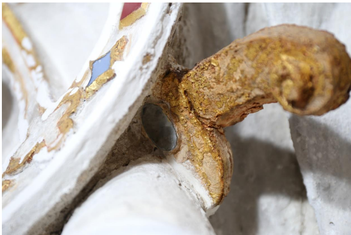
Obr. č. 172 Po dočištění bylo inkrustované sklo navráceno na původní místo a štukový rámeček byl z částí doplněn
