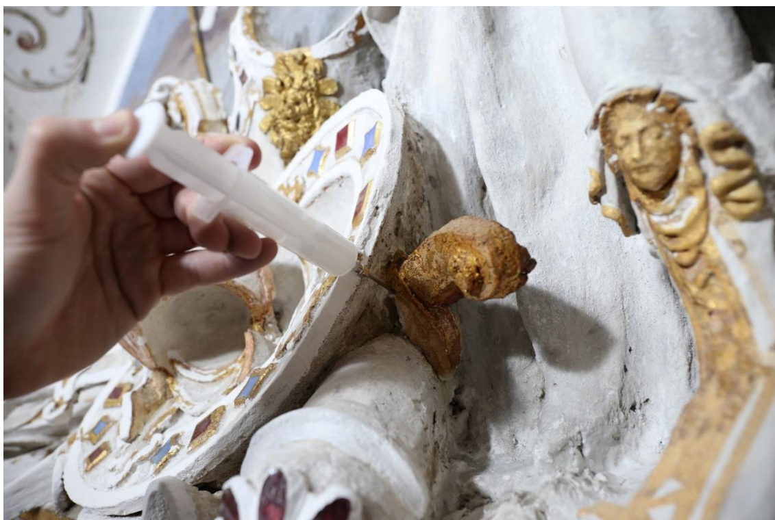
Obr. č. 169 Průběh injecktáže v trhlínách ve štuku injecktážní směsí PLM-A
