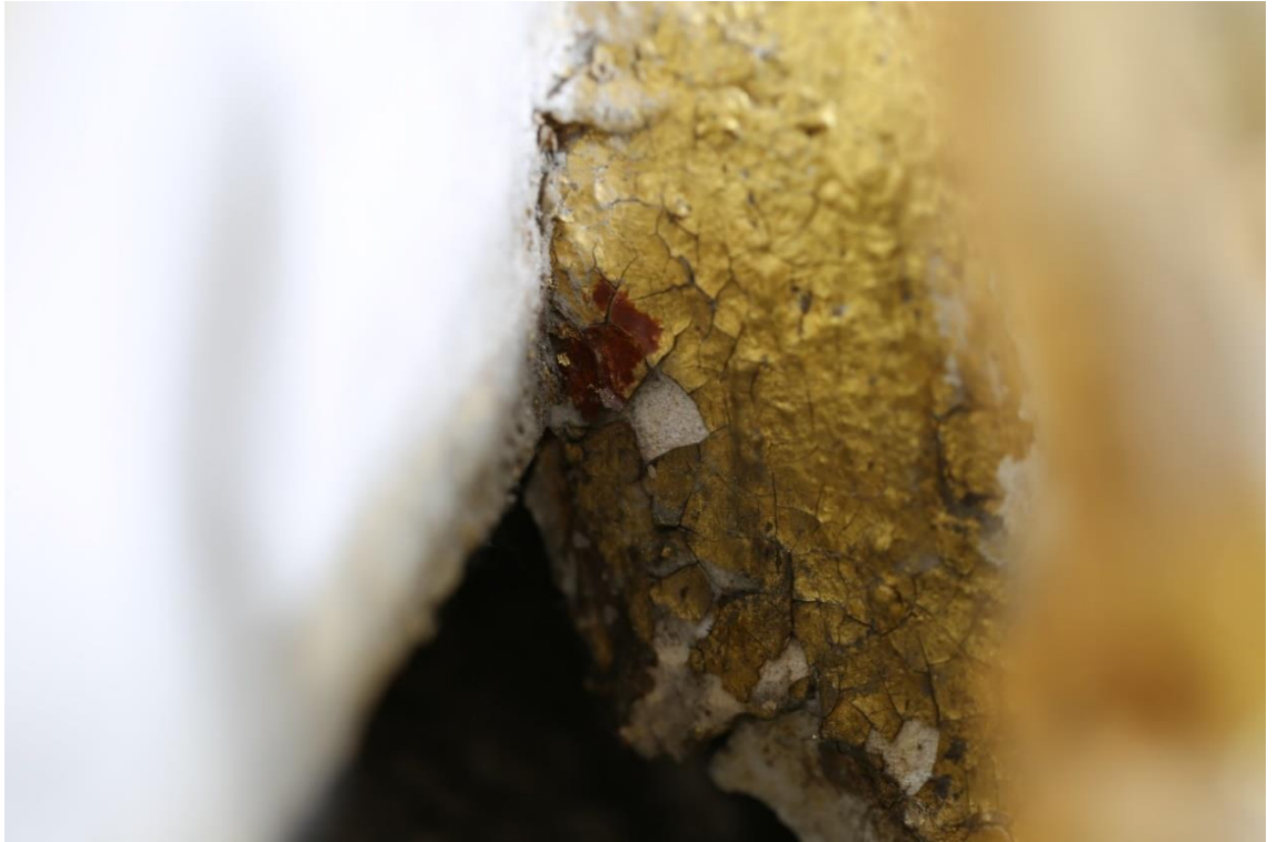
Obr. č. 154 Detail na zkrakelované zlácení v nepohledové části štukové výzdoby – válečné trofeje.
