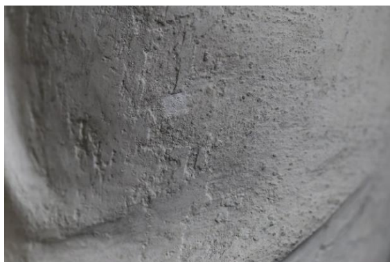
Obr. č. 23 Detail na plášt Diany s patrným mechanickým poškozením povrchu v minulosti
