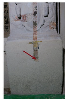
Obr. 7: Detail místa odběru vzorku V7. Zděný sokl pod erbem Rosiny z Vartenberka, opravná malta na cihlovém zdivu.
