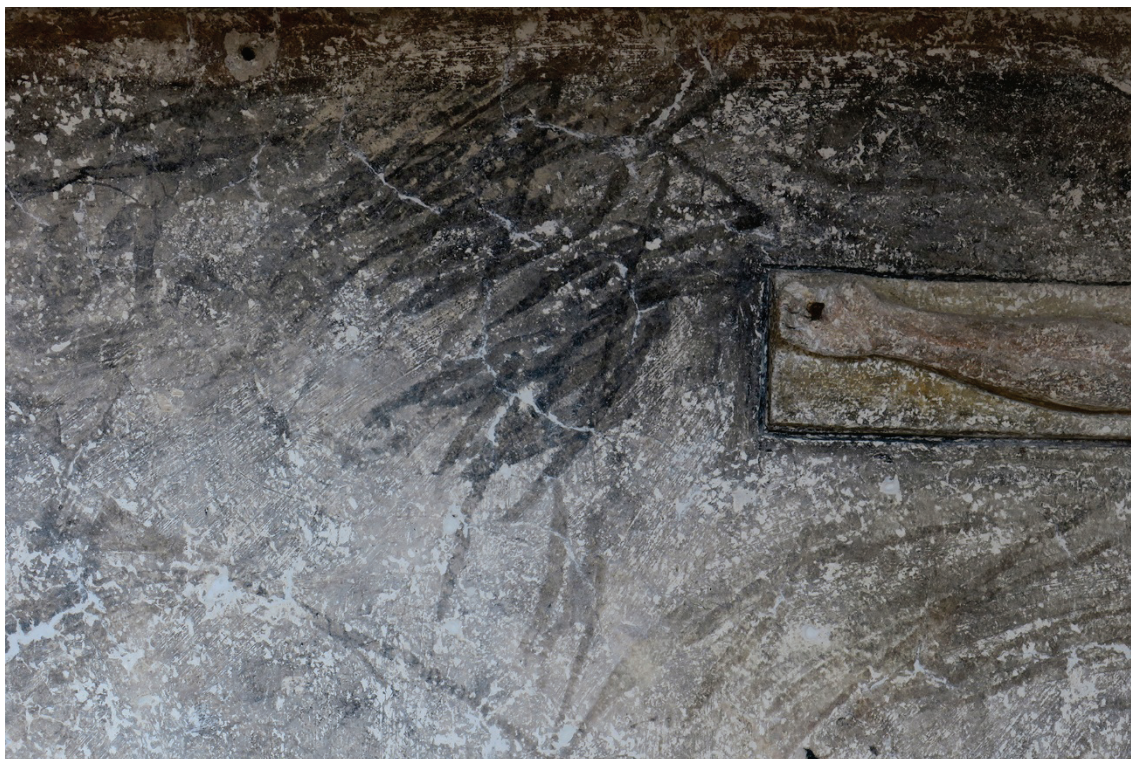
Obr. 12 – výrazné „tahy“ v ploše pozadí centrálního výjevu představující stopy po kletování prasklin v průběhu zrání štukové hmoty
