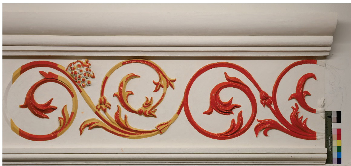
Obr. 65 – štukový dekor, provedení souvrství podkladových vrstev pod zlacení
