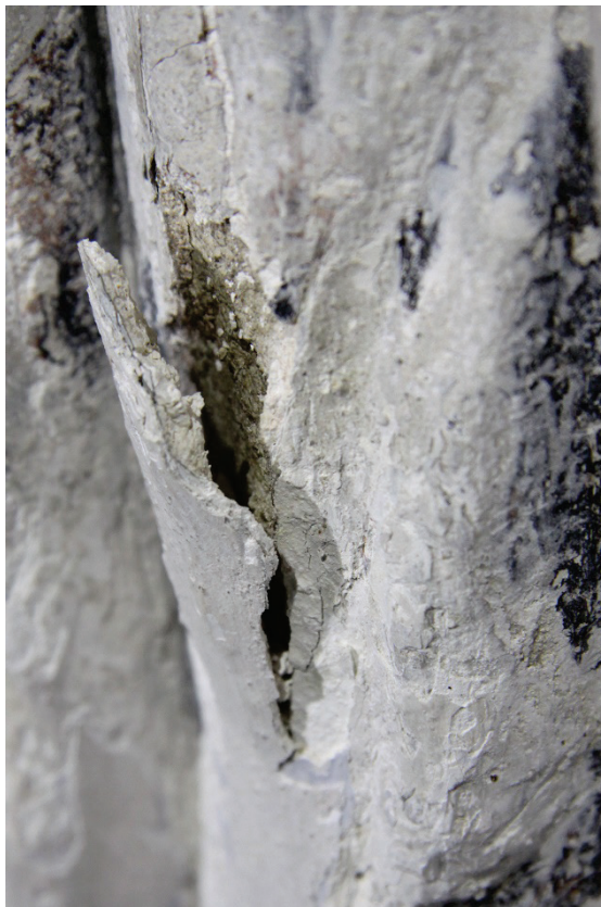
Obr. 17 – popraskaná a uvolněná modelační vrstva štuky s druhotnými vápennými nánosy
