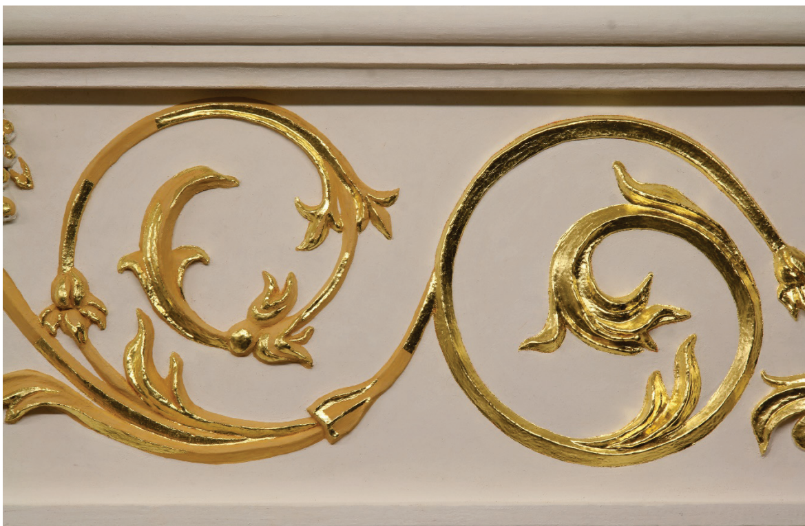
Obr. 67 – detail realizací mordantového (vlevo) a mixtionového zlacení (vpravo)
