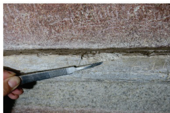
Obr. 12: Detail místa odběru vzorku V9 pro chemicko-technologický průzkum. Konec šály (pentle) Rosiny, tmel s vrstvami druhotných nátěrů.
