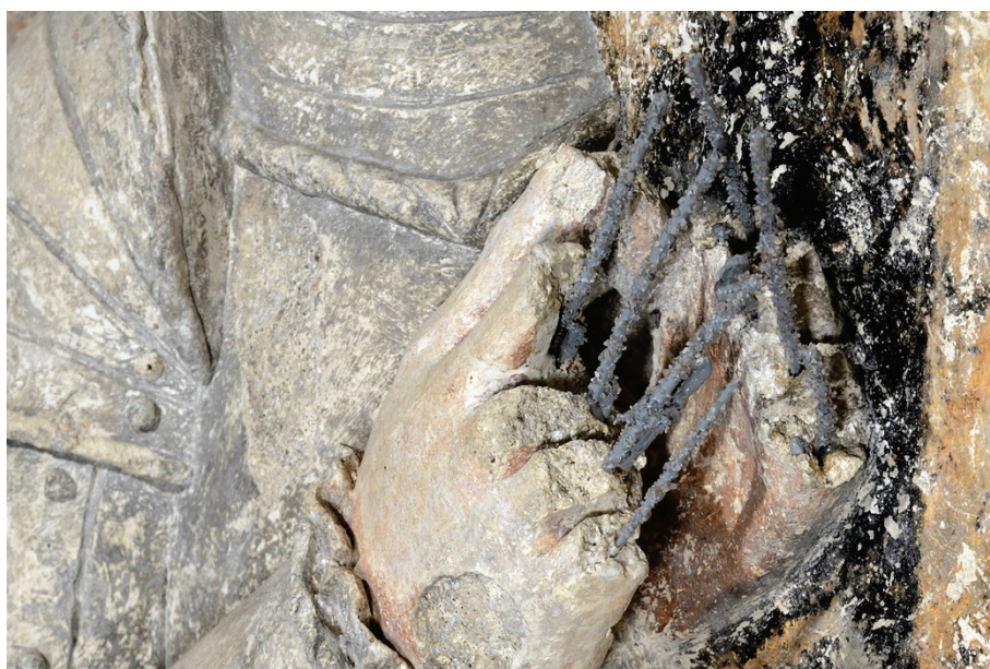
Obr. 22 – osazení nových armatur (detail rukou Jana Hodějovského)
