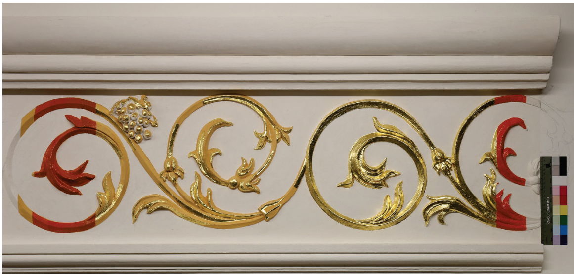
Obr. 66 – realizace mordantového (vlevo) a mixtionového zlacení (vpravo) s analytickou výstavbou vrstev
