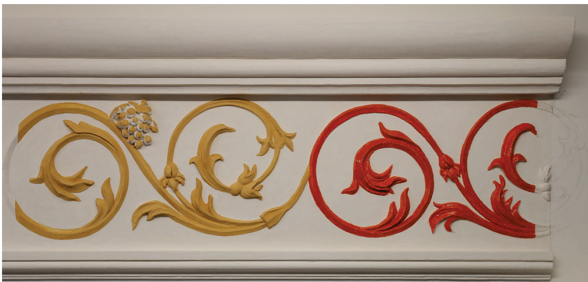
Obr. 64 – štukový dekor, okrová podmalba (vlevo) a první vrstva probarvené mixtionové vrstvy (vpravo)
