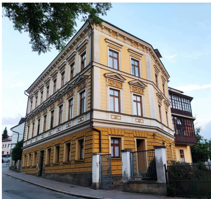
Obrázek 28 – Barevna Josefa Jankeho v Husově čp. 126, pohled na zadní stranu budovy. Současný stav. 733
