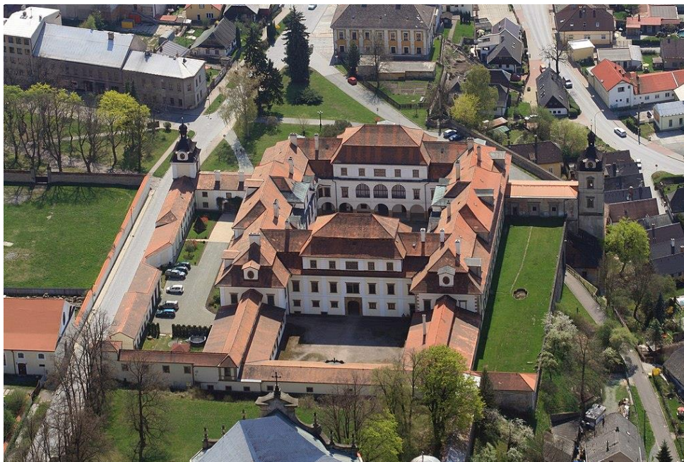
Obr. 6: Zámek Rychnov nad Kněžnou, letecký pohled, současný stav a doklad existence původních dvou nádvoří.
