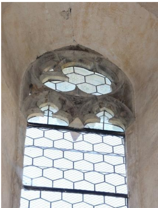
Pohled, kostel sv. Ondřeje, kamenná kružba severního okna v presbytáři.
