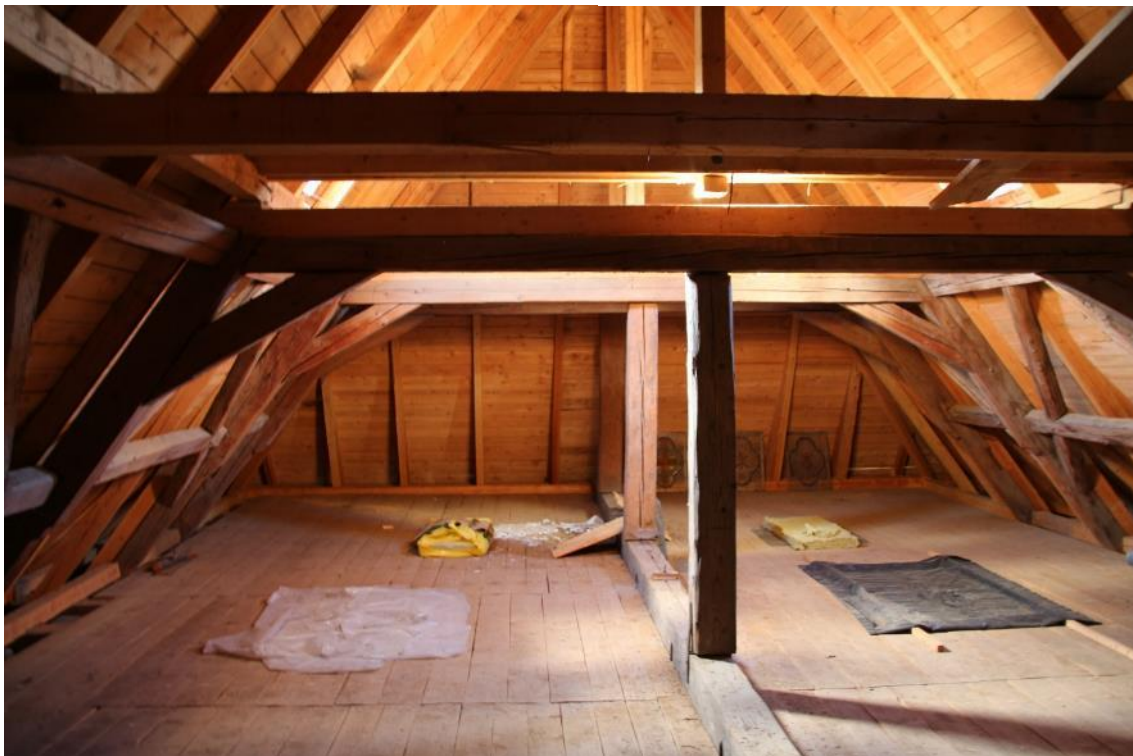
Velká Losenice, kostel sv. Jakuba, hambalkový krov s dvojitou ležatou stolicí.
