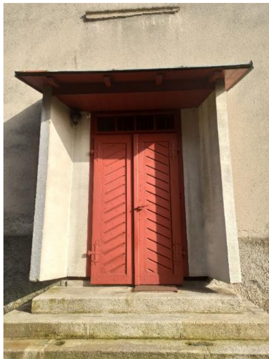
Nížkov, kostel sv. Mikuláše, hlavní vchod v západním průčelí kostela.
