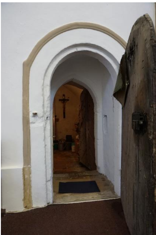
Nížkov, kostel sv. Mikuláše, průchod z presbytáře do přízemí věže.
