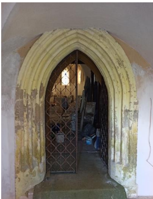
Krucemburk, kostel sv. Mikuláše, portál hlavního vstupu v západním průčelí lodi.
