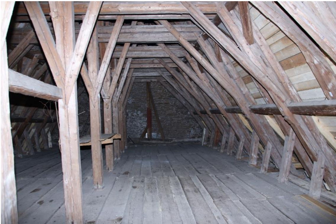
Polná, kostel sv. Kateřiny, krov kostela nad lodí je pozoruhodnou kombinací středověkého typu krovu s centrální podélnou stolicí a krovu s pokročilejšími ležatými stolicemi.
