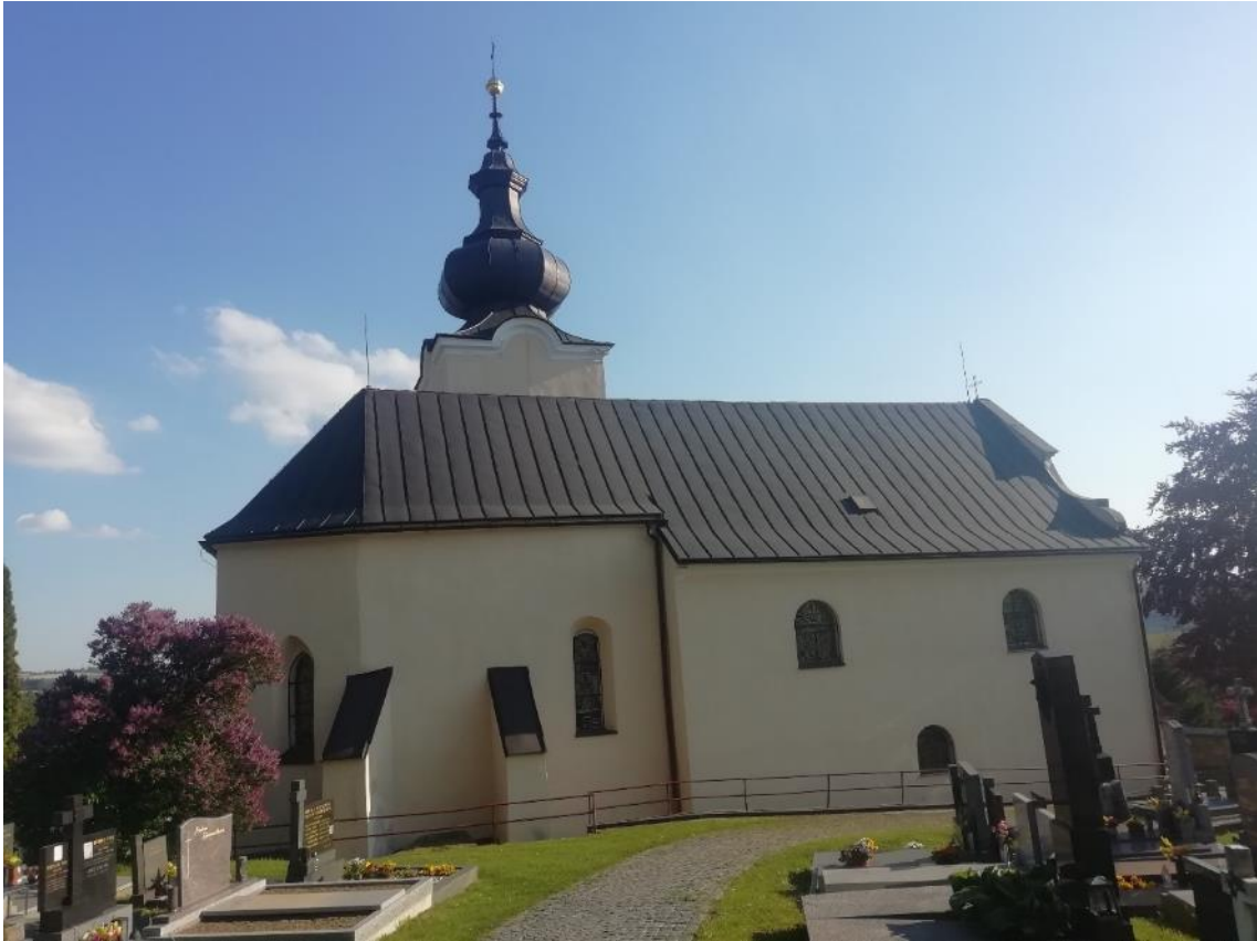
Krucemburk, kostel sv. Mikuláše, pohled na kostel ze severu.
