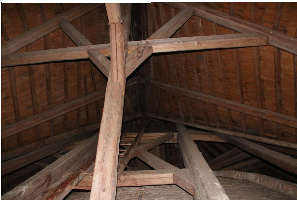
Pohled, kostel sv. Anny, sloupek v krovu nad jižním křídlem. V pozadí krov nad kopulí.
