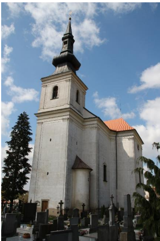
Polná, kostel sv. Barbory, věž kostela z východu.
