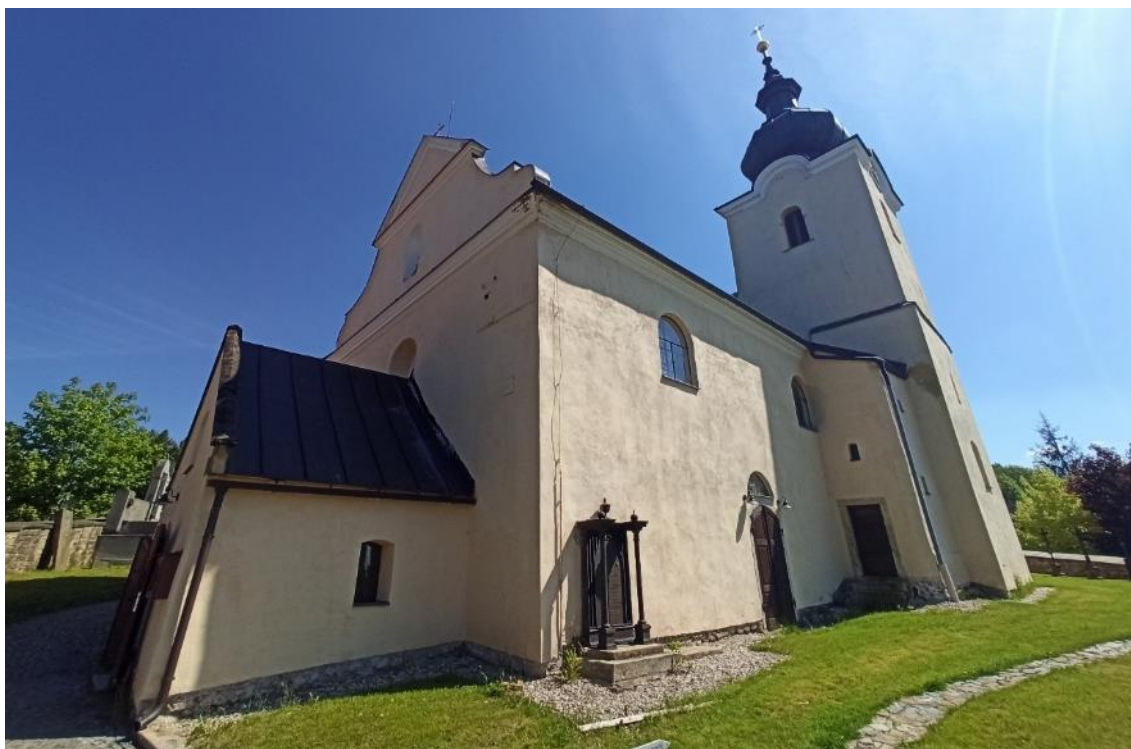
Kruceburk, kostel sv. Mikuláše, pohled na kostel od jihozápadu.
