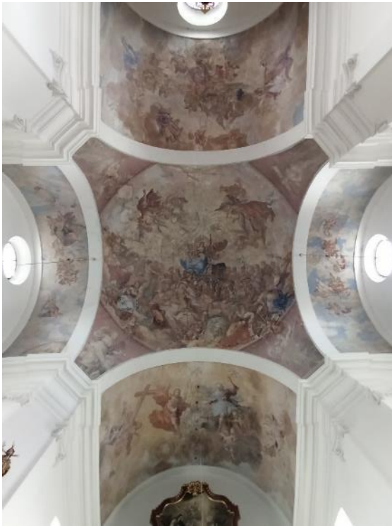
Polná, kostel sv. Barbory, klenba nad křížením.
