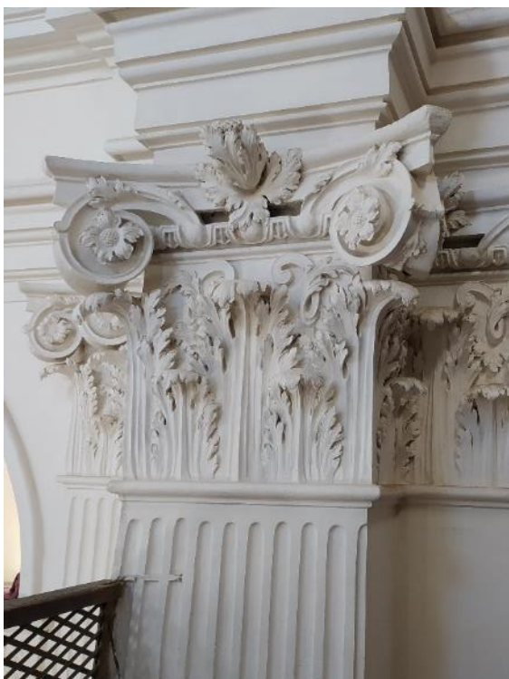
Polná, kostel Nanebevzetí Panny Marie, kompozitní hlavice pilíře.
