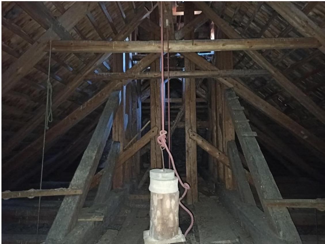
Dlouhá Ves, kostel sv. Mikuláše, hambalkový krov lodi s ondřejskými kříži a s konstrukcí věžičky.
