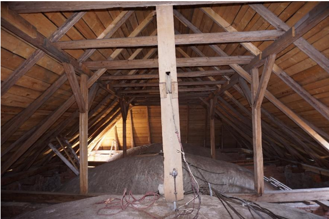
Nížkov, kostel sv. Mikuláše, hambalkový krov kostela s dvojitou stojatou stolicí.
