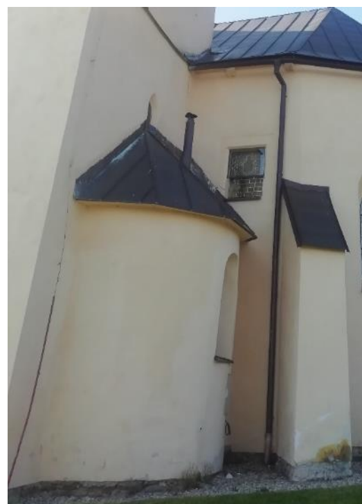
Krucemburk, kostel sv. Mikuláše, pohled na apsidu u východní stěny věže.
