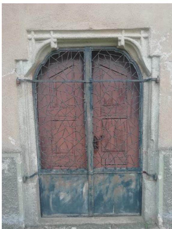
Dlouhá Ves, kostel sv. Mikuláše, sedlový profilovaný portál v západním průčelí.
