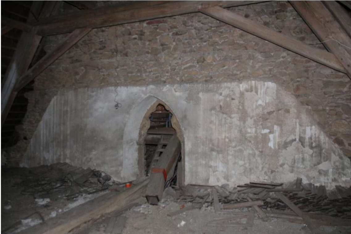
Havlíčková Borová, kostel sv. Víta, pohled na vnitřní líc západní stěny lodi s gotickým oknem a omítkou po původním vyvýšeném stropu lodi.
