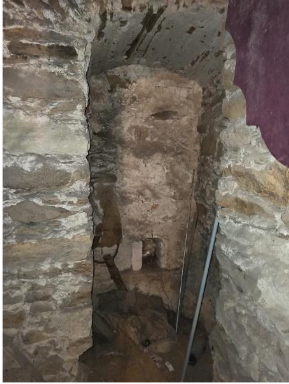
Nížkov, kostel sv. Mikuláše, výklenek původního vstupu do věže v severozápadním rohu prvního patra.
