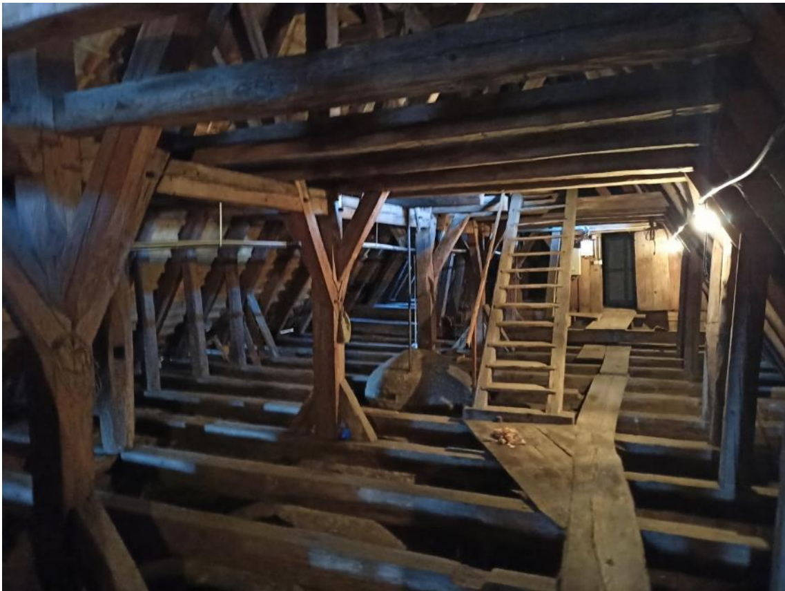
Pohled, kostel sv. Ondřeje, hambalkový krov se středním sloupkem nad lodí kostela.
