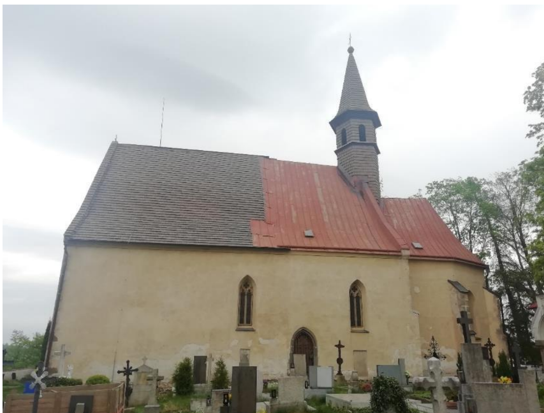
Polná, kostel sv. Kateřiny, pohled z jihu, stav střechy z května 2020.
