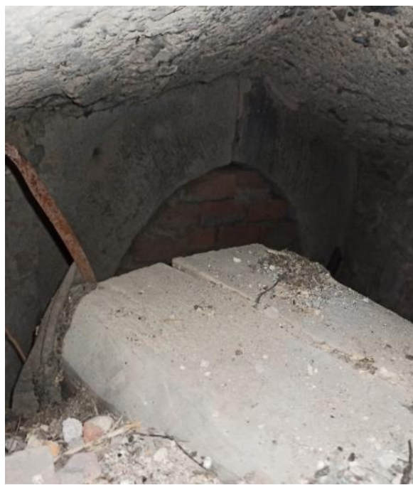
Krucemburk, kostel sv. Mikuláše, zazděný otvor původního vstupu do patra věže.
