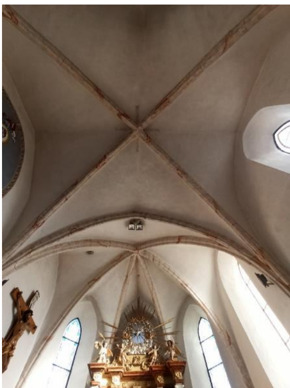
Velká Losenice, kostel sv. Jakuba, žebrová klenba presbytáře.
