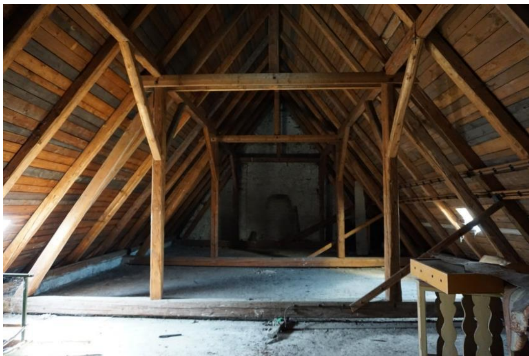
Žižkovo Pole, kostel sv. Michala, vaznicový krov nad lodí, pohled směrem k západnímu průčelí, v pozadí rub niky.
