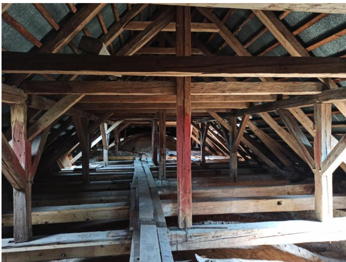
Sopoty, kostel Navštívení Panny Marie, hambálkový krov se stojatou stolicí a věšadlem.
