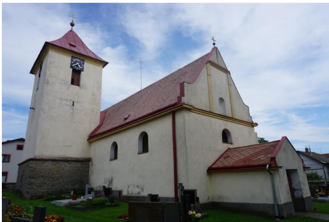
Žižkovo Pole, kostel sv. Michala, pohled na kostel ze severozápadu.
