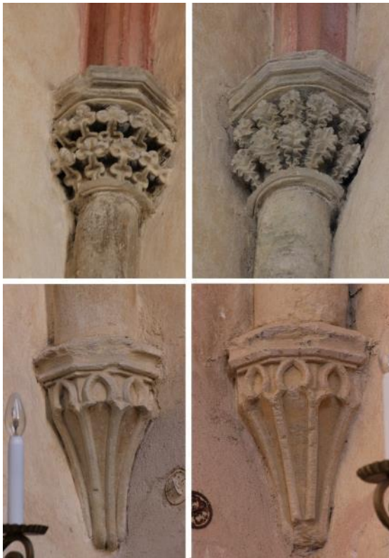
Pohled, kostel sv. Ondřeje, hlavice a konzoly přípor křížové klenby v presbytáři.
