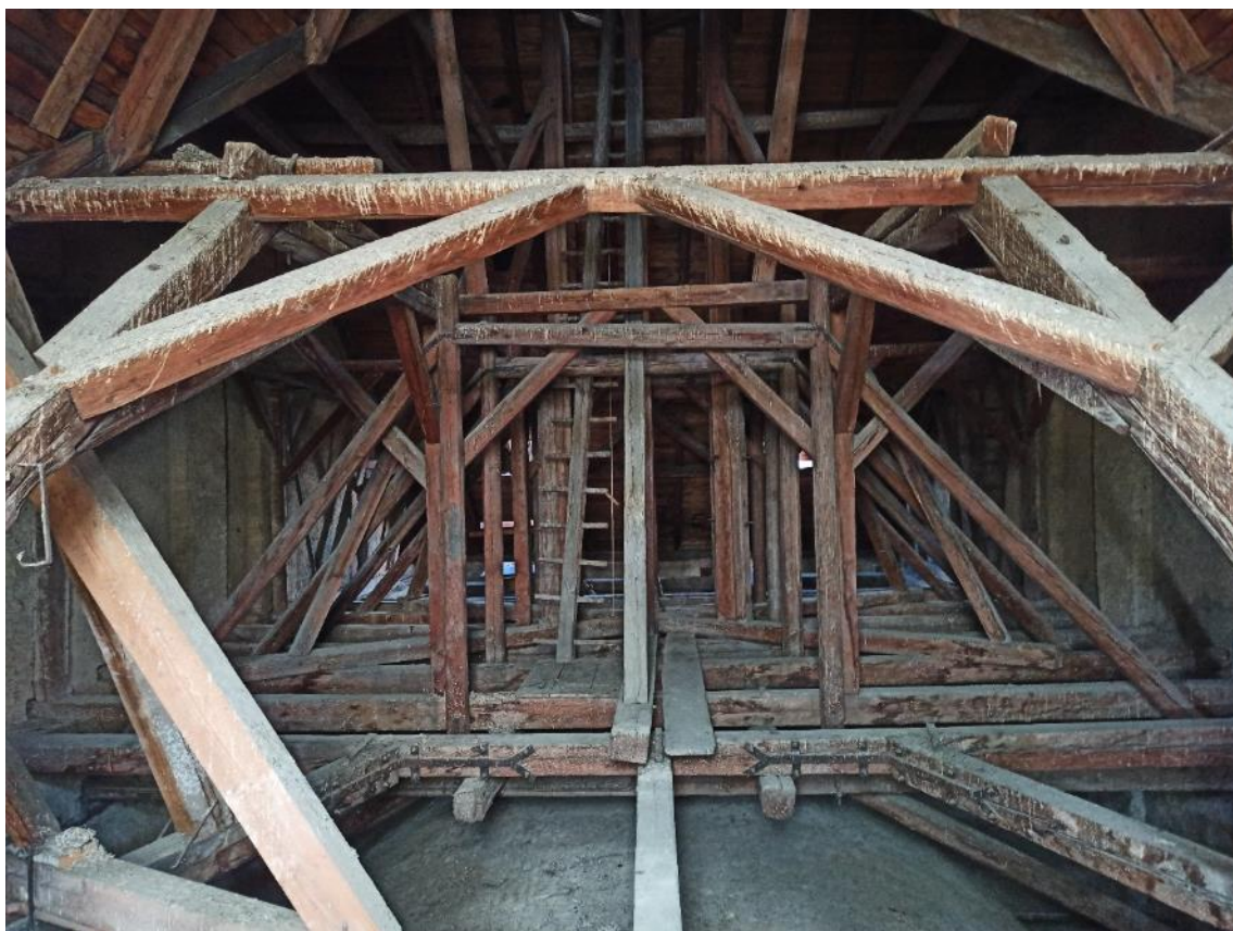
Polná, kostel sv. Anny, hambalkový krov kostela se stojatou stolicí a šikmými sloupky/vzpěrami.
