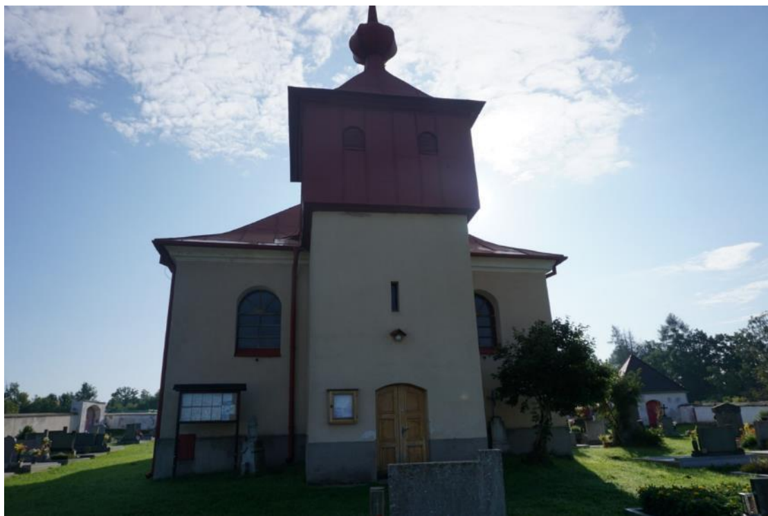
Stříbrné Hory, kostel sv. Kateřiny, západní pohled na věž.
