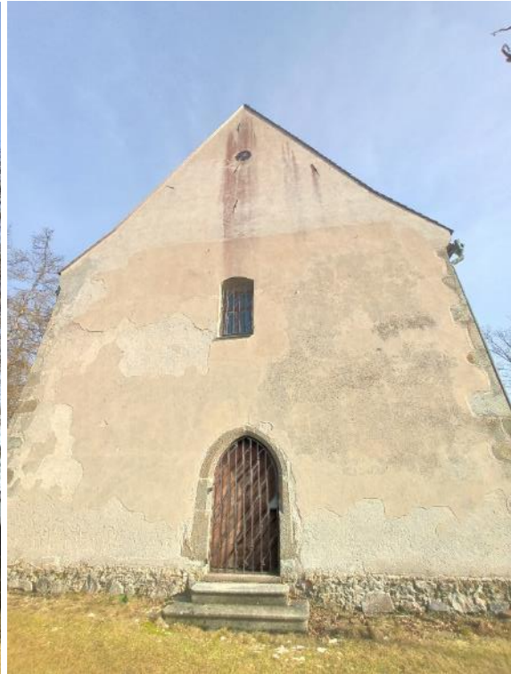
Polná, kostel sv. Kateřiny, pohled na západní průčelí lodi.
