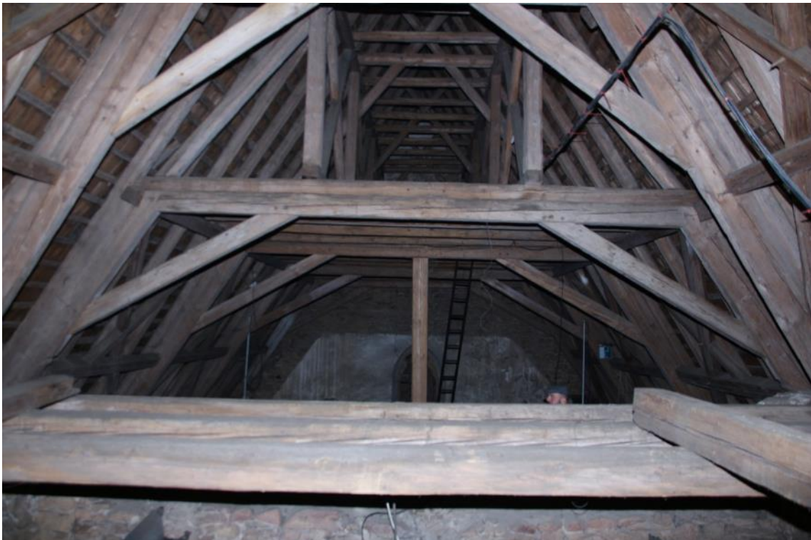
Havlíčková Borová, kostel sv. Víta, dvouúrovňový hambalkový krov kostela s ležatou a stojatou stolicí.
