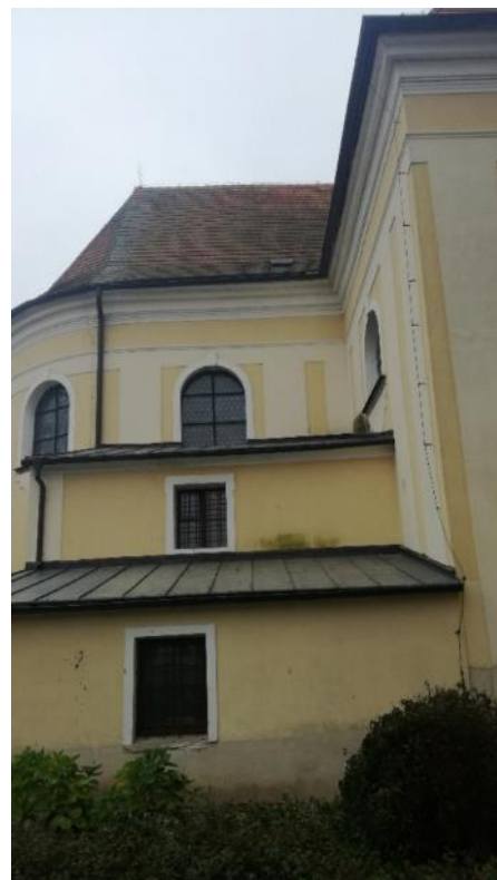
Příbyslav, kostel Narození sv. Jana Křtitele, pohled na sakristii na severní straně kostela.
