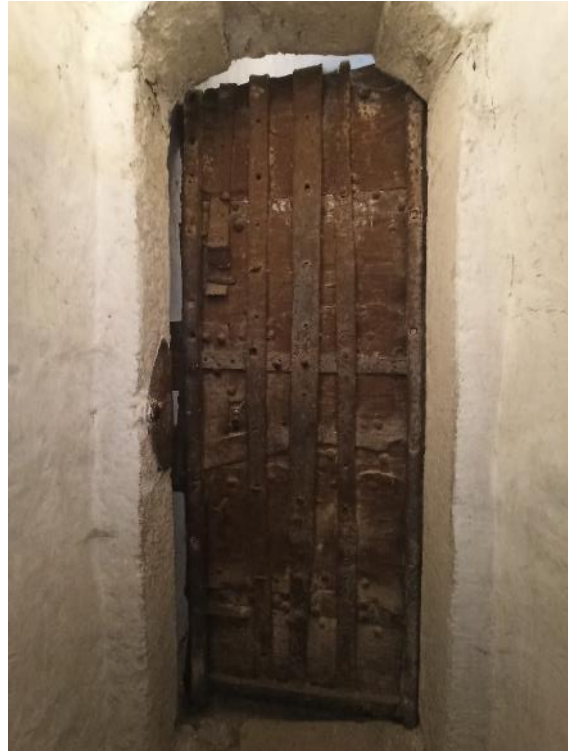
Velká Losenice, kostel sv. Jakuba, sedlový portálek s železnými dveřmi v patře věže.
