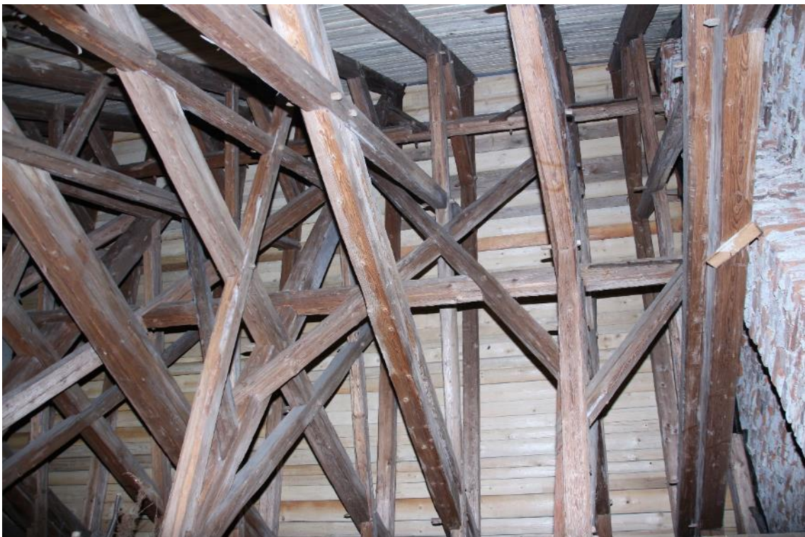
Polná, kostel sv. Kateřiny, propletení dvou různých plných vazeb krovu u západního štítu.
