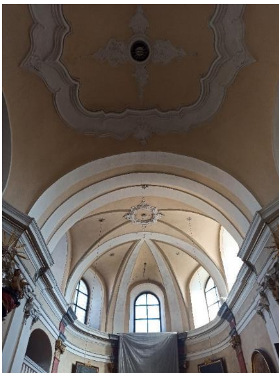
Přibyslav, kostel Narození sv. Jana Křtitele, placková klenba nad křížením a klenba presbytáře.
