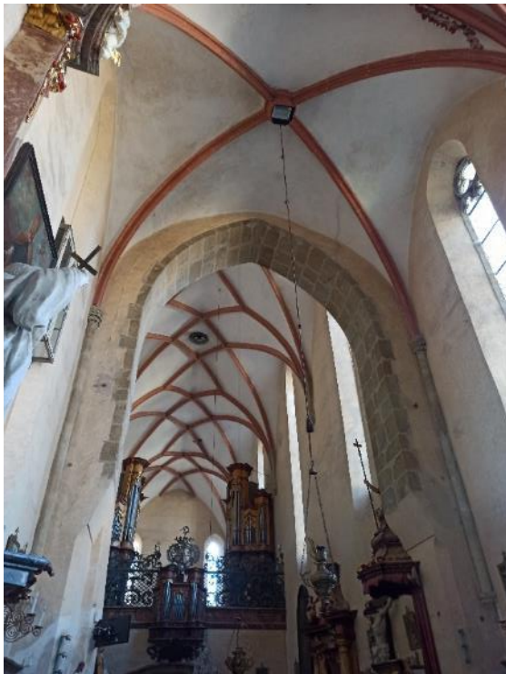
Pohled, kostel sv. Ondřeje, křížová klenba presbytáře s příporami a vítězný oblouk.
