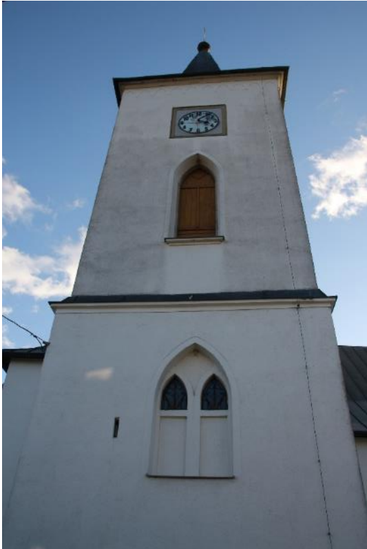
Velká Losenice, kostel sv. Jakuba, věž kostela ze severu.
