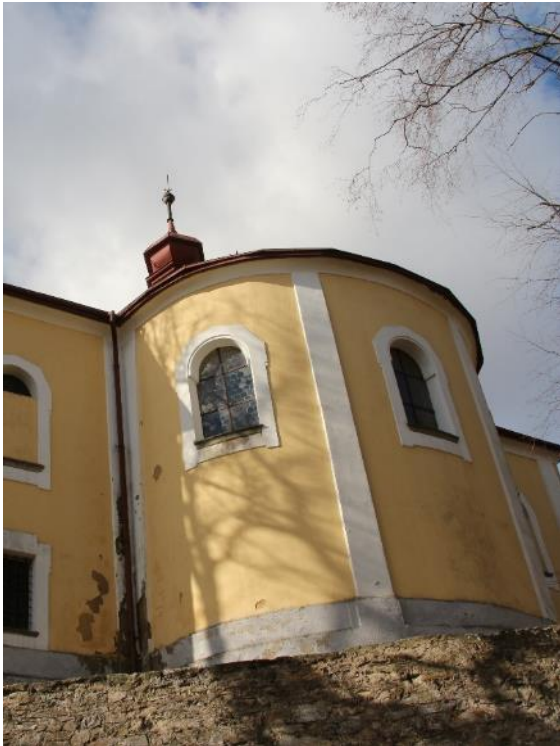
Sopoty, kostel Navštívení Panny Marie, pohled na závěr presbytáře z východu.
