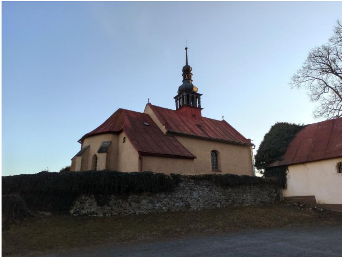
Dlouhá Ves, kostel sv. Mikuláše, pohled na kostel ze severu.
