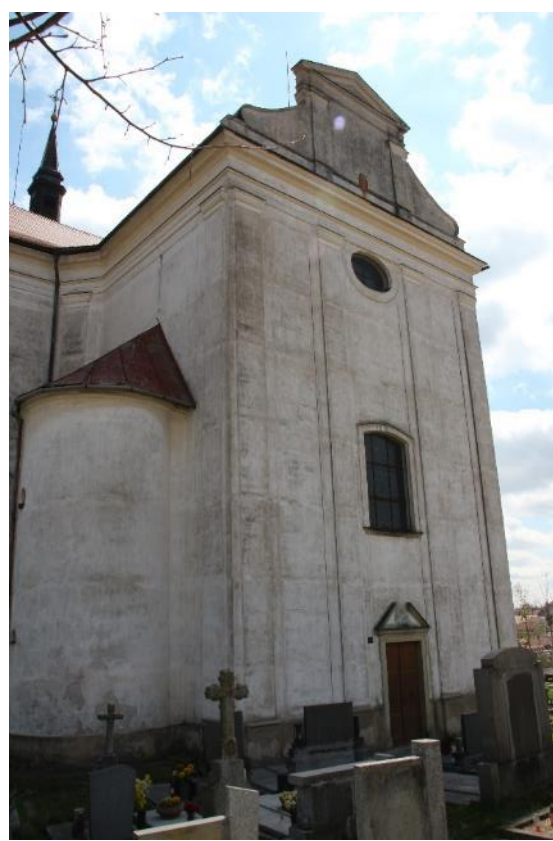
Polná, kostel sv. Barbory, pohled na západní průčelí kostela.
