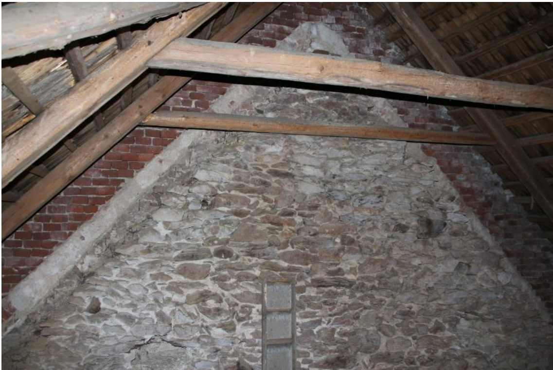
Dlouhá Ves, kostel sv. Mikuláše, pohled na západní štít z lomového kamene v podkroví s původním omítnutým cihelným okrajem.
