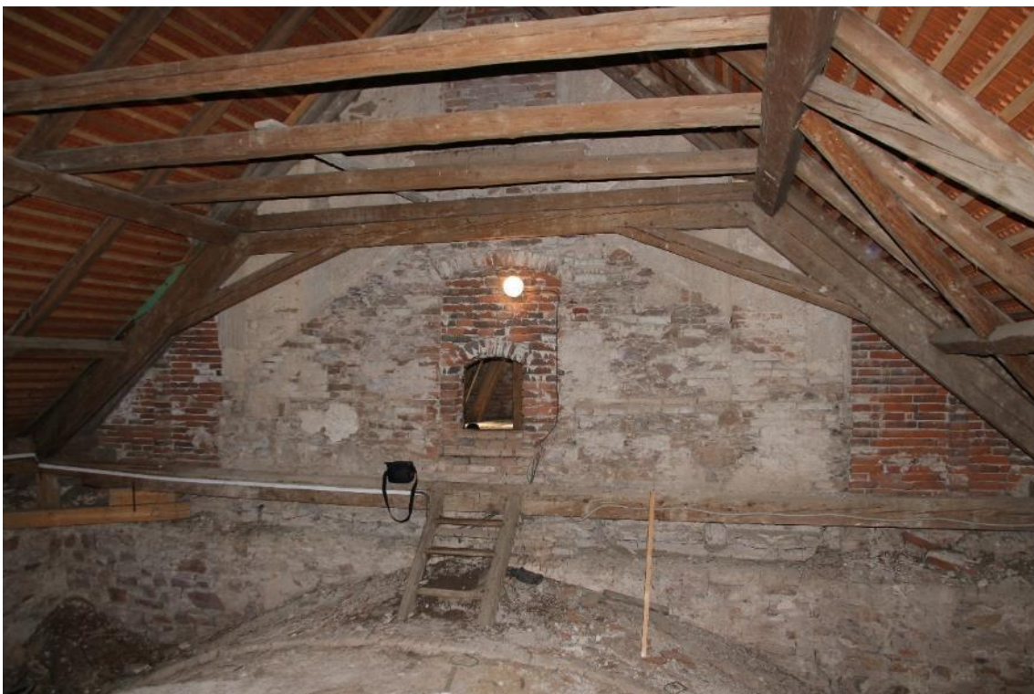
Polná, kostel sv. Barbory, východní zeď lodi s průlezem do podkroví. V omítce zřetelný původní spád střechy a pod hřebenem zazděné západní okno věže.
