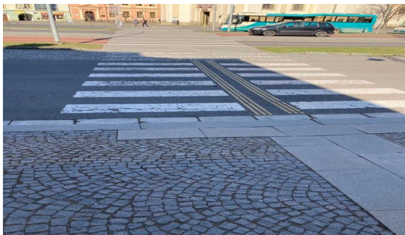
Obrázek 16: Přechody pro chodce – místní komunikace, silnice I/17, autobusové nádraží
