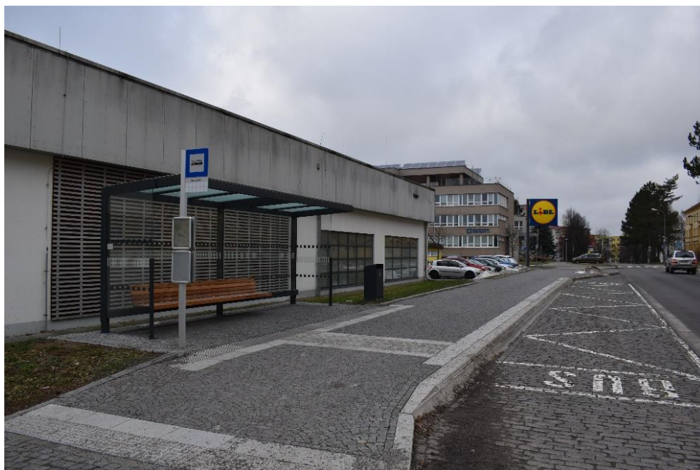
Obrázek 8 Správná úprava zastávky Studentská
