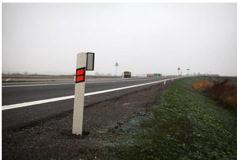
Obrázek 15 Nově instalované směrové sloupky s optickými zradidly u silnice II/322
