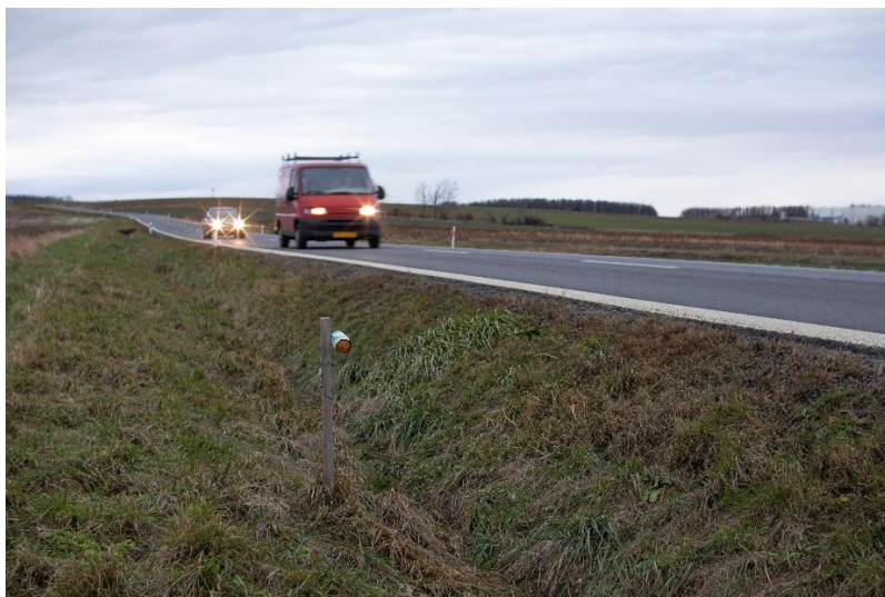
Obrázek 16 Pachový ohradník podél silnice I/36 u Časů
