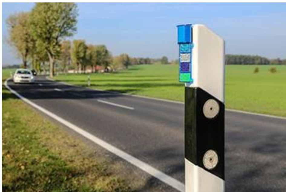
Obrázek 20 Zařízení Multi-Wildschutz-Warnet umístěné na směrovém sloupku v Německu
