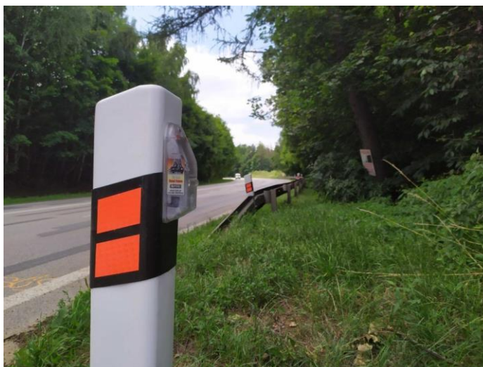
Obrázek 19 Zařízení DeerDeter instalované na směrovém sloupku
